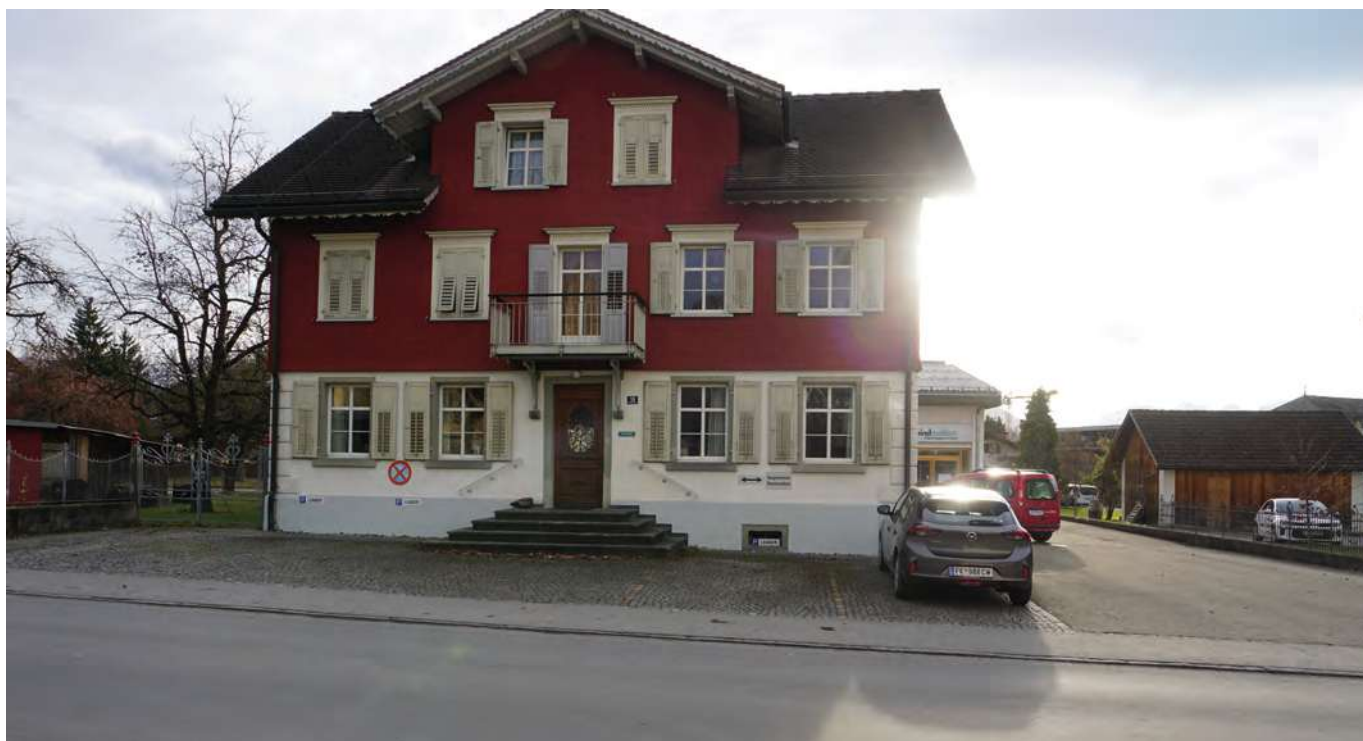
Abb. 41 | Foto Bauplatz von gegenüberliegender Straßenseite
