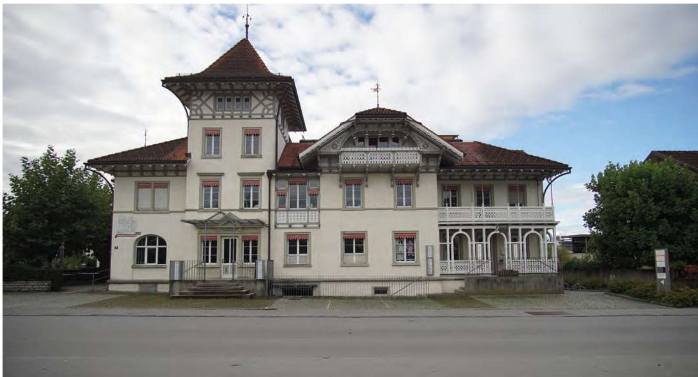
Abb. 39 | Foto Bauplatz von gegenüberliegender Straßenseite
