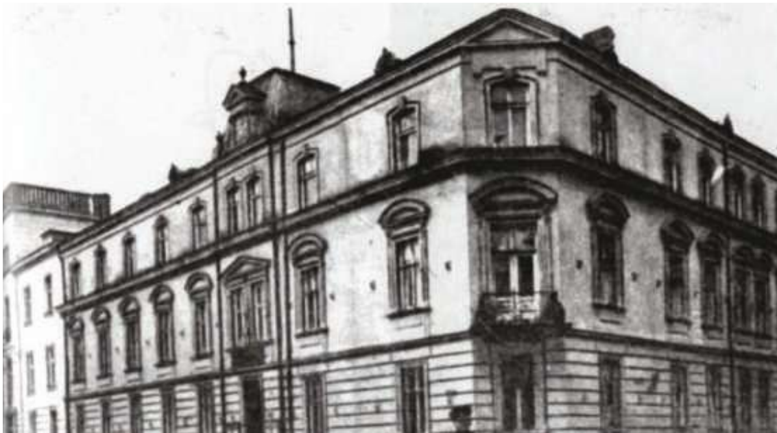
Das Gebäude in „Gurko“- Straße Nr. 1 Abb. 28
