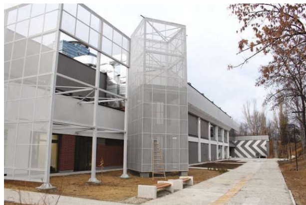
Ausblick vom Vorbereich kurz vor der Fertigstellung, o.J. Abb. 27
