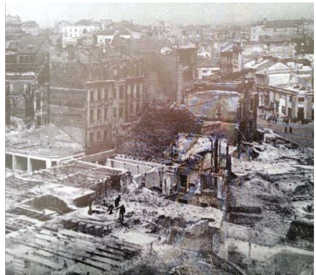
Aufräumen der Zerstörung nach dem Bombenanschlag in Sofia, 1945, Abb. 15
