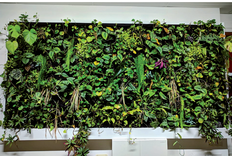
Innenraumbegrünung mit Vliestaschensystem in einer Wiener Schule.
