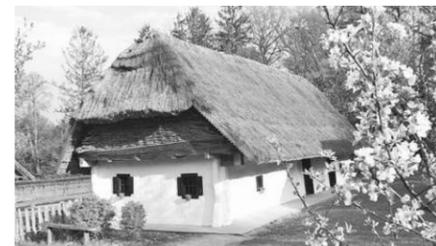
Abb. 54: Blockbau, mit Lehm verputzt und mit Kalkanstrich versehen.
