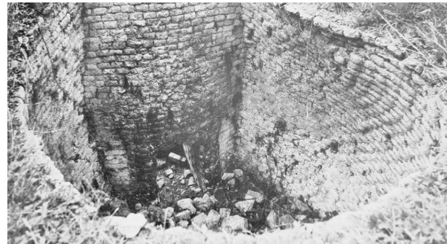
Abb. 20: Kalkofen, obere Füllöffnung des steinverkleideten Brennschachtes.
