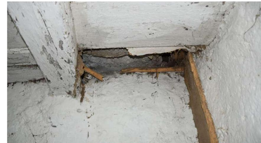
Abb. 151: Nordöstliche Raumecke mit morscher, gebrochener Holzlatte an der Decke.
