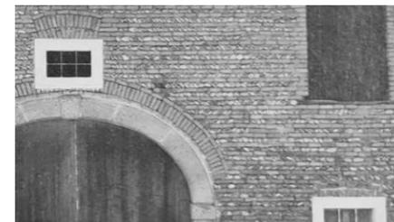
Abb. 62: Mauerwerk aus wechselnden Schichten Ziegel und Flussschotter.
