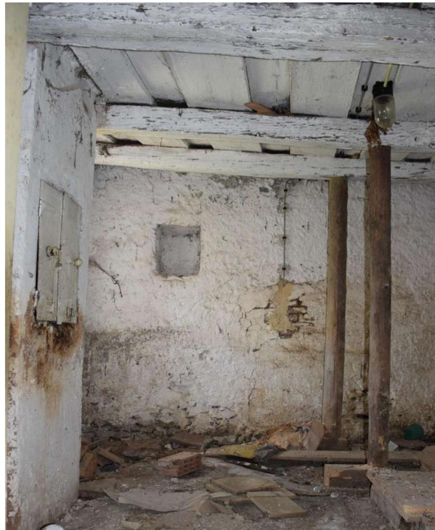
Abb. 149: Blick in Richtung Westwand. Die Decke wird mit Holzsäulen abgestützt.
