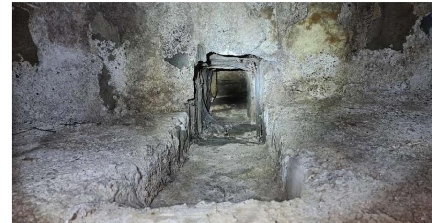
Abb. 196: Nord- und Südwand enthalten jeweils im Scheitelpunkt des Tonnengewölbes eine Lüftungöffnung in den Dachraum.
