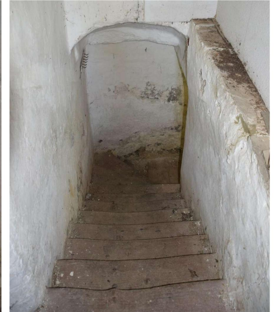
Abb. 164: Im unteren Bereich ist die Stiege überwölbt.
