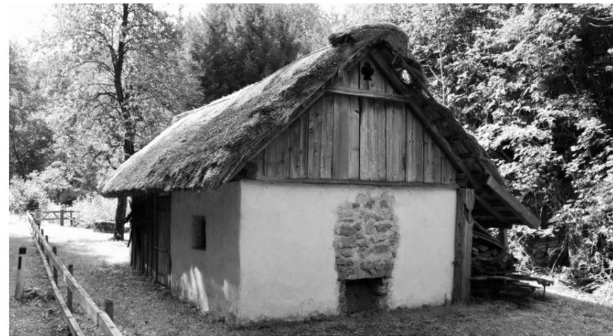
Abb. 56: Verputztes Dörrhaus mit Strohdach.
