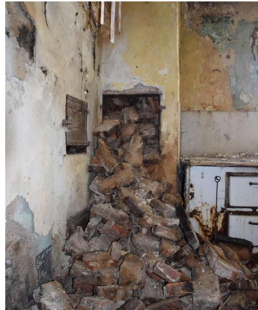
Abb. 139: Die Backsteine des eingestürzten Schornsteins sind durch die Öffnung im Schacht in die Küche eingedrungen und zum Liegen gekommen.
