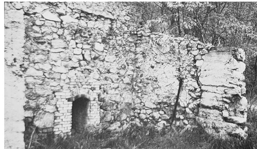
Abb. 21: Kalkofen, Feuerloch am unteren Ende des Schachtes.
