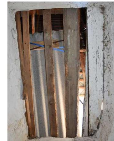
Abb. 127: Mit Holzbrettern bedeckte Öffnung in den Dachraum.
