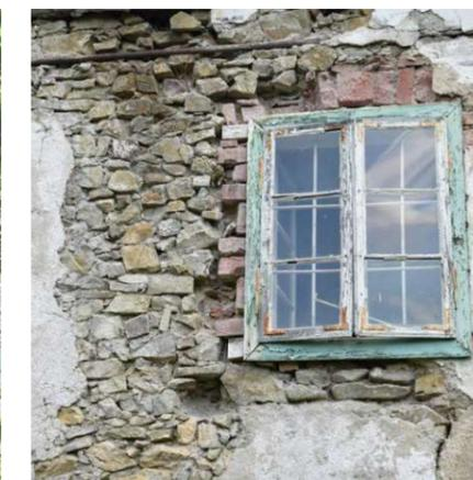
Abb. 94: Mit Ziegeln gemauertes Fenster.
