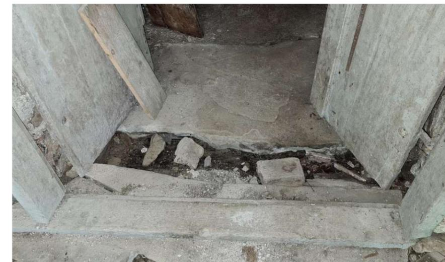
Abb. 197: Gebrochener Steinboden auch im Türschwellerbereich.
