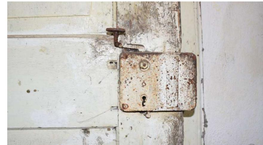
Abb. 144: Kastenschloss der Tür weiß lackiert, Zugang in die Labe.
