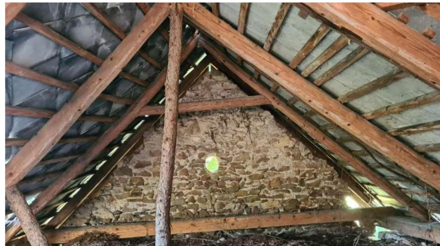
Abb. 153: Westwand des Dachraumes mit Belüftungsöffnung.
