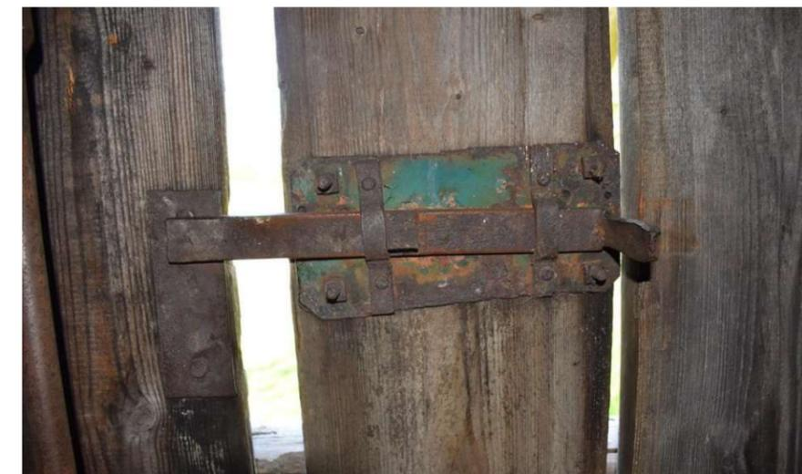
Abb. 218: Schmiedeeiserner Schlossriegel des östlichen Tores.
