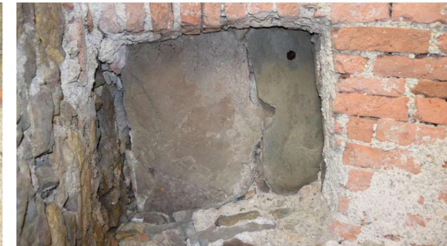
Abb. 119: Der Aufgang wurde mit Steinplatten und Ziegelsteinen verschlossen.
