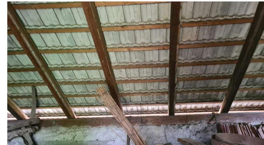
Abb. 210: Auf den Dachlatten verlegte Eindeckung aus Betondachsteinen.
