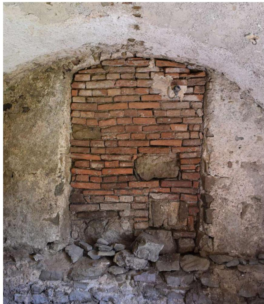
Abb. 1: Verschlussener Durchgang zwischen dem Wohnhaus und dem westlichen Zubau des Steinkellerhofes.
