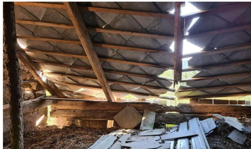
Abb. 154: Ein Sparren sowie einige Dachlatten und Eternitplatten der südlichen Dachfläche sind gebrochen.
