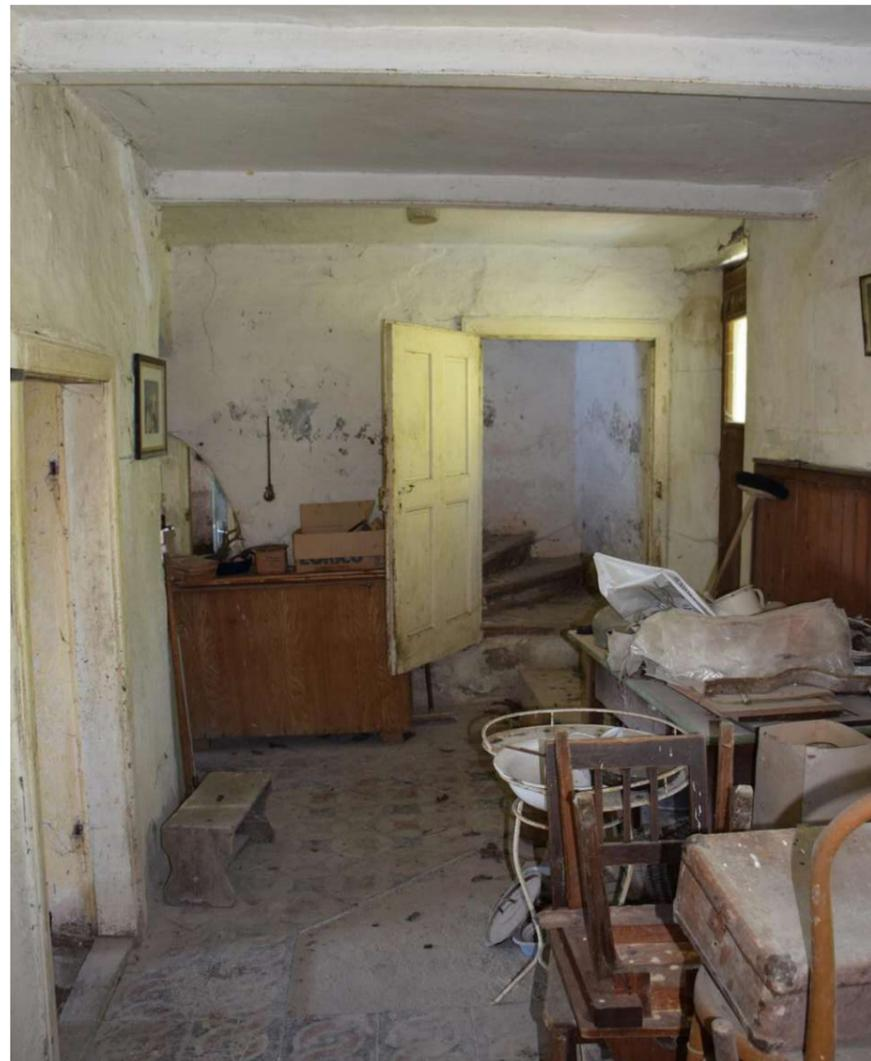
Abb. 125: Blick von der Stube in Richtung Eingangsbereich und Stiege. Die Tür links führt in die Küche. An der Decke sind die beiden Stahlträger zu erkennen.
