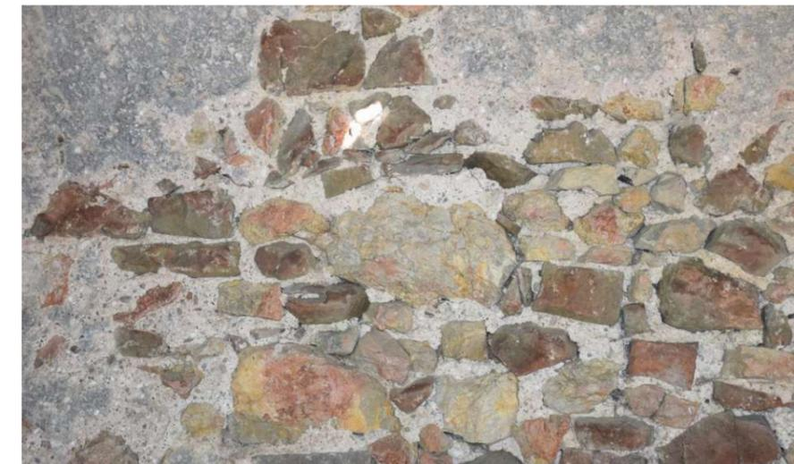
Abb. 157: Ostwand des Dachraumes entspricht westlicher Bruchsteinmauer des Wohnhauses.
