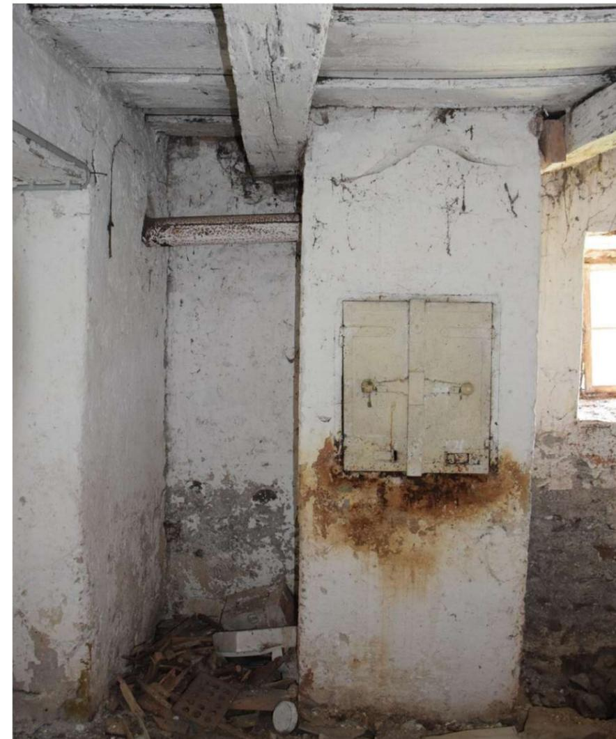
Abb. 150: Entlang der Südwand verlaufender Kaminschacht.
