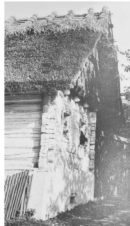
Abb. 52: Blockbau mit Strohdach.
