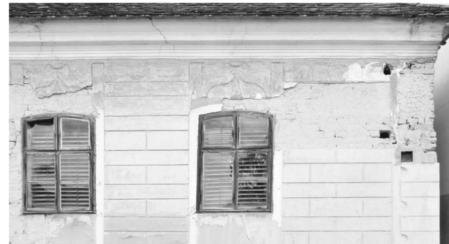
Abb. 60: Lehmziegelbau mit verputzter Fassade.
