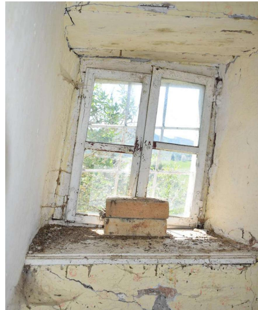
Abb. 170: Das nach Süden orientierte Fenster ist stark verzogen.
