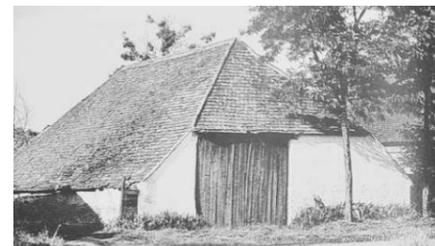
Abb. 55: Längsscheune mit Walmdach.
