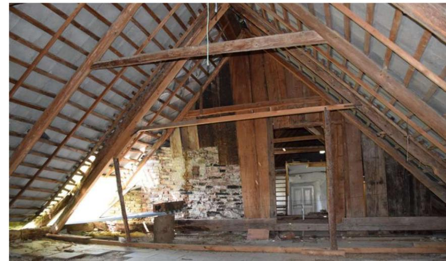
Abb. 177: Blick von Osten zur Mittelwand des Dachraumes. Die südliche Dachfläche ist Anfang 2020 eingestürzt.
