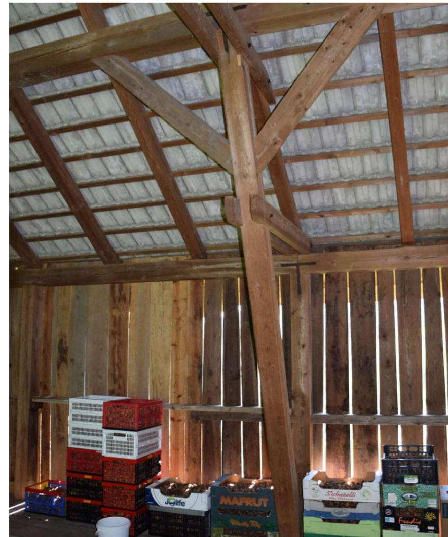
Abb. 221: Stützenfreier Raum durch zwei schräggestellte Mittelpfosten.
