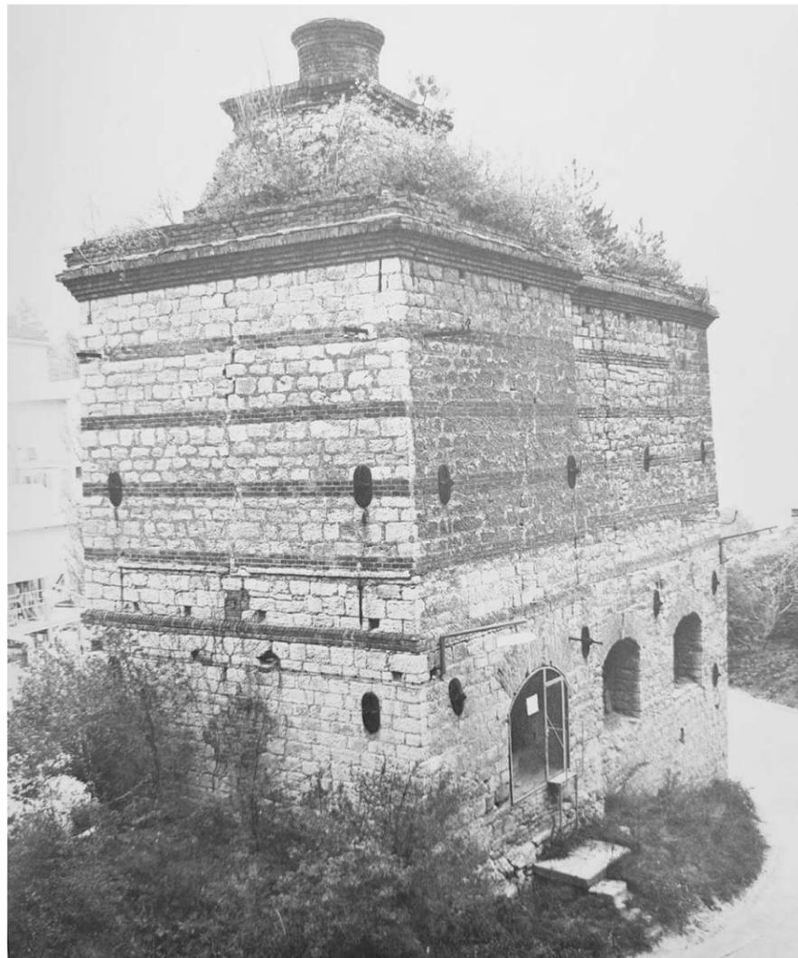
Abb. 22: Stillgelegter Hochofen aus dem 19. Jahrhundert zur industriellen Herstellung von Brennkalk in Gumpoldskirchen.
