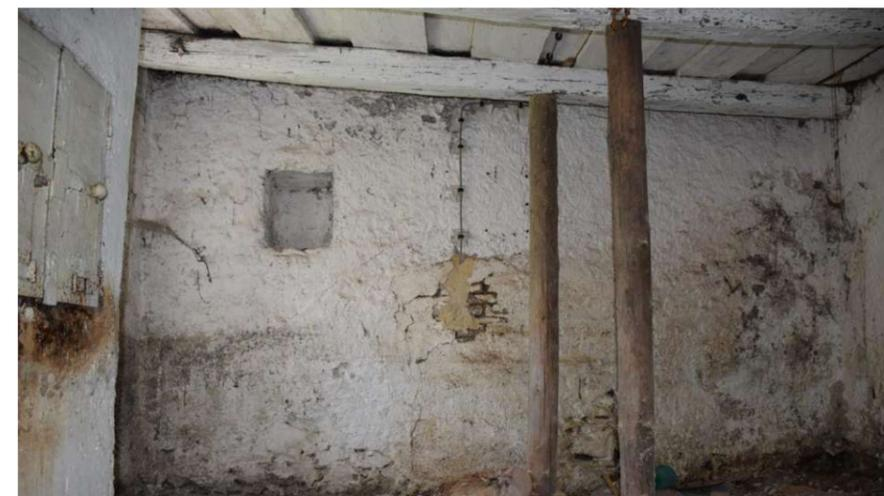
Abb. 104: Der Turmspeicher mit abgestützter Decke und zugemauerter Wandöffnung.
