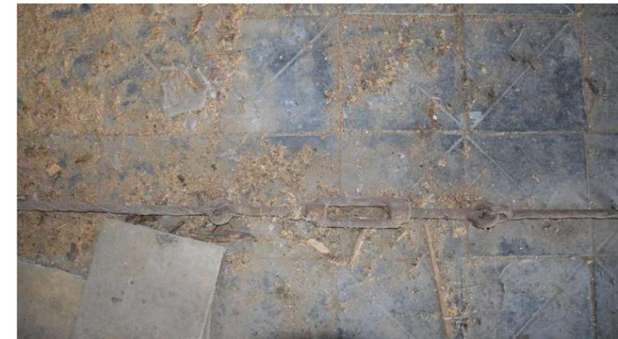
Abb. 178: Den Dachraum in Bodenhöhe querendes Zugseil zwischen Mauerankern.
