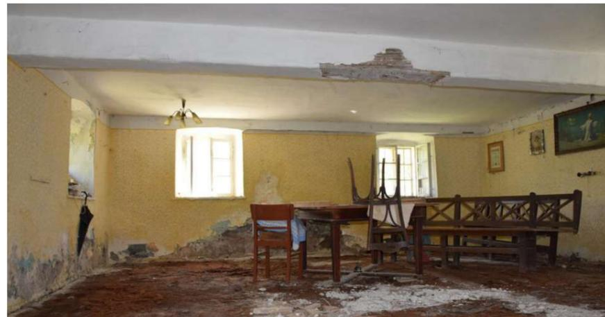
Abb. 131: Östliche Raumhälfte der Stube. Von der Nord- zur Südwand verläuft mittig an der Decke ein verputzter Holzträger, auch *Rüstbaum* genannt.
