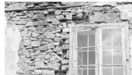
Abb. 66: Bruchsteinmauerwerk, Fenster nachträglich mit Ziegeln eingebaut.
