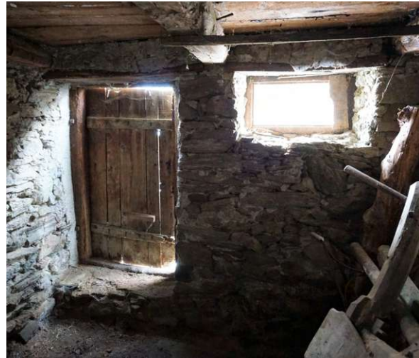
Abb. 41: Südwand mit T14 und F15
