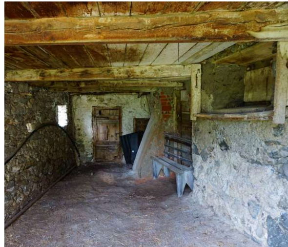
Abb. 35: Blick in den Vorraum
