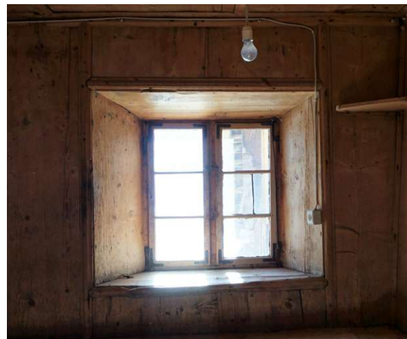
Abb. 13: Geneigte Fensterlaibung beim Stubenfenster
