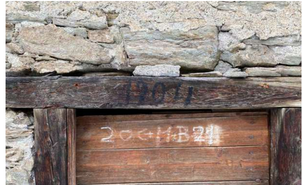
Abb. 9: Inschrift oberhalb der Tür vom Anbau 3
