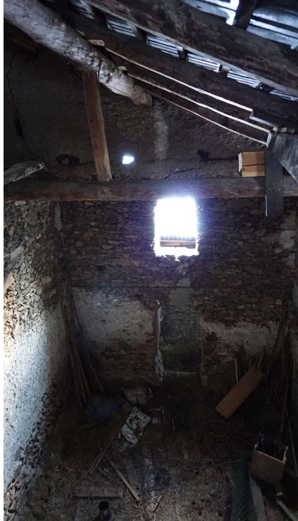
Abb. 21: Öffnungen in der Südwand
