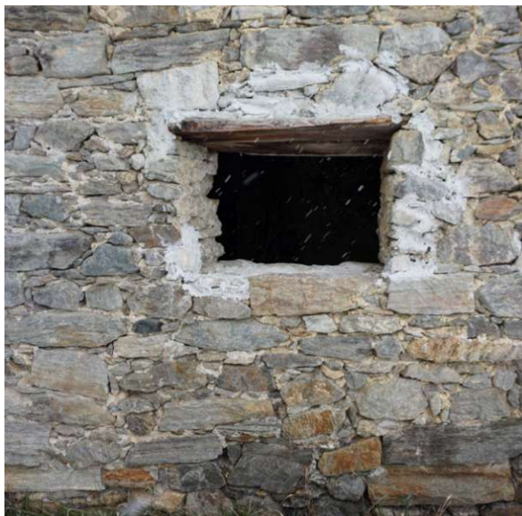
Abb. 8: Öffnung im Steinmauerwerk des Anbaus 1
