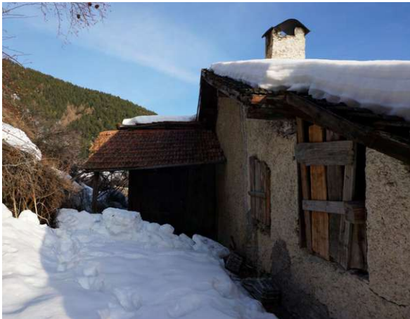
Abb. 3: Nordfassade und Anbau 3
