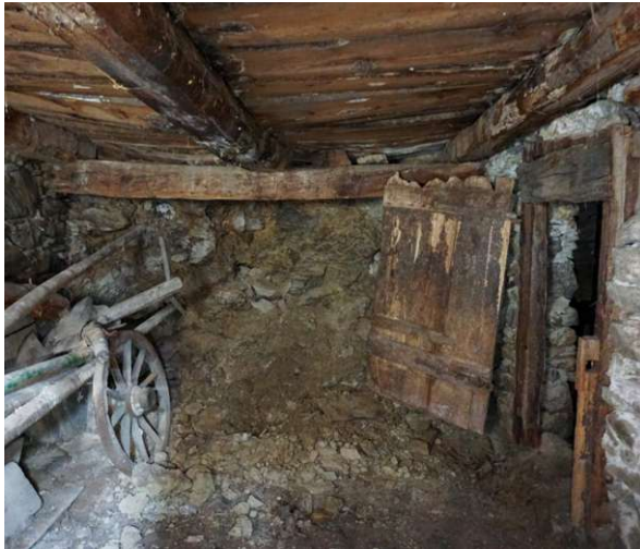
Abb. 40: Blick in den Keller
