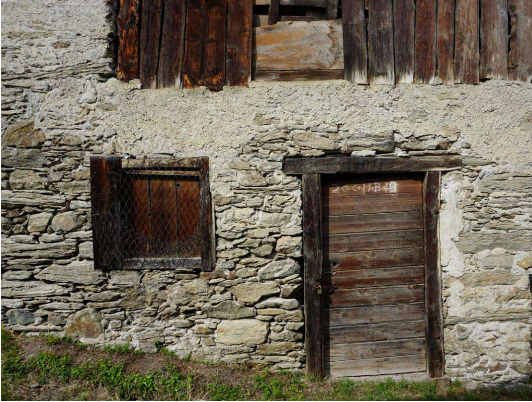
Abb. 48: Südwand mit T18 und F17
