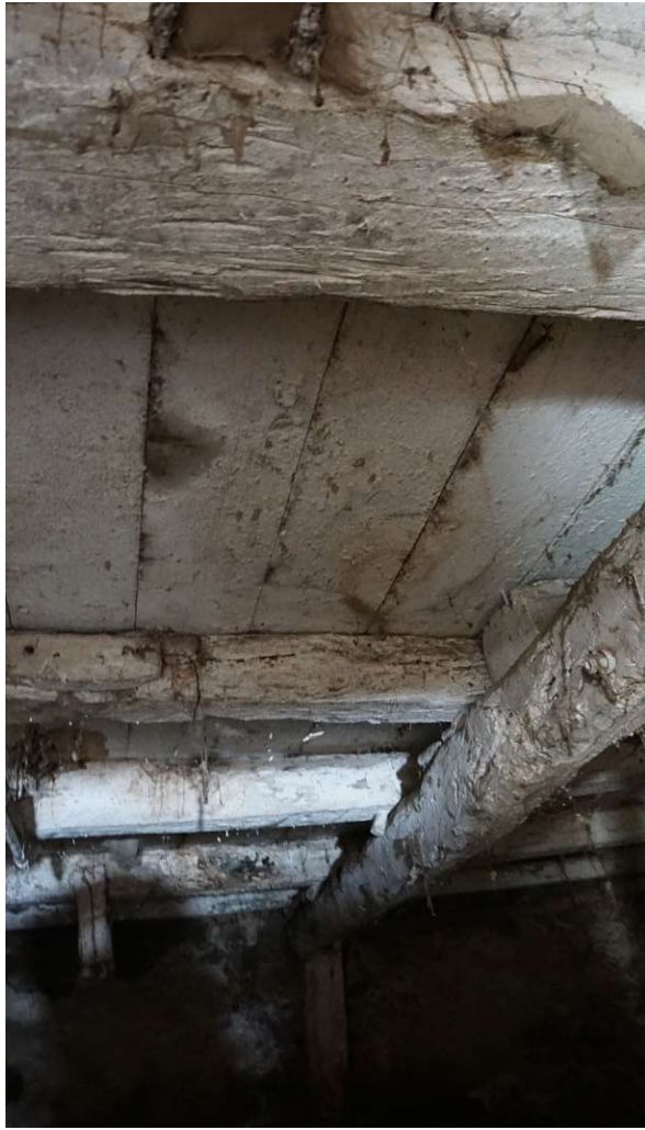
Abb. 6: Deckenkonstruktion mit Kalkanstrich
