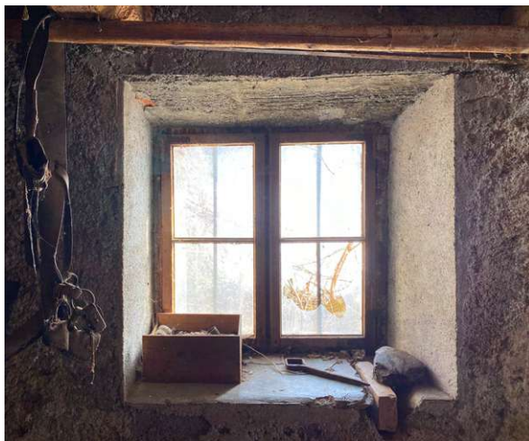
Abb. 12: Fenster in der Ostfassade
