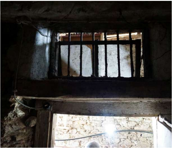
Abb. 4: Ehemaliger Schweinestall Abb. 5: Oberlicht über T2
