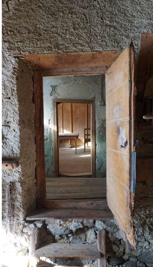
Abb. 9: Blick Richtung Stube
