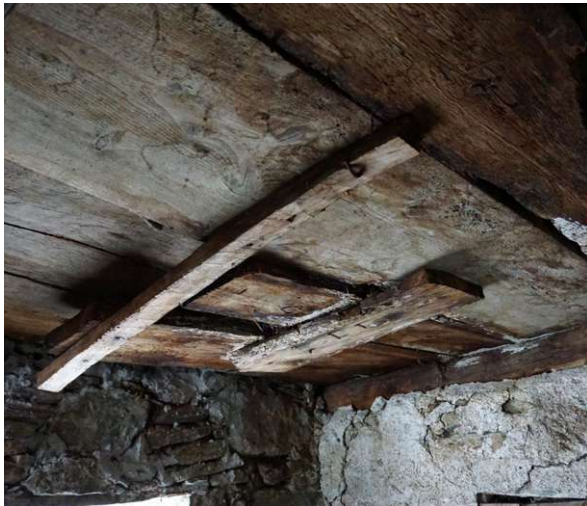
Abb. 34: Beschädigte Holzdecke
