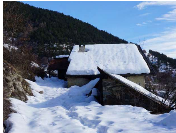
Abb. 4: Die verbaute Westfassade
