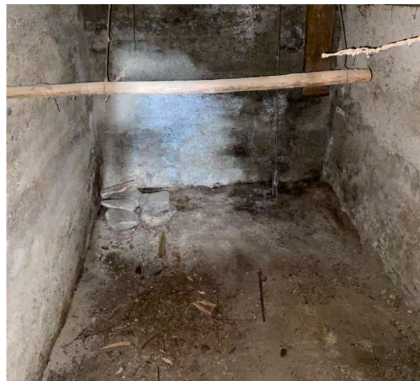
Abb. 45: Blick durch das Fenster F16
