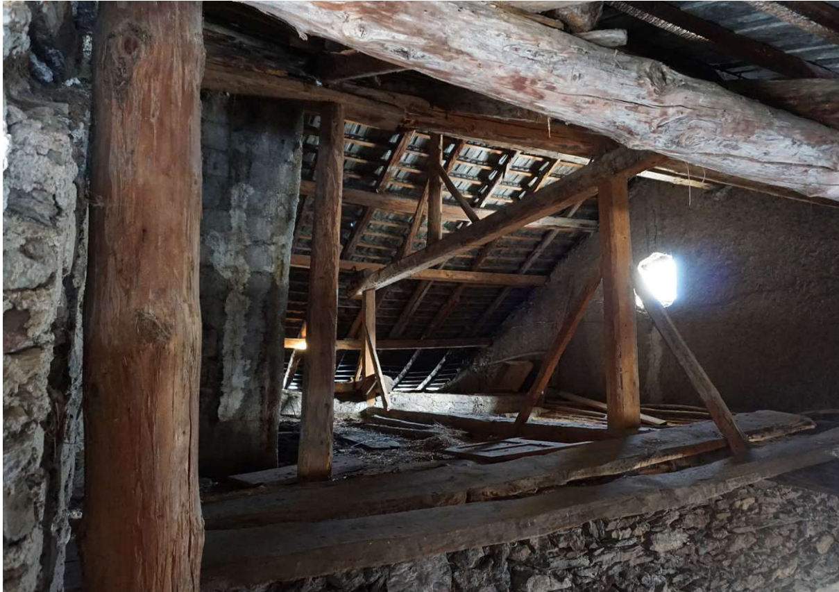
Abb. 33: Pfettendachkonstruktion
