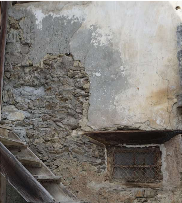
Abb. 11: Das Steinmauerwerk ist unter dem Verputz sichtbar
