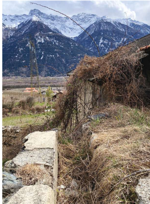
Abb. 6: Der alte Waalverlauf ist noch sichtbar
