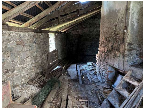
Abb. 43: Beschädigte Deckenkonstruktion
