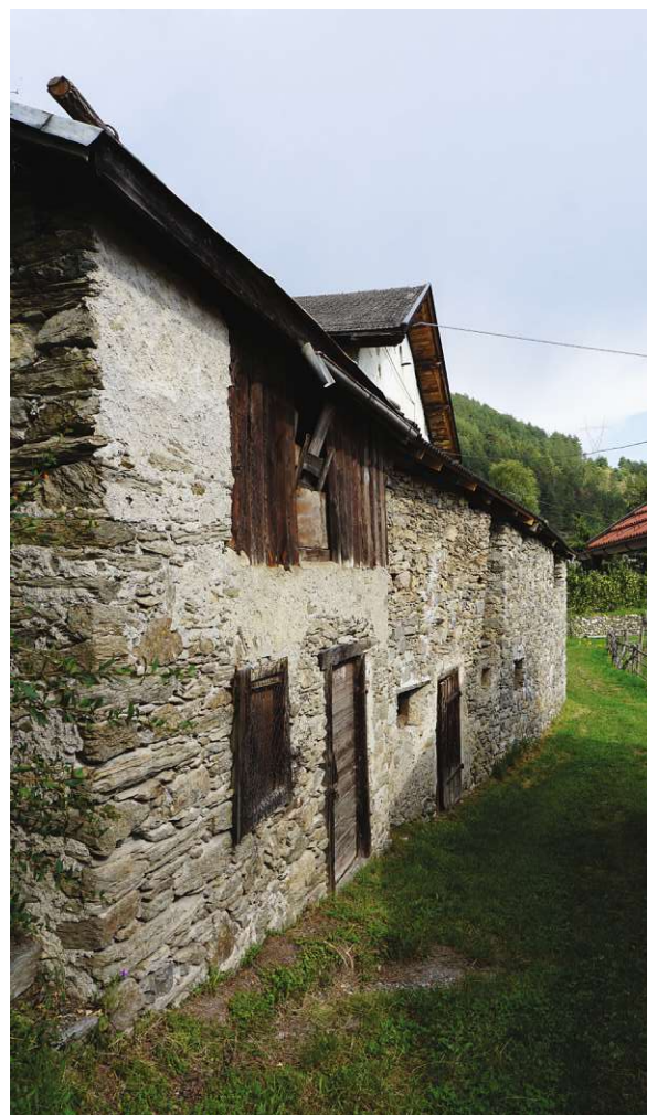
Abb. 20: Südfassade der Anbauten 1 und 3
