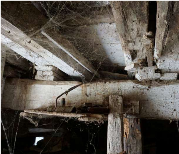
Abb. 1: Die tragende Struktur ist das Steinmauerwerk.
