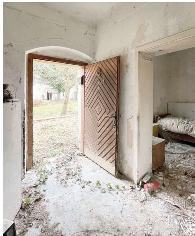
Abb. 125 Eingangstür vom Innenhof
