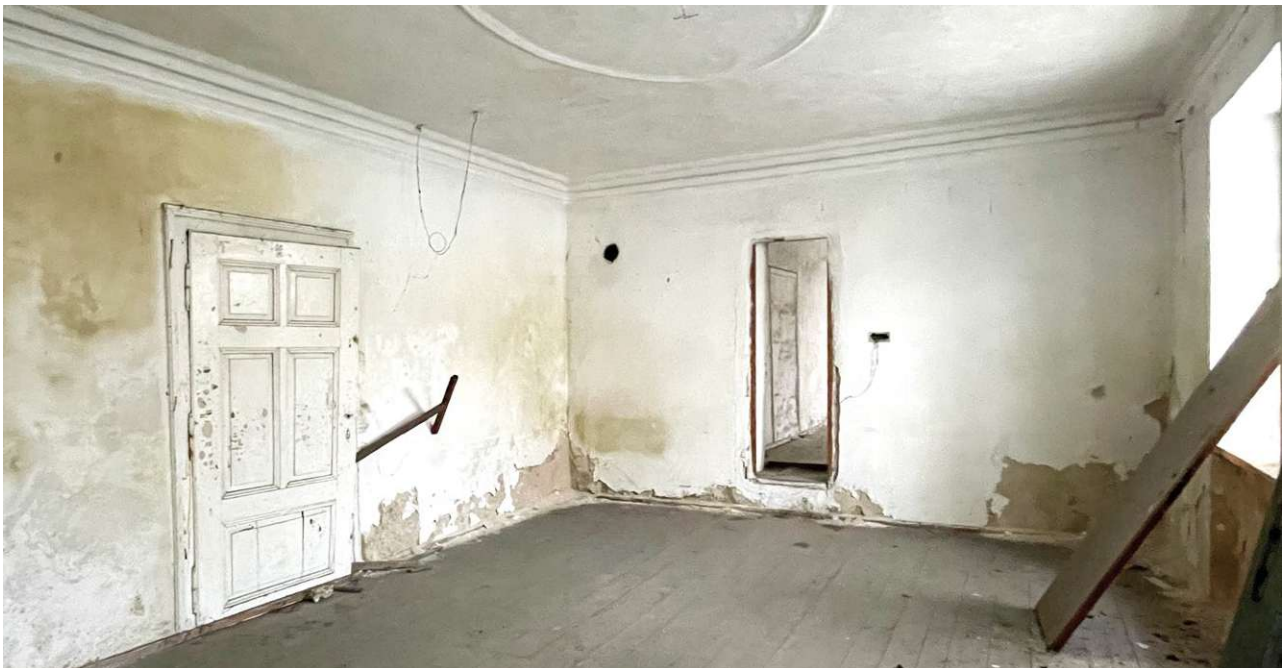
Abb. 110 Zugemauerte Tür und Türöffnung zum 12-Zimmer
