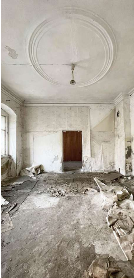
Abb. 85 Blick in den 02-Raum vom Gang
