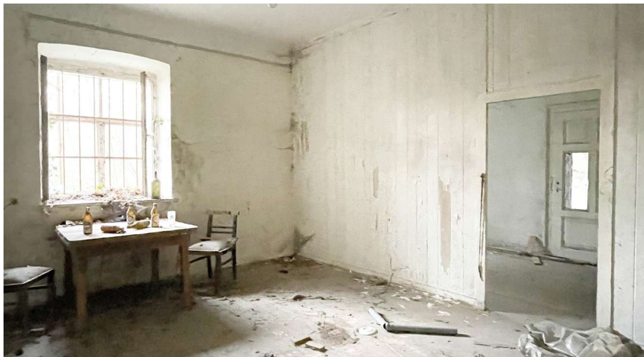
Abb. 128 Westfenster und die nachträglich eingebaute Raumteilung
