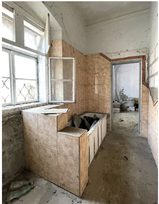
Abb. 144 Bad mit Ostfenster und Tür zum 23-Zimmer
