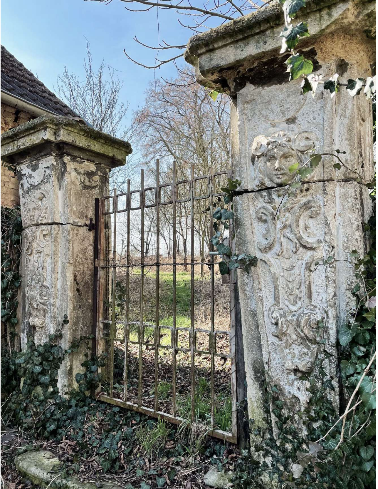
Abb. 42 Tor zwischen dem Innenhof und dem ehemaligen Park
