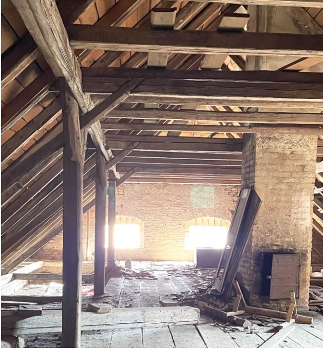
Abb. 170 Dachboden mit den Ostfenstern - Sp. 6
