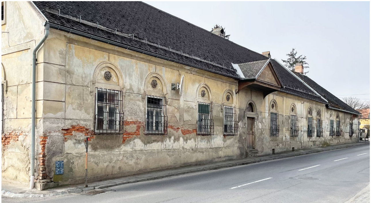
Abb. 55 Nordfassade von der Hauptstraße
