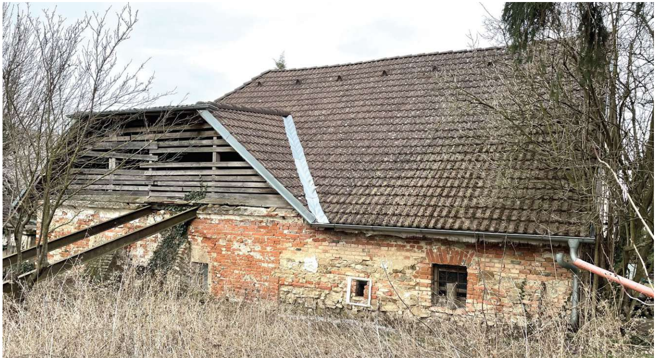
Abb. 59 Westfassade- südlicher Teil
