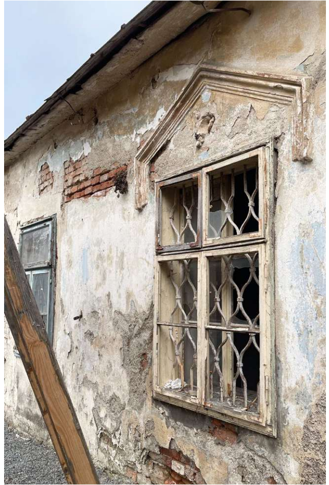
Abb. 58 Fenster zur Straße
