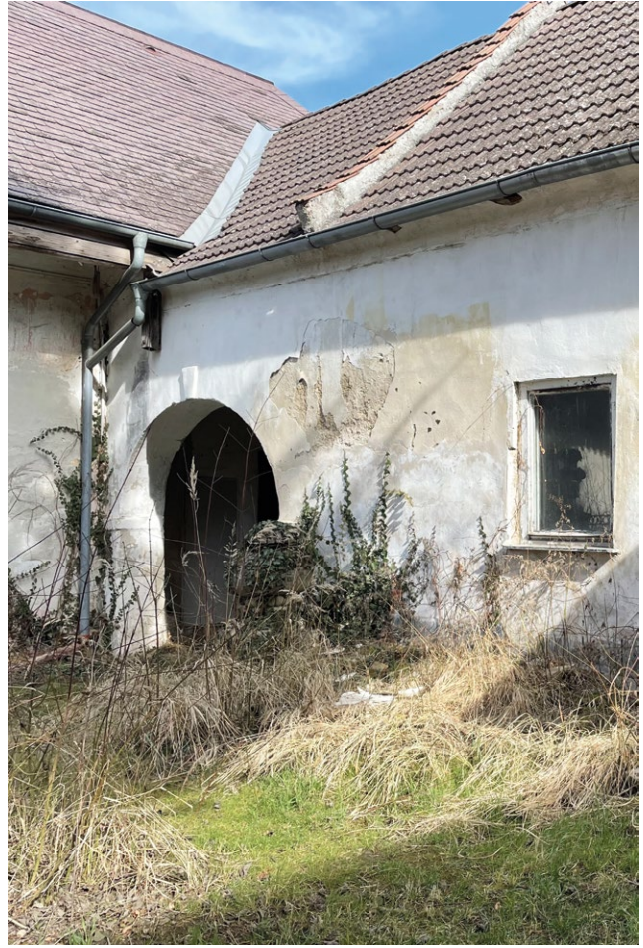
Abb. 68 Westfassade im Innenhof
