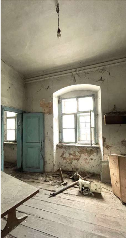
Abb. 107 Nordfenster und Tür
