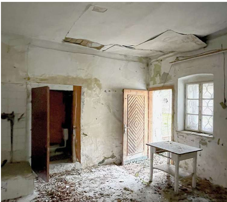
Abb. 117 Dusche im Eck und WC unter der Stiege
