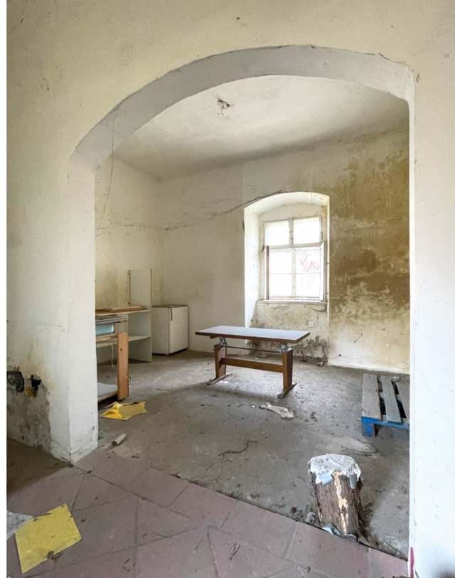
Abb. 134 Ostfenster und die raumteilende Wand
