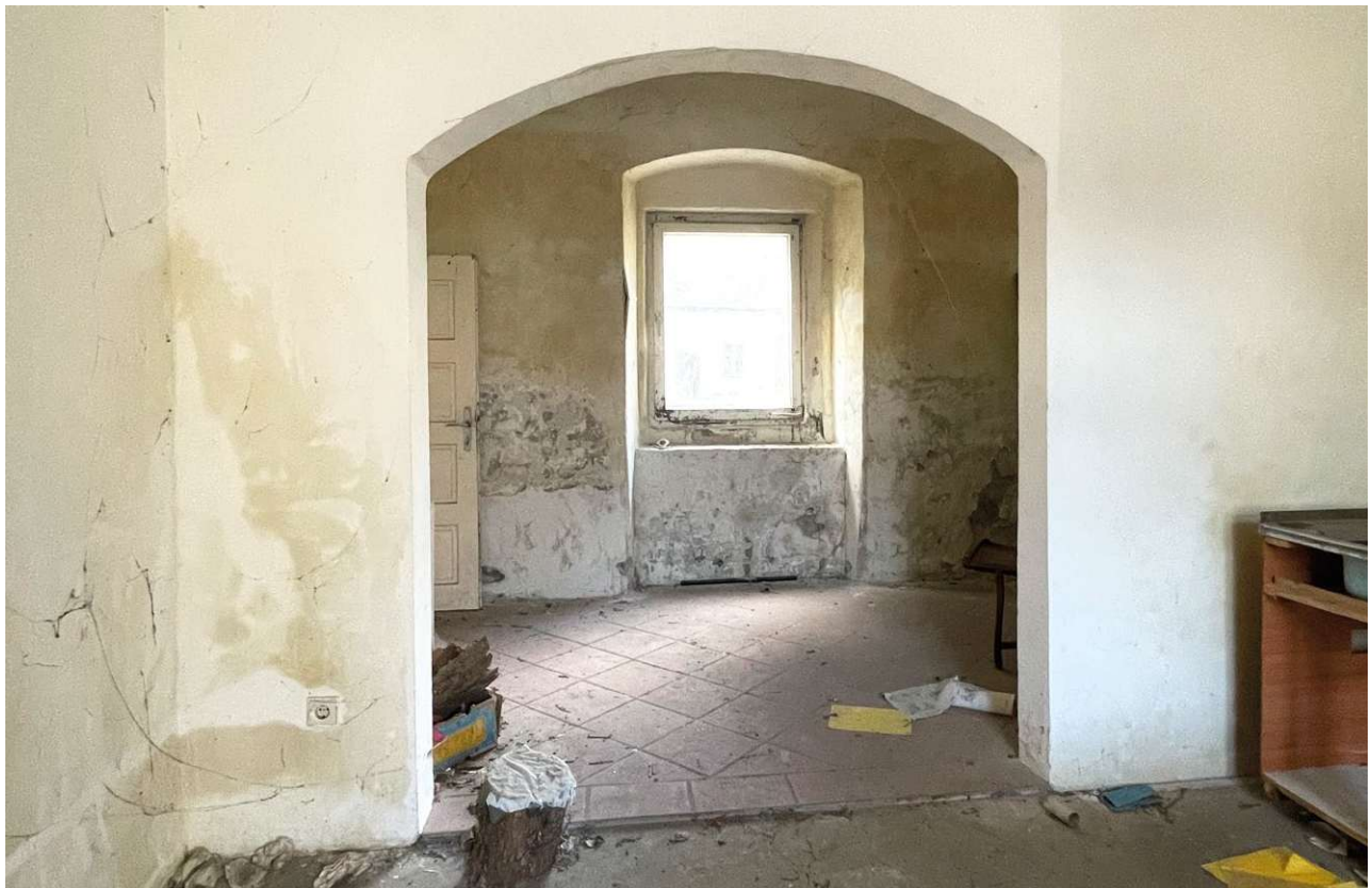
Abb. 135 Westfenster und die raumteilende Wand
