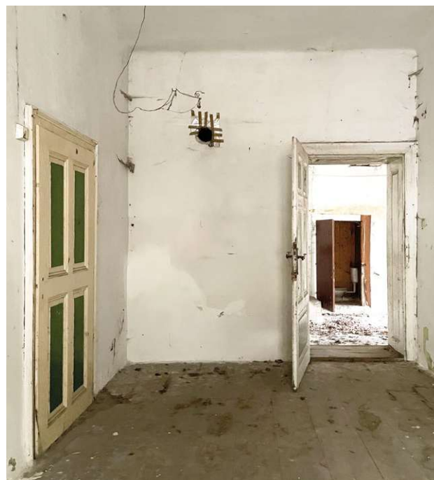
Abb. 121 Zugemauerte Tür und Tür zum 13-Zimmer
