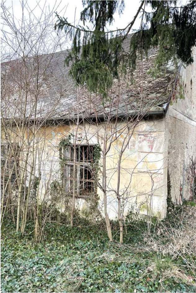
Abb. 57 Westfassade- nördlicher Teil
