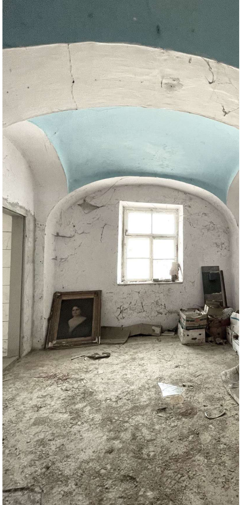
Abb. 148 Ostfenster und Tür vom 22-Zimmer
