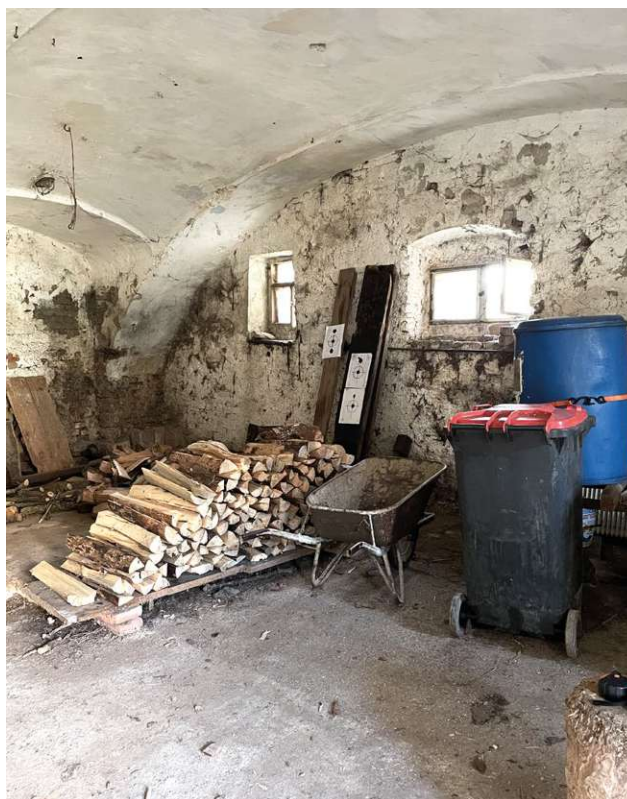
Abb. 161 die zwei westseitigen Fenster
