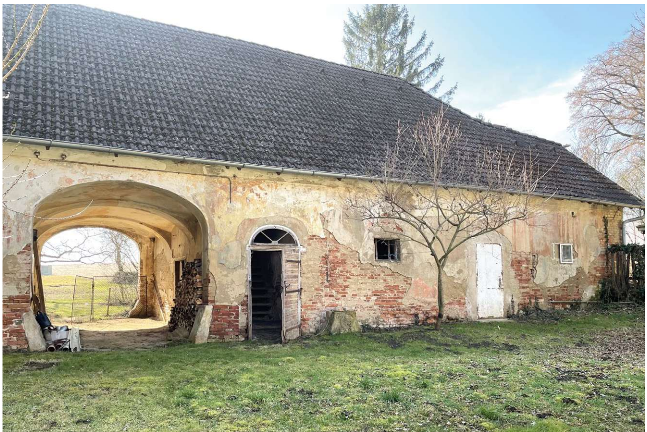
Abb. 65 Süd-Einfahrt vom Innenhof
