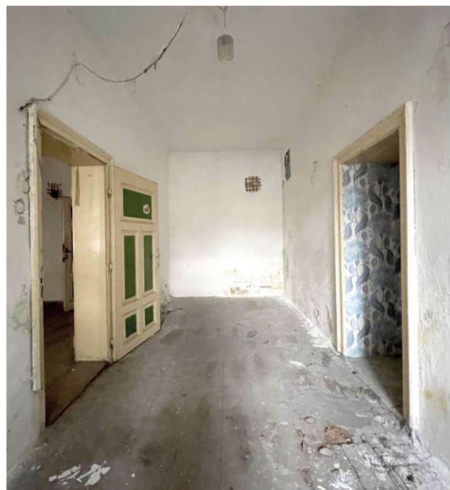
Abb. 123 Türe zu den zwei Nachbarräumen
