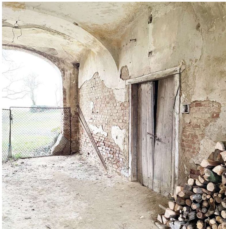
Abb. 158 Eingangstür vor der Süd-Einfahrt
