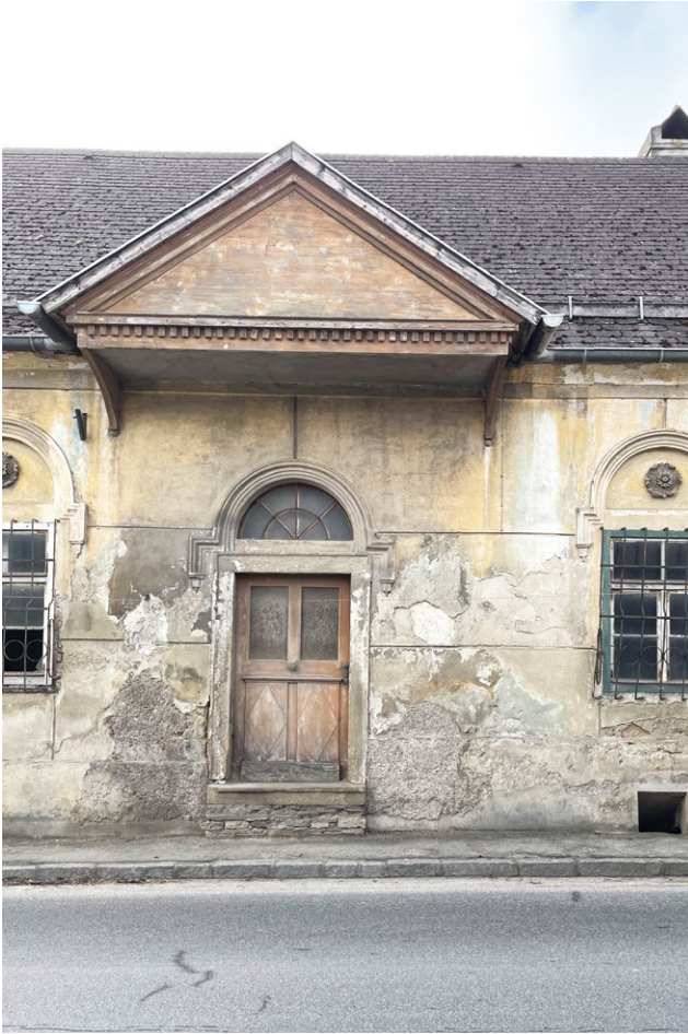
Abb. 53 Eingangstür mit Vordach
