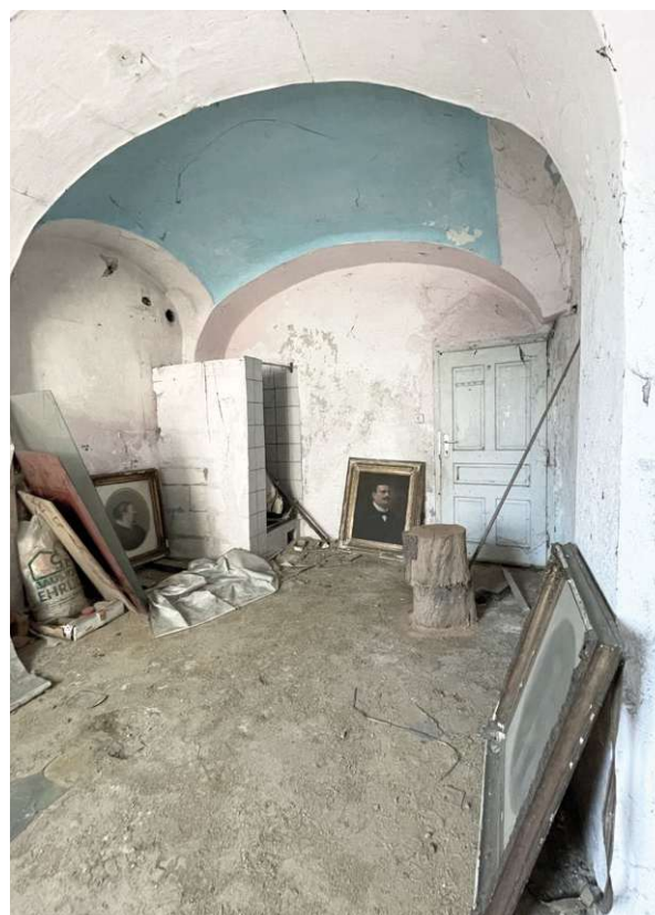
Abb. 145 Eingangstür vom Innenhof
