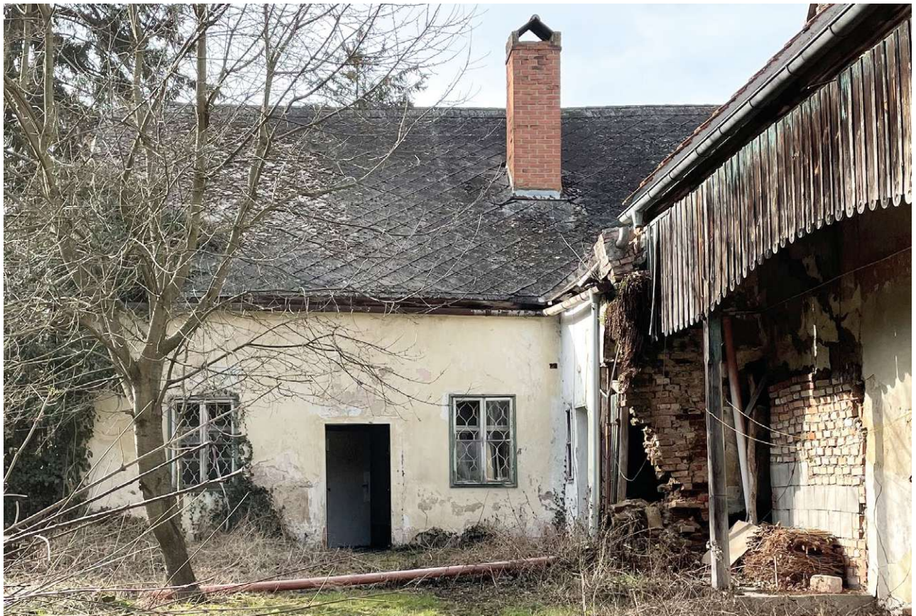
Abb. 77 Ostfassade im Innenhof
