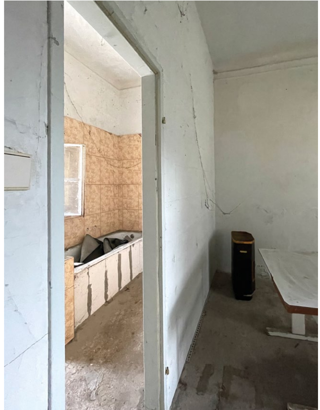
Abb. 142 nachträglich eingebaute Trennwand
