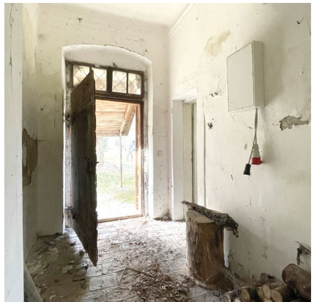
Abb. 137 Eingangstür vom Innenhof
