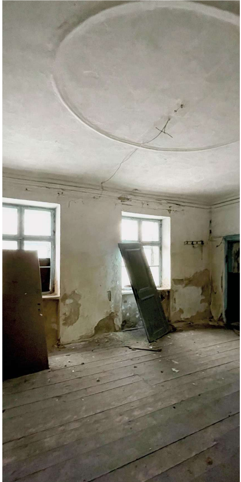
Abb. 113 die zwei Fenster Richtung Norden
