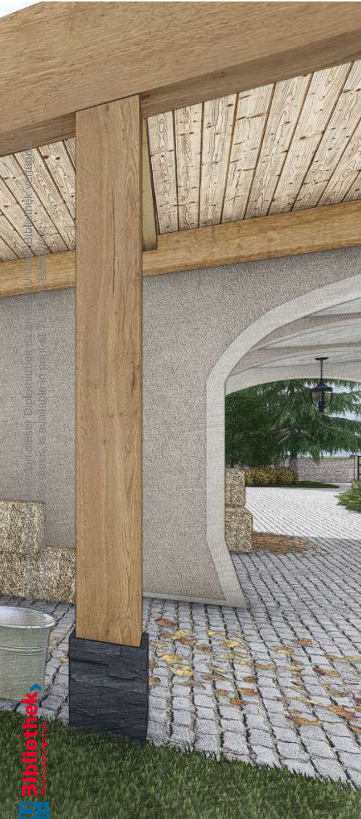
Abb. 221 Innenhof- Stalleingang und alte "Süd-Einfahrt" vom Hinterhof
