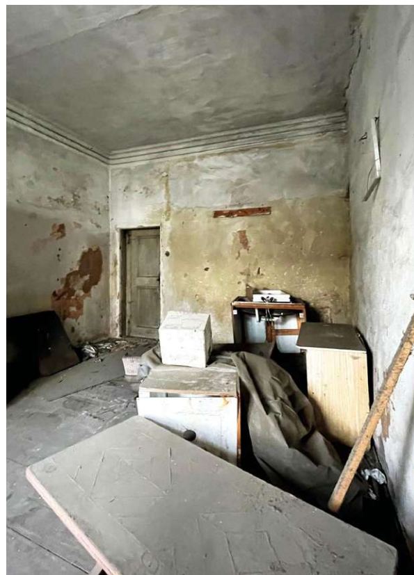
Abb. 106 Wand gegenüber dem Fenster
