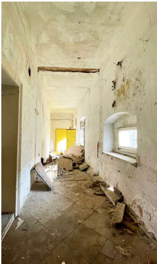
Abb. 80 Blick durch dem Gang
