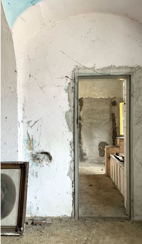
Abb. 146 Tür vom 22-Zimmer (Bad)
