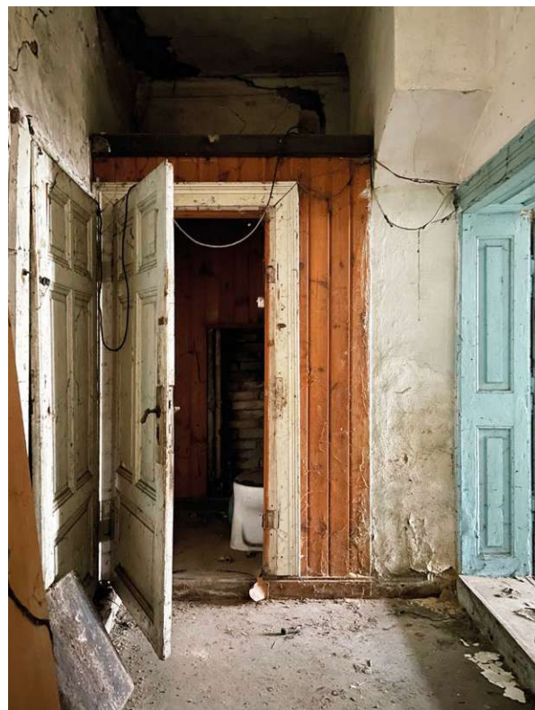
Abb. 103 abgetrenntes WC am Ende des Ganges
