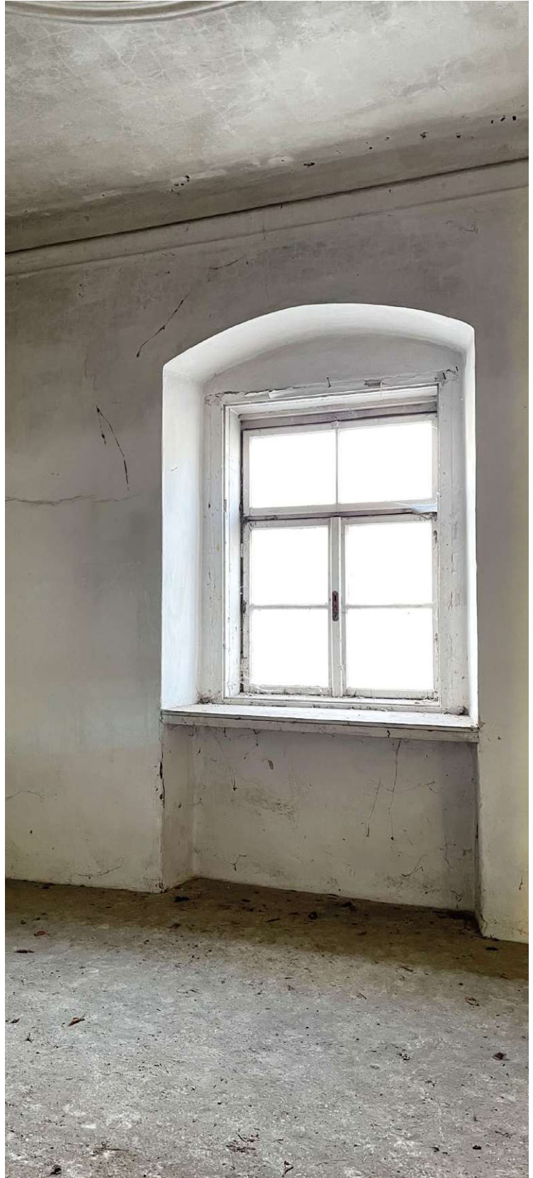
Abb. 99 Fenster im 06-Zimmer
