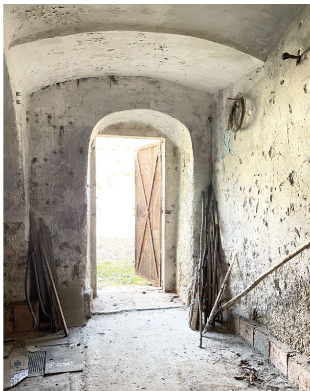
Abb. 160 Tür vom Innenhof
