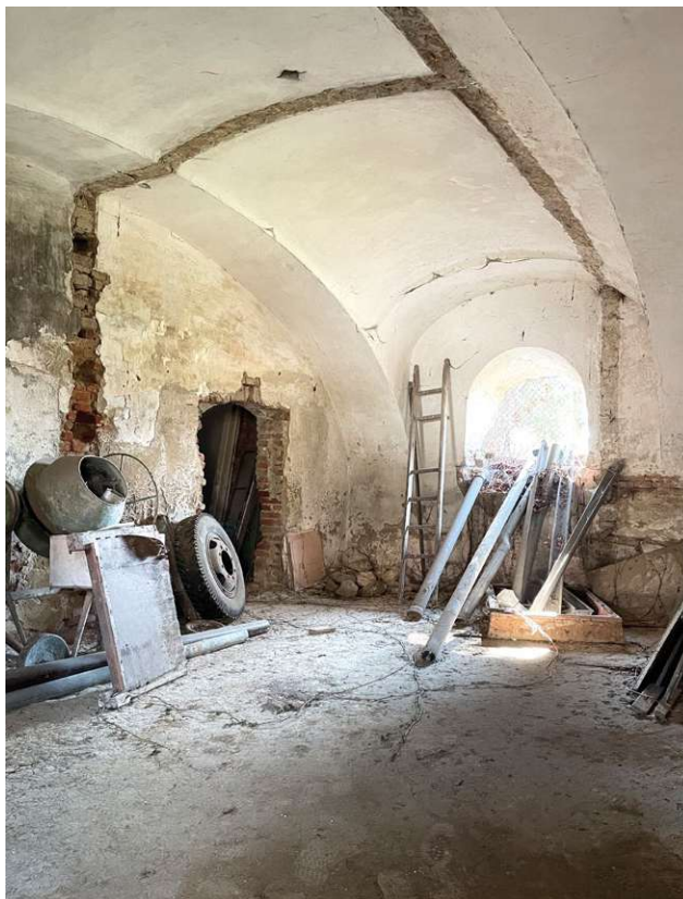
Abb. 155 Südfenster und Türöffnung zum 25-Zimmer
