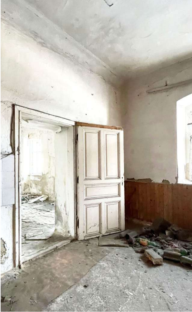
Abb. 88 Zimmer 03a- Blick Richtung Nordfenster
