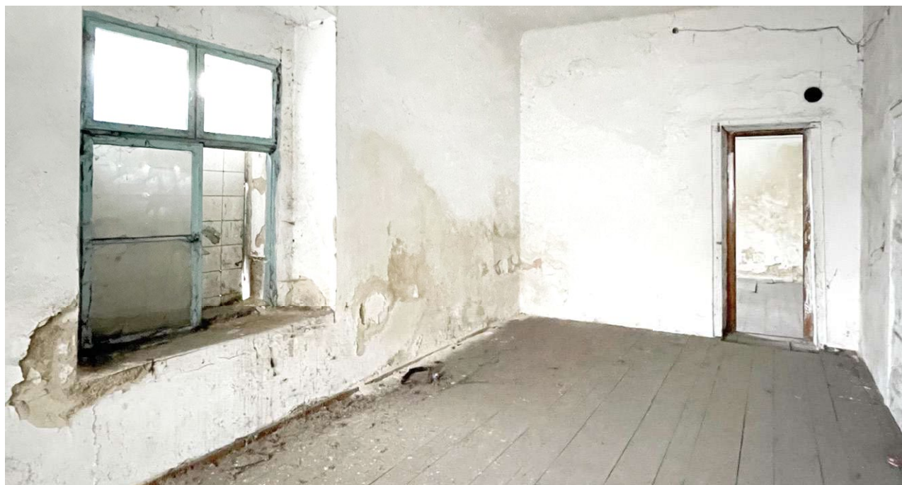
Abb. 114 von links: Nordfenster, Türöffnung zum 11-Zimmer, zugemauerte Tür
