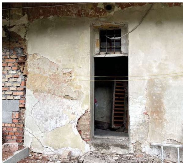
Abb. 102 Eingangstür vom Innenhof
