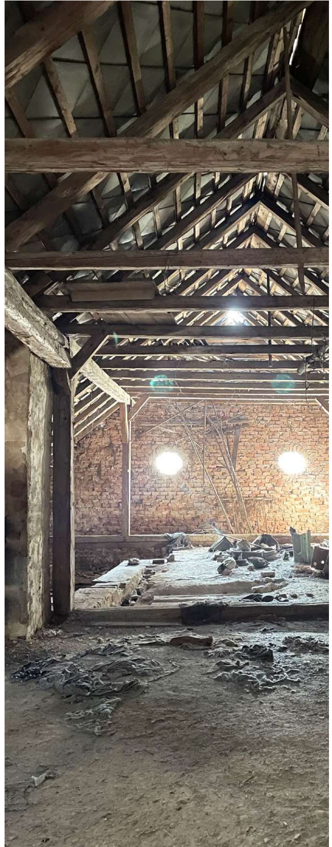
Abb. 174 Dachboden über den 16-17-18-Zimmern - Sp. 9
