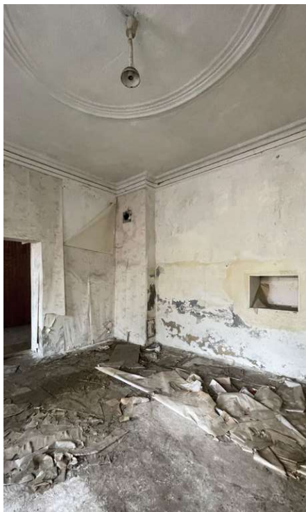
Abb. 86 Nische und Kaminwand
