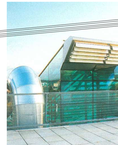
Abb. 34 Lüftungslamellen der Dreifachturnhalle
