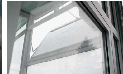
Abb. 301 Blick Richtung Süden
