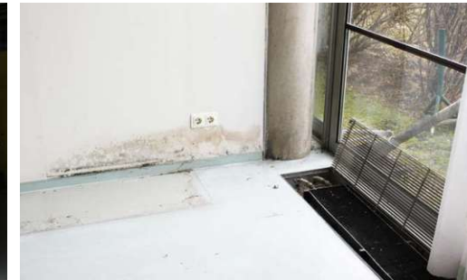
Abb. 172 Feuchtflecken an Wand
