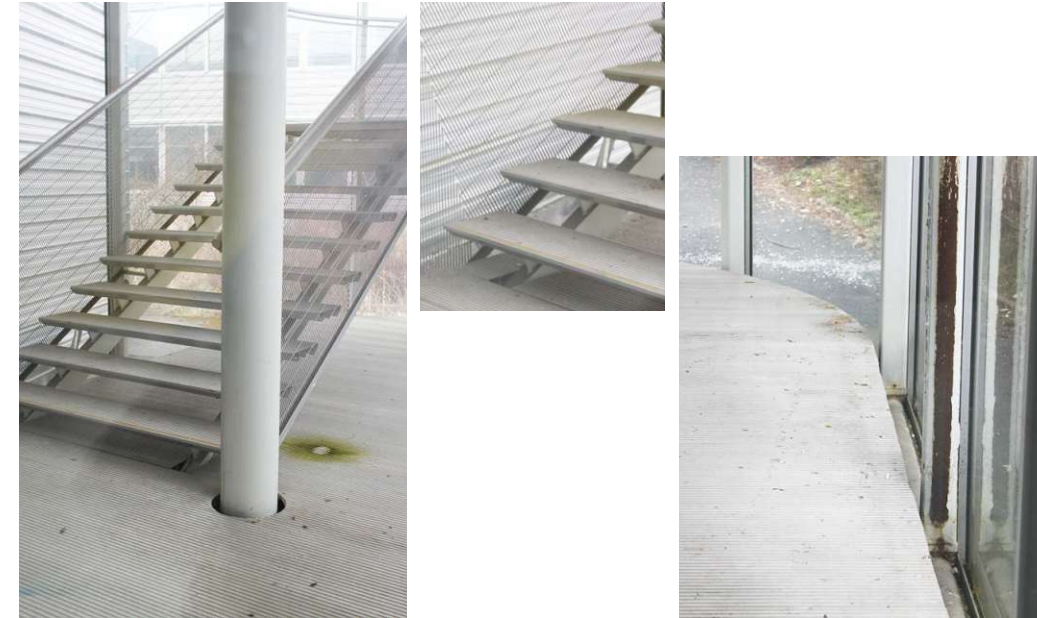
Abb. 232 Verfärbung am Boden durch Wassereintritt
