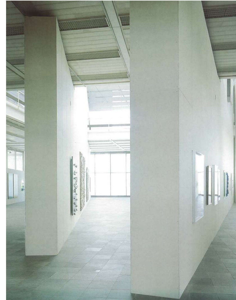
Abb. 73 rohe Rigipsplatten als Ausstellungswände
