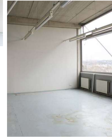
Abb. 310 Wasserflecken am Boden
