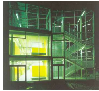
Abb. 21 Fluchttreppenhaus bei Nacht
