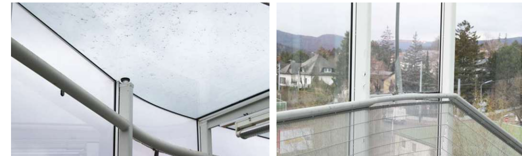
Abb. 298 Anschluss vertikale und horizontale Glasflächen
