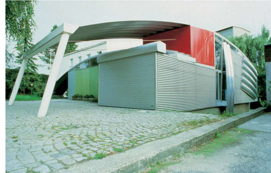
Abb. 55 Haus Königseder nach Fertigstellung 1980
