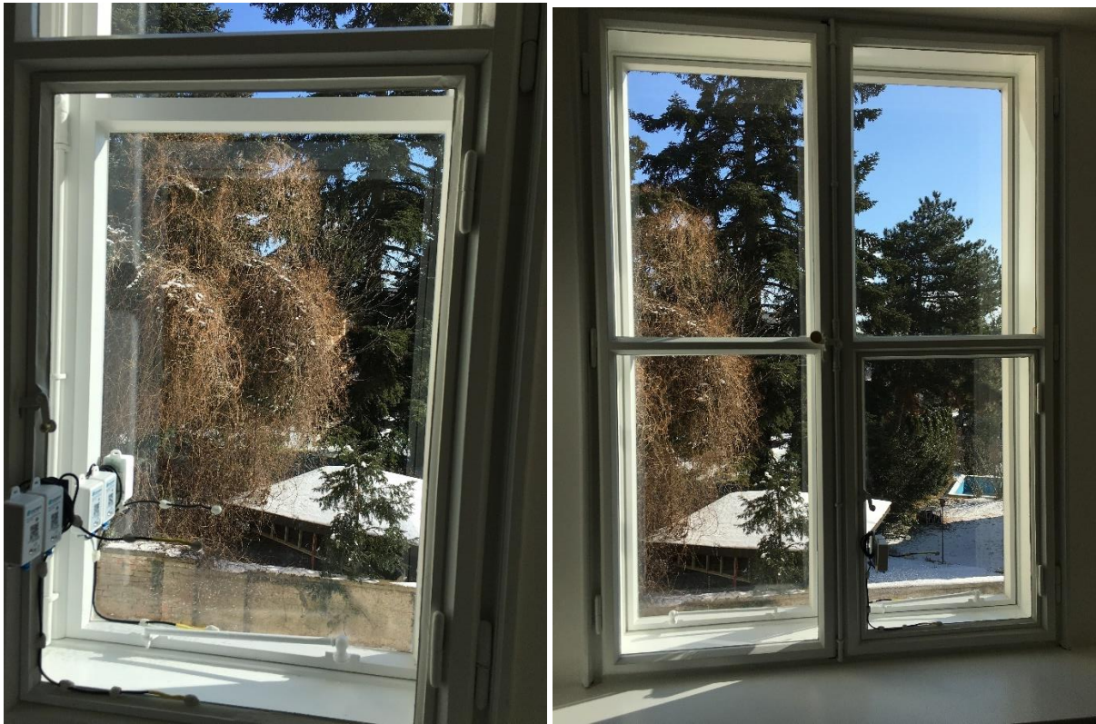
Abbildung 9: links: Positionierung der funkbasierten Messtechnik; rechts: Innenansicht des untersuchten Fensters
