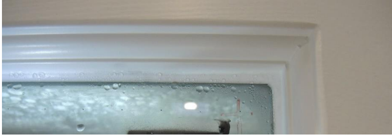
Abbildung 77: Beispiel für Kondensat: Klasse 2 (Tropfen sichtbar, jedoch nicht ab rinnend); teilflächig (T)
