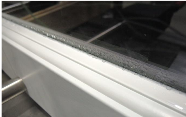
Abbildung 77: Beispiel für Kondensat: Klasse 2 (Tropfen sichtbar, jedoch nicht ab rinnend); teilflächig (T)
