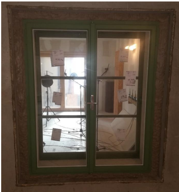
Abbildung 23: Empfangsraumseitige Einbausituation des Kastenfensters bei SA 271 mm
