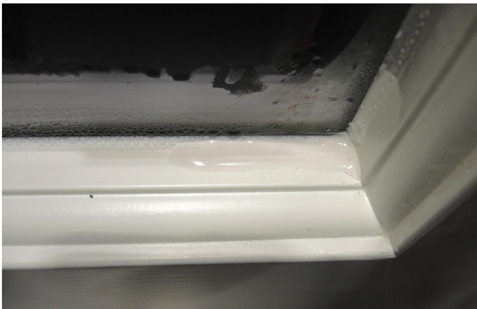
Abbildung 78: Beispiele für Kondensat: Klasse 3 (abrinnende Tropfen, Lackenbildung am/im Fenster); oben linienförmig (L), unten teilflächig (T)
