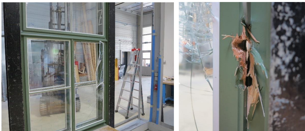
Abbildung 66: Links: nach manueller Belastung der Glasanbindung geöffnetes Glasfeld Rechts: Beschädigungen am bandseitigen Stehflügel nach manueller Belastung
