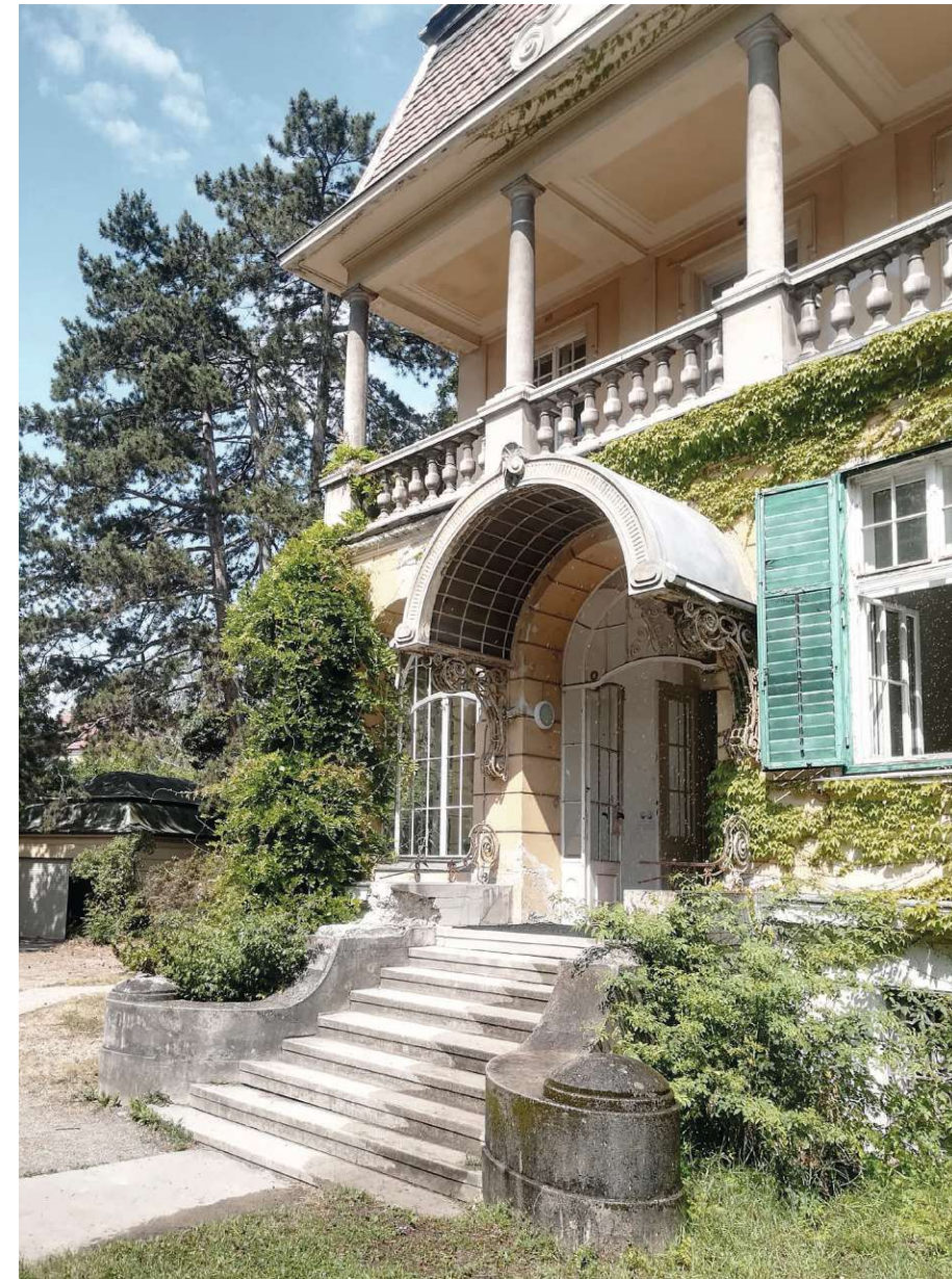
Abbildung 044 | links: Nord-Ost Ansicht, Villa Schapira.
