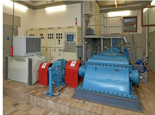
(b) Durchströmturbine mit Getriebe und Generator
