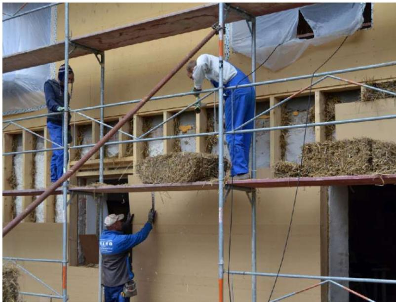
Abb 87 Sukzessives Befüllen der vorgelagerten Holzkonstruktion, Verschalung mit Holzfaser-Unterdeckplatten (Foto: ASBN / baubiologie.at)
