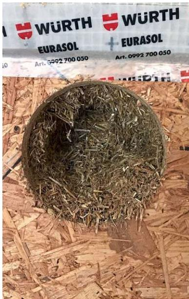
Abb 81 Einblasöffnung in OSB-Schalung innen, Bauteilübergang mit Dichtungsband (Foto: DPM Holzdesign / dpm-gruppe.com)
