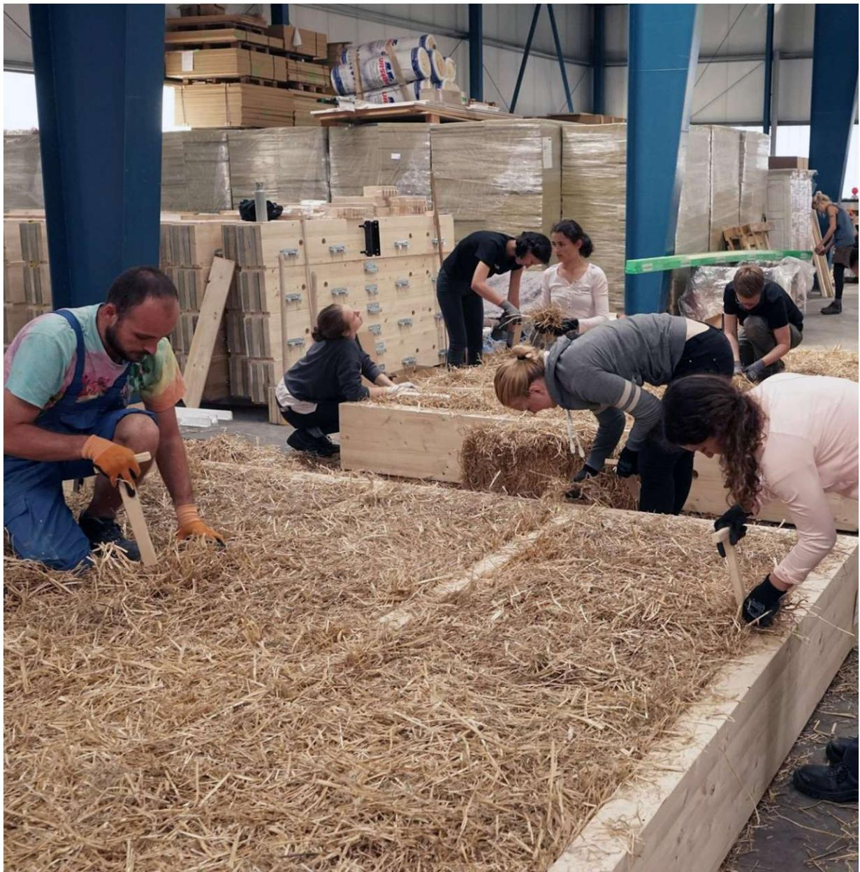
Abb 15 Ausstopfen der Hohlräume im Bereich der Ballenstöße (Foto: Karin Haas, ASBN)
