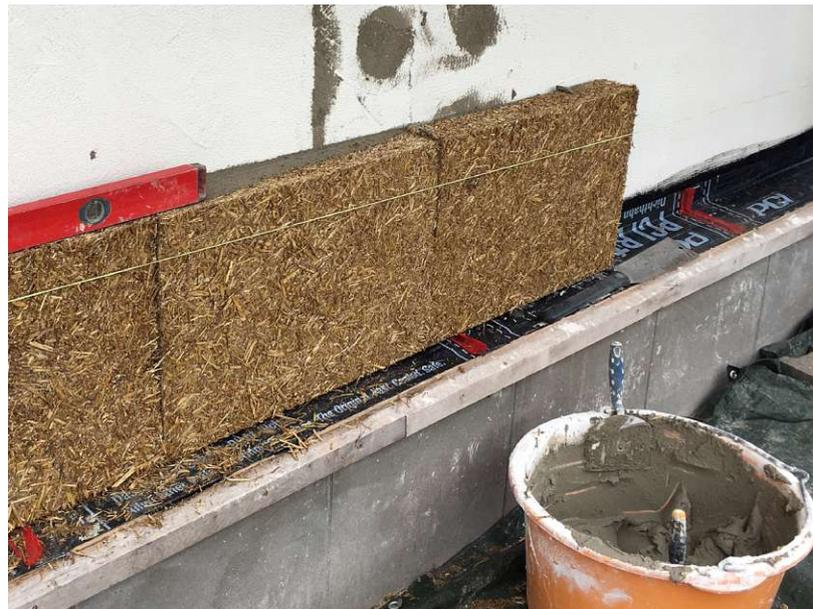
Abb 29 Aufkleben der Strohdämmplatten im Sockelbereich (Foto: Maxit / maxit-strohpanel.de)
