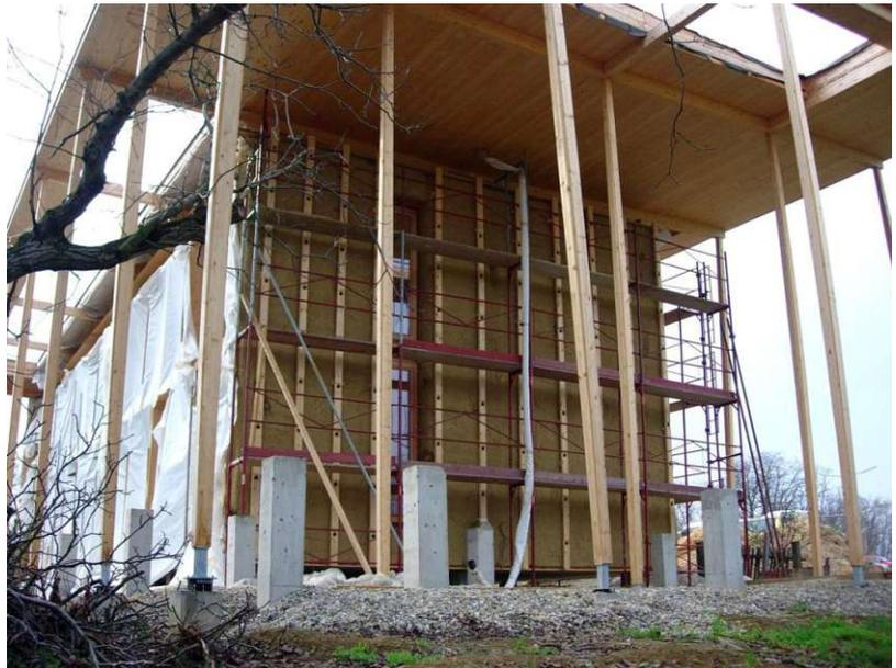
Abb 6 S-House, unterlüftete Bodenplattform, Lehmputz auf Strohbällen, hinterlüftete Fassadenschalung, weiter Dachüberstand (Foto: GrAT)
