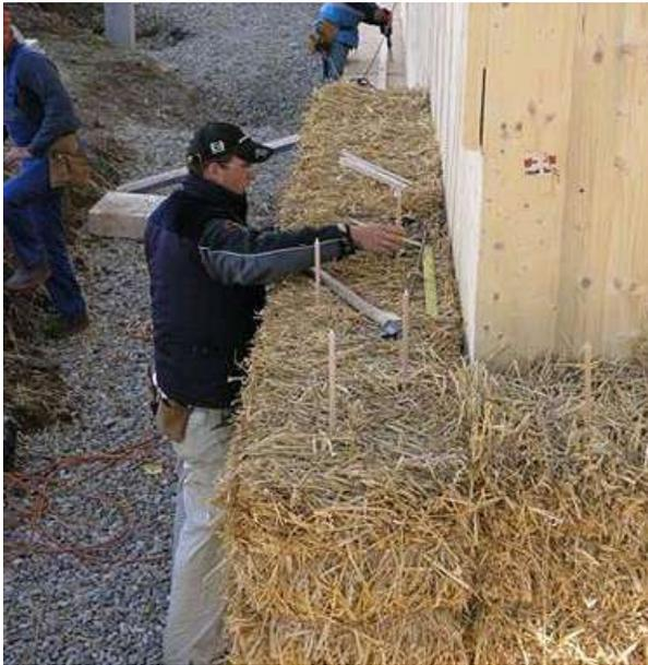
Abb 89 Strohballe-Wrapping vor Massivholzkonstruktion, S-House (Foto: GrAT)
