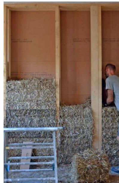
Abb 88 Befüllen der Holzkonstruktion von innen, Verschalung außen mit Holzfaser-Unterdeckplatten (Foto: Herbert Gruber / strohnatur.at)
