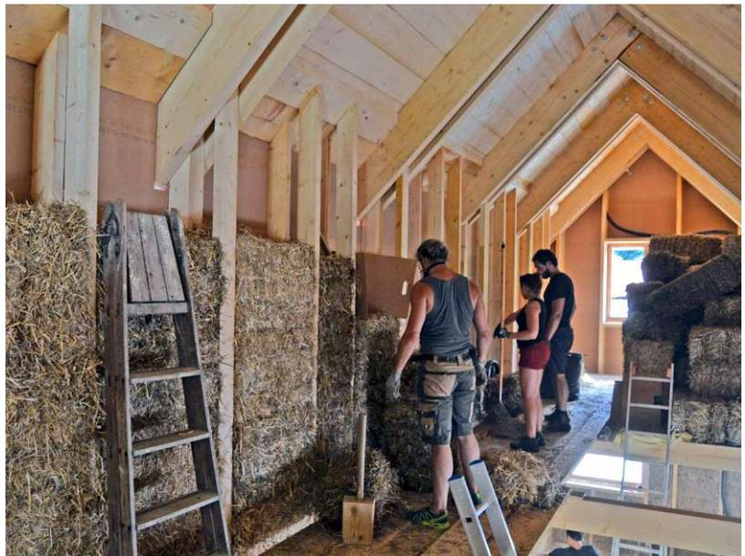
Abb 5 Strohballen-Infill, Ballenlagerung und Verarbeitung im Inneren (Foto: Herbert Gruber / strohnatur.at)
