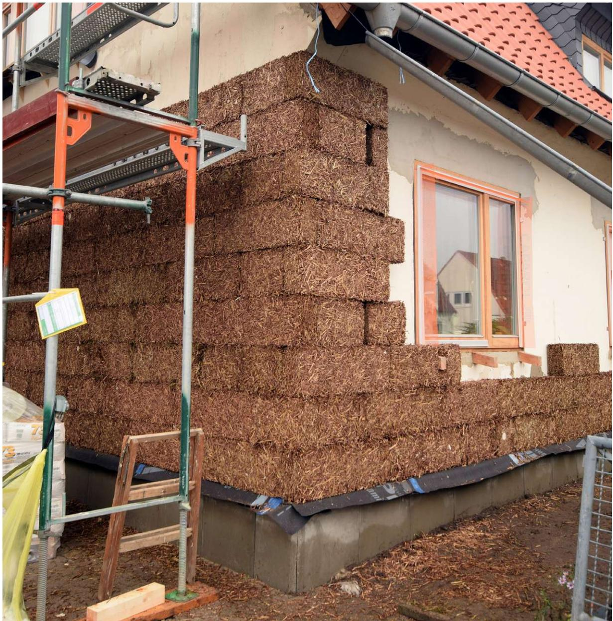
Abb 25 Homogene Fassadendämmung mit Strohdämmplatten (Foto: Maxit / maxit-strohpanel.de)
