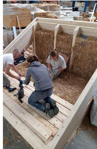
Abb 91 a, b Holzrahmen mit Strohballen-Infill und Rauschalung, Vorfertigung vivihouse-Module
