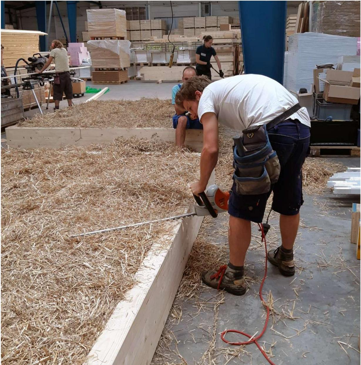
Abb 16 Glätten der Strohballenoberfläche entlang der Holzrahmenkonstruktion
