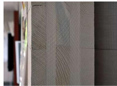
Abb 40 Tragende Massivholz-Zwischenwand
