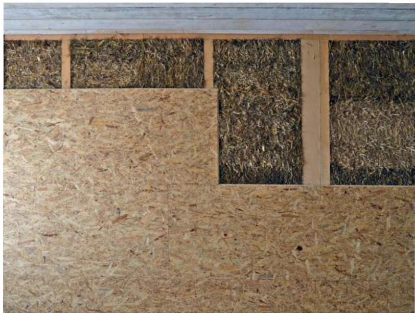
Abb 82 Strohballen in Holzrahmen, Verschalung innen mit OSB (Foto: Herbert Gruber / strohnatur.at)
