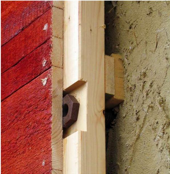
Abb 83 Lehmputz mit hinterlüfteter Fassadenschalung, S-House (Foto: Architekten Scheicher / scheicher.at)
