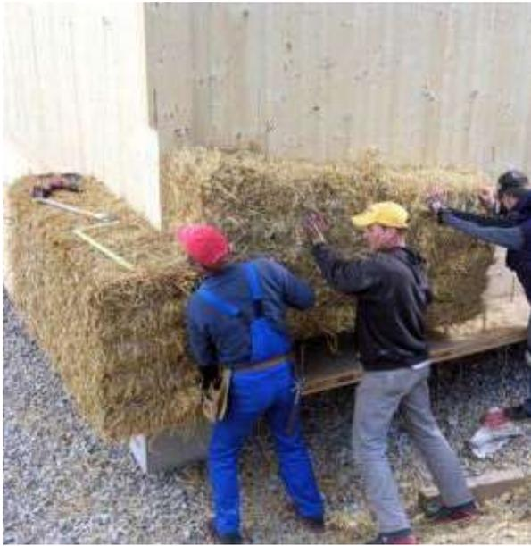
Abb 92 Strohballen-Wrapping, Ballendämmung vor massiver Holzwand, punktuell befestigt, ohne Holzrahmen (Foto: GrAT)
