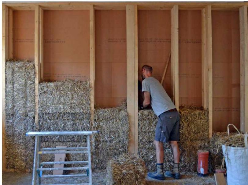
Abb 11 Strohballe-Infill, hochkant stehende und hochkant liegende Balle zwischen Holzstehern (Foto: Herbert Gruber / strohnatur.at)
