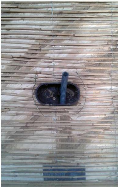
Abb 78 Dichtungsbänder für Übergang zwischen Holz und Lehmputz, Schilfstuckatur als Putzträger
