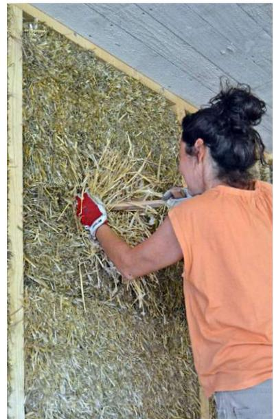
Abb 14 a-d Strohballen-Infill mit rechteckigen Kleinballen, abgetrennten Ballenlagen und Strohbündeln (Fotos: Herbert Gruber / strohnatur.at)
