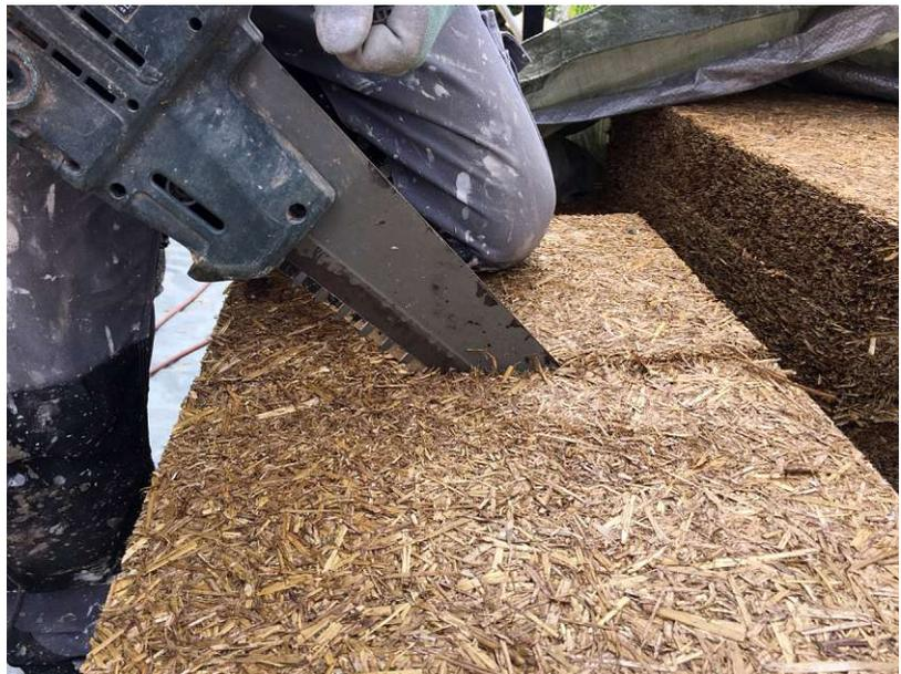
Abb 27 Zuschneiden einer Strohdämmplatte mit Fuchsschwanz-Säge (Foto: Maxit / maxit-strohpanel.de)
