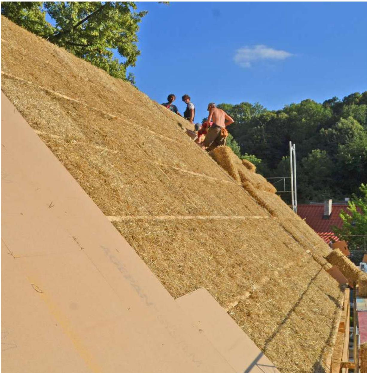
Abb 3 Strohballe-Infill, Einbringung von außen, Verschalung mit feuchtebeständigen Holzfaser-Unterdeckplatten (Foto: Herbert Gruber / strohnatur.at)
