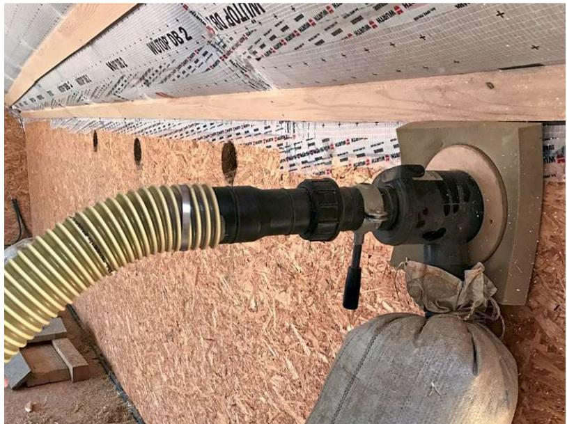
Abb 23 a, b Strohhäcksel-Einblasdämmung, Einbringung von innen, Bauteilinnenseite verschalt mit OSB (Foto: DPM Holzdesign / dpm-gruppe.com)
