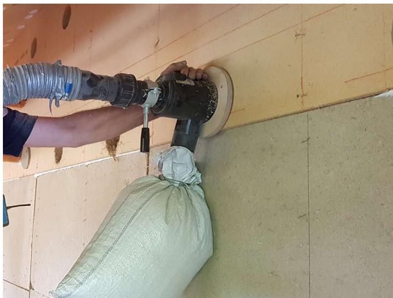
Abb 75 Einbringen der Strohhäcksel von außen, Verschalung mit Holzfaser-Unterdeckplatten (Foto: SonnenKlee / sonnenklee.at)
