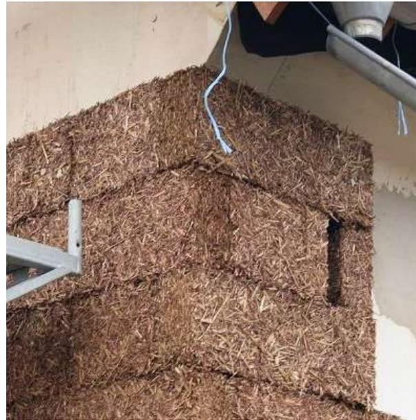
Abb 90 WDVS mit Strohdämmplatten auf Bestandsmauerwerk (Foto: Maxit / maxit-strohpanel.de)
