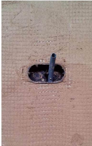
Abb 79 Lehmputz, armiert, Installationsdurchbruch in Lehm eingeputzt
