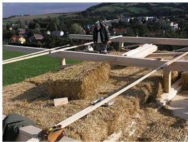
Abb 38 Dämmung der obersten Geschoßdecke
