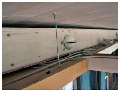
Abb 39 Massivholzdecke mit abgehängter Kabel-
