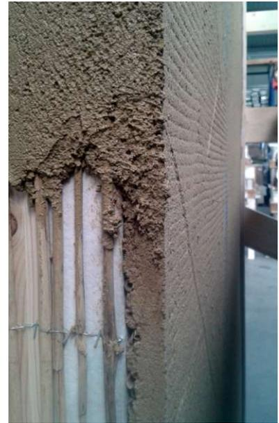
Abb 80 Lehmputz auf Schilfstuckatur, Dichtungsbänder miteingeputzt
