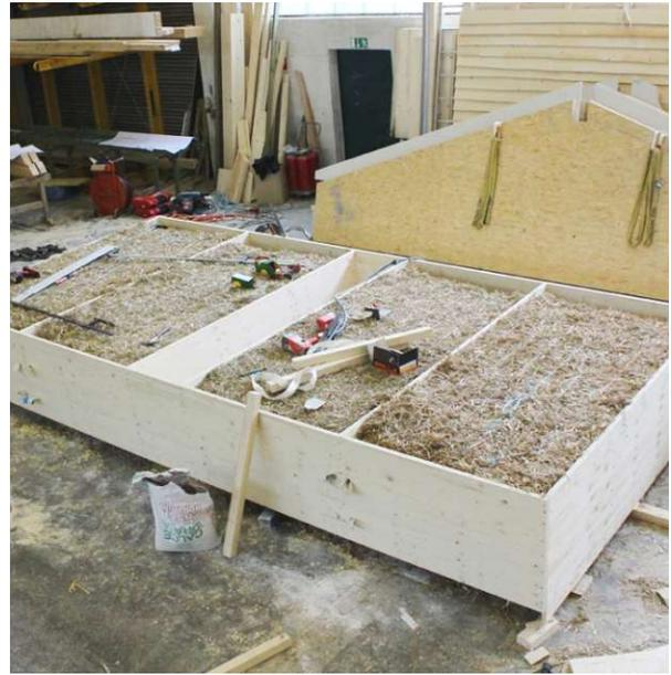
Abb 93 Hybridsystem Holzrahmen und Massivholzplatte, Ballendämmung zwischen Holzstegen, massive Holzrückwand als Bauteilinnenseite (Foto: Atelier Werner Schmid / atelierschmid.ch)
