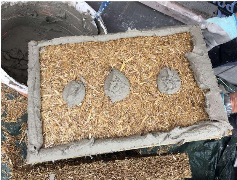
Abb 28 Kleberauftrag auf die Strohdämmplatte im Punkt-Wulst-Verfahren für die Verklebung auf Mauerwerk
