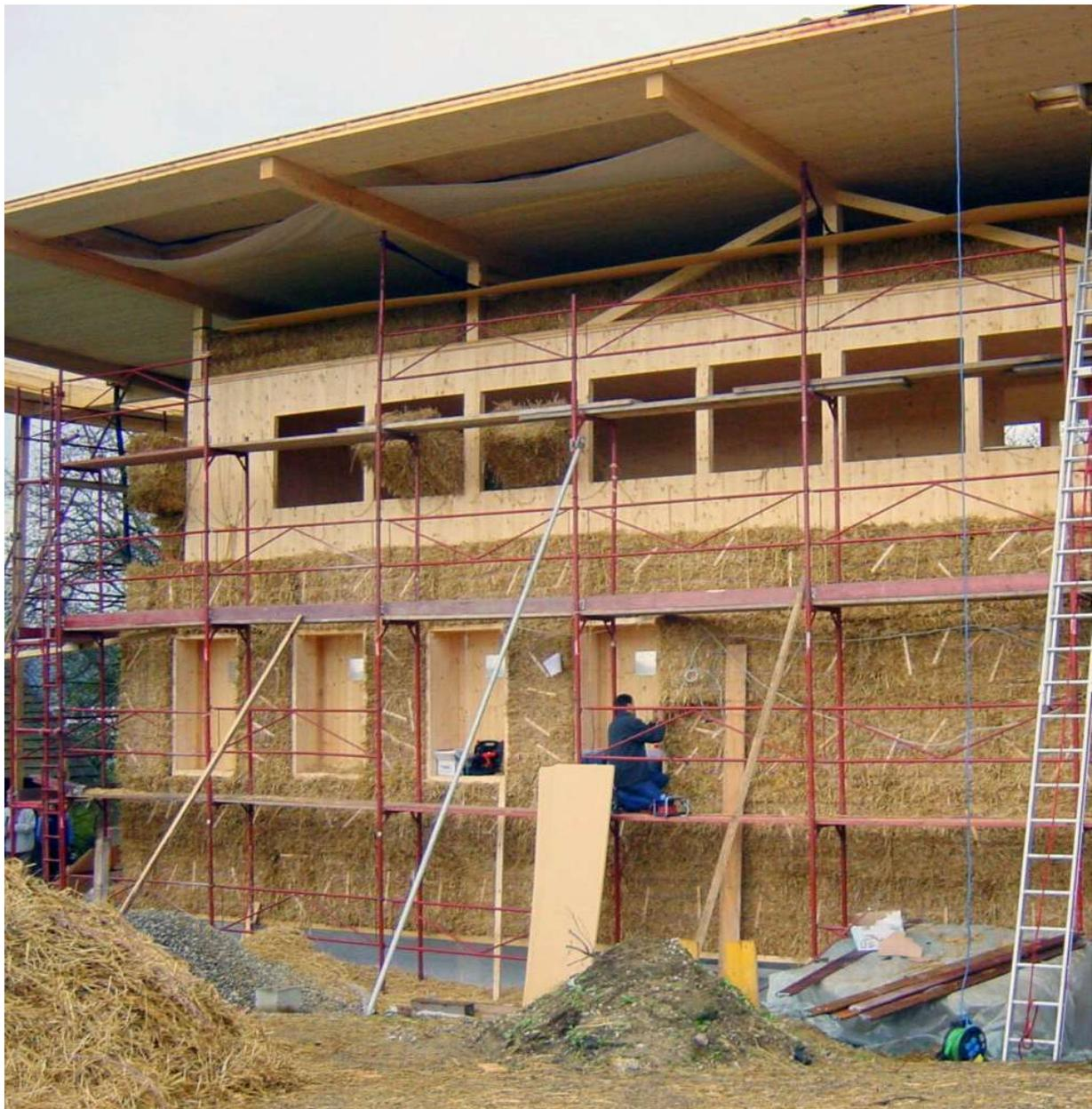
Abb 17 Strohballe-Wrapping vor massiver Holzkonstruktion, S-House (Foto: Architekten Scheicher / scheicher.at)
