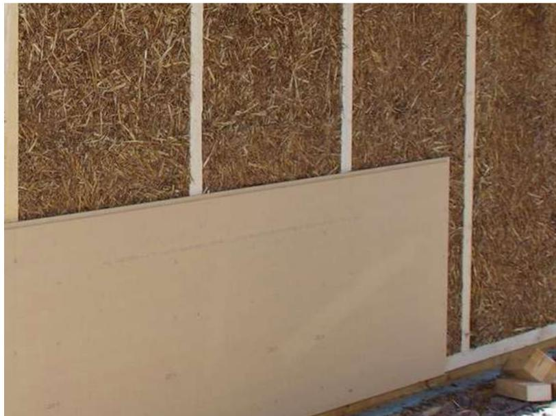
Abb 32 Strohdämmplatten zwischen Holzkonstruktion, winddichte Verschalung mit Holzfaser-Unterdeckplatten (Foto: Maxit / maxit-strohpanel.de)
