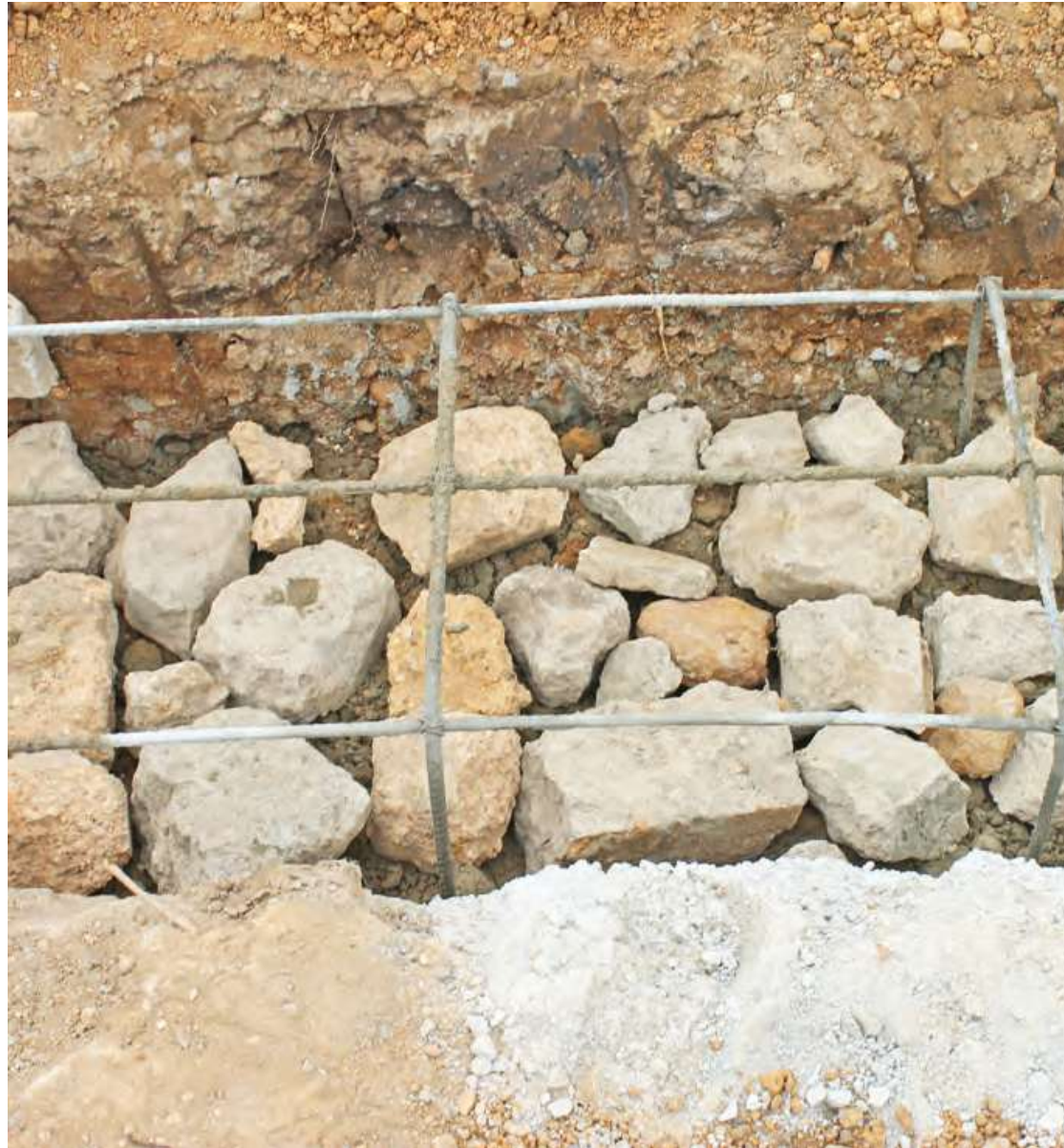
Abb. 94: Sauberkeitsschicht für das Fundament fig. 94: subbase concrete for the foundation
