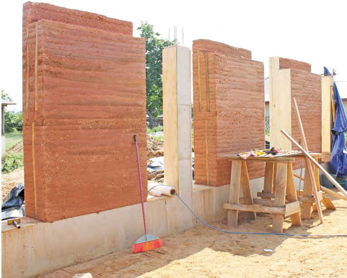
Abb. 135: Stampflehmwände fig. 135: rammed earth walls
