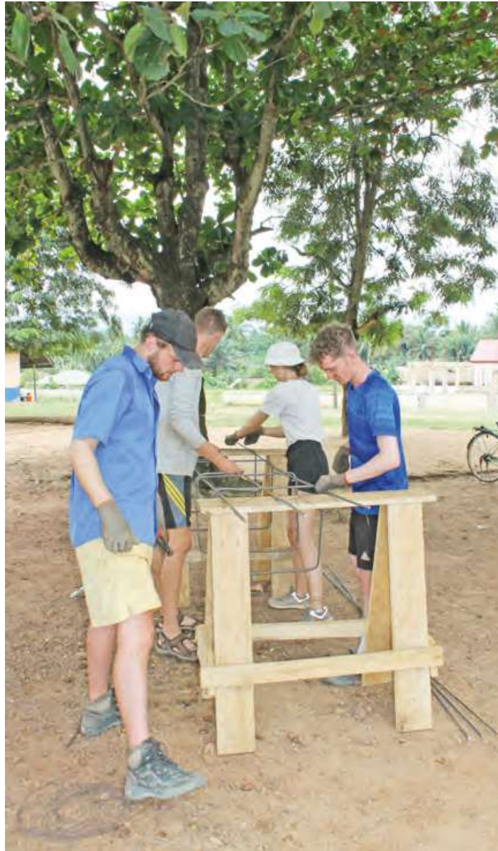
Abb. 97: Binden der Stahlbewehrung - Schritt 01 fig. 97: tying the steel reinforcement - step 01
