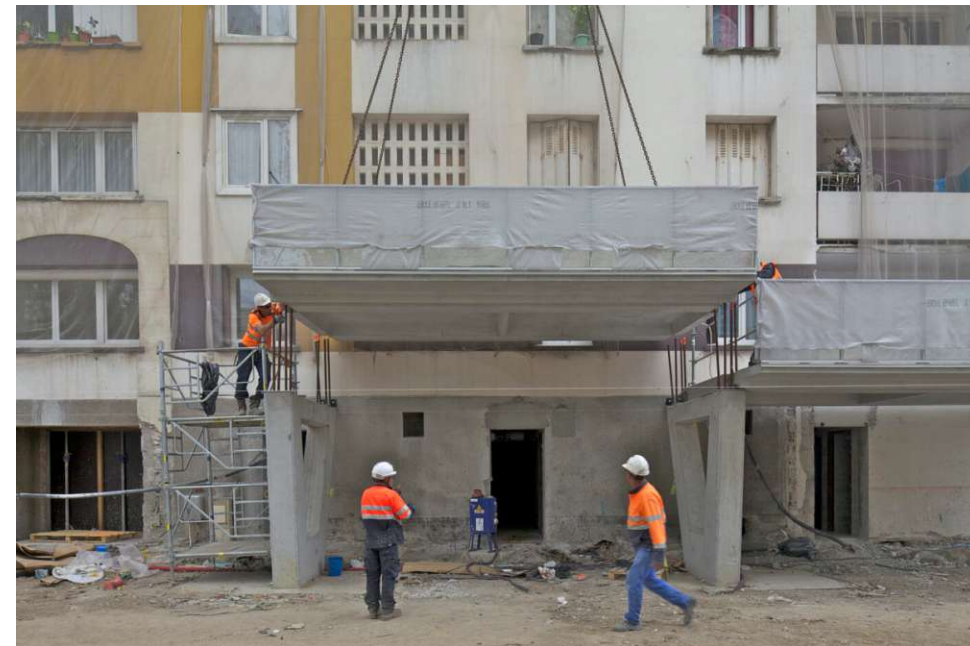
Abb. 10: Cité du Grand Parc, Bauprozess Quelle: Ruault, 2016
