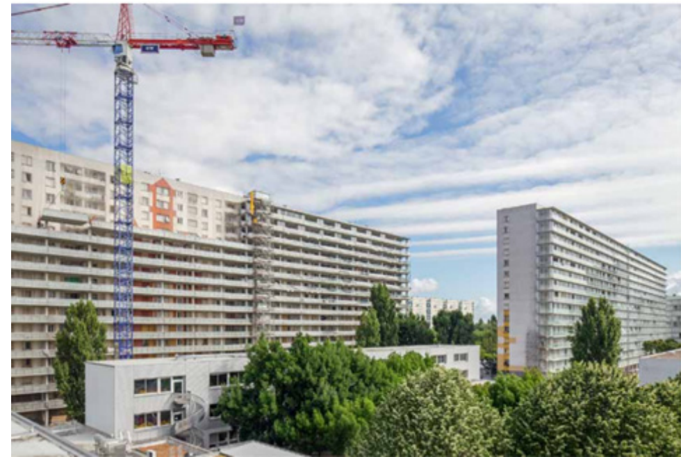
Abb. 6: Cité du Grand Parc, Montage der vorgesetzten Betonmodule Quelle: Ruault, 2016
