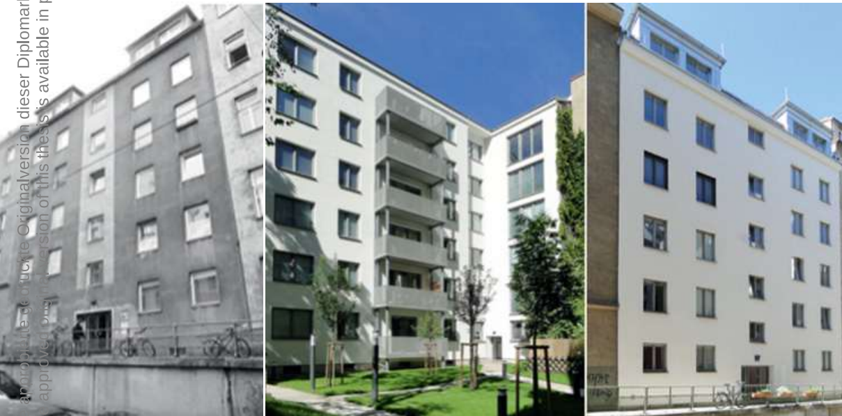
Abb. 5: Trappelgasse 3, vor und nach der Sanierung Quelle: Wohnfonds Wien, 2022, S.24
