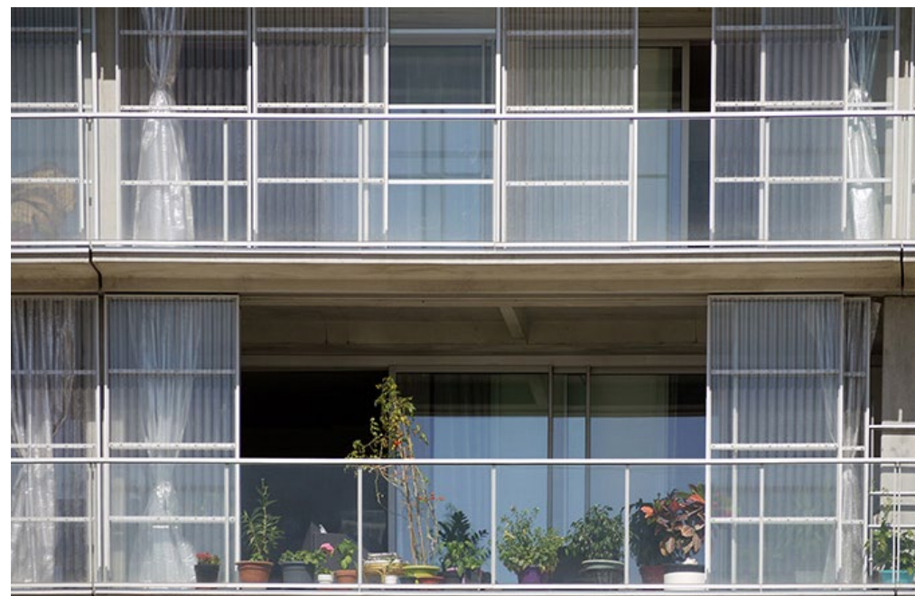
Abb. 14: Cité du Grand Parc, Lacaton et Vassal Quelle: Ruault, 2016
