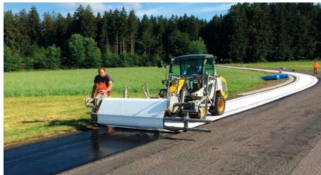
Abb. 124: Einbau eines Geotextilvlieses mit RFID-TAG, S. 404
