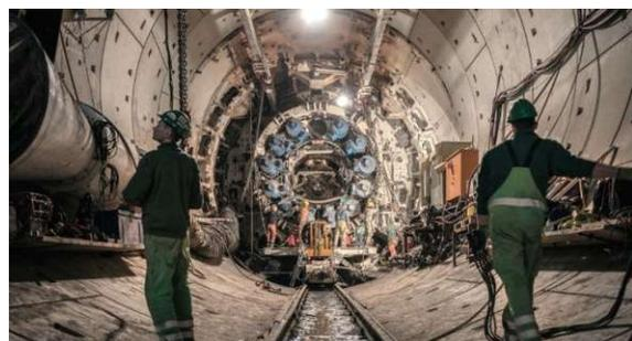
Abb. 127: TBM und Tübbingebau, S. 404
