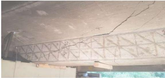
Abb. 128: Risse in Stahlbetonbrücke, S. 405
