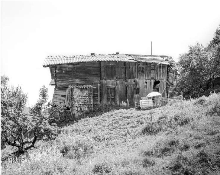
Unschwer erkennt man das sich krümmende Gebäude. Bei genauerer Betrachtung kann man das Abrutschen des Backsteinfundaments als eine der Ursachen entziffern. Auch das notdürftige temporäre Dach ist mittlerweile selbst baufällig geworden.
