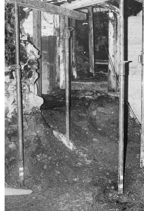
Das Erdgeschoss, im wahrsten Sinne. Der Fußboden wurde händisch um 60cm abgegraben um eine größere Raumhöhe zu erhalten.
