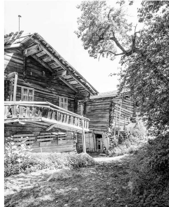
Unübersehbarer aufgeschobener Erhaltungsaufwand - gut erkennbar sind die inzwischen windschiefen Wände, man erkennt die Beweglichkeit der "Verstrickung".
