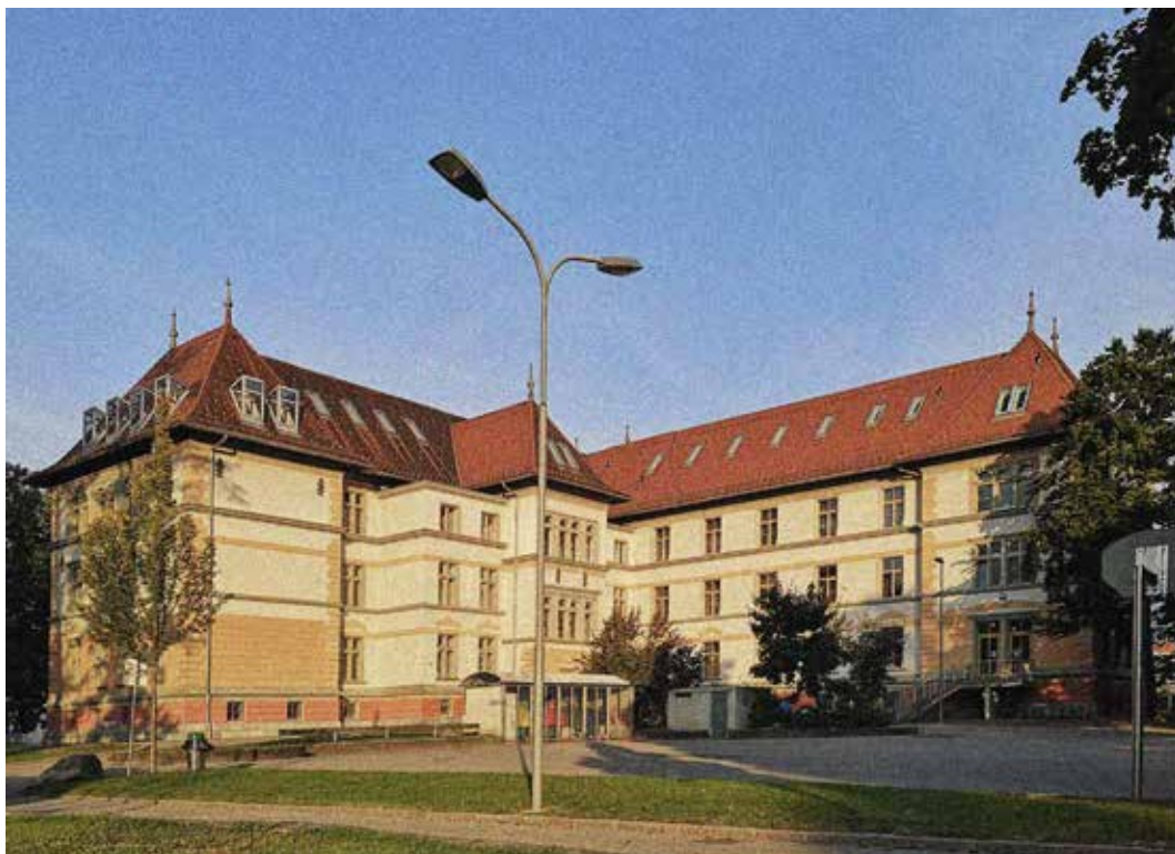
Blick in den Schulhof
