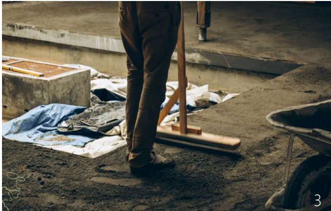
Abb. 158: Verdichten
