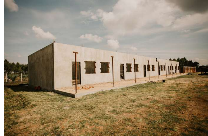
Abb. 9: Rohbau der Schule im Jahr 2019
