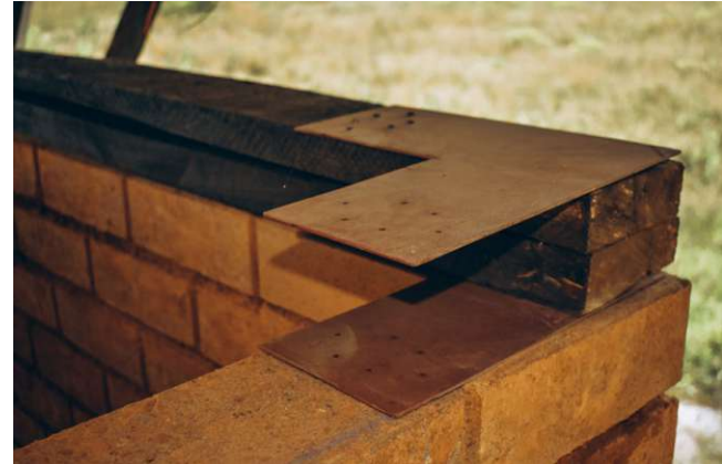
Abb. 147: Holzringbalken mit Stahleckprofil
