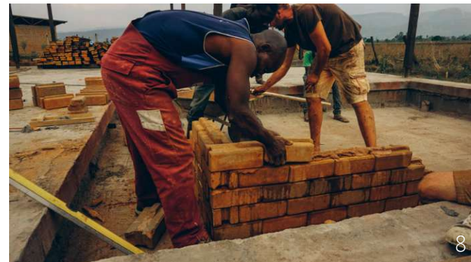
Abb. 127: Ziegel werden aufeinander gestapelt
