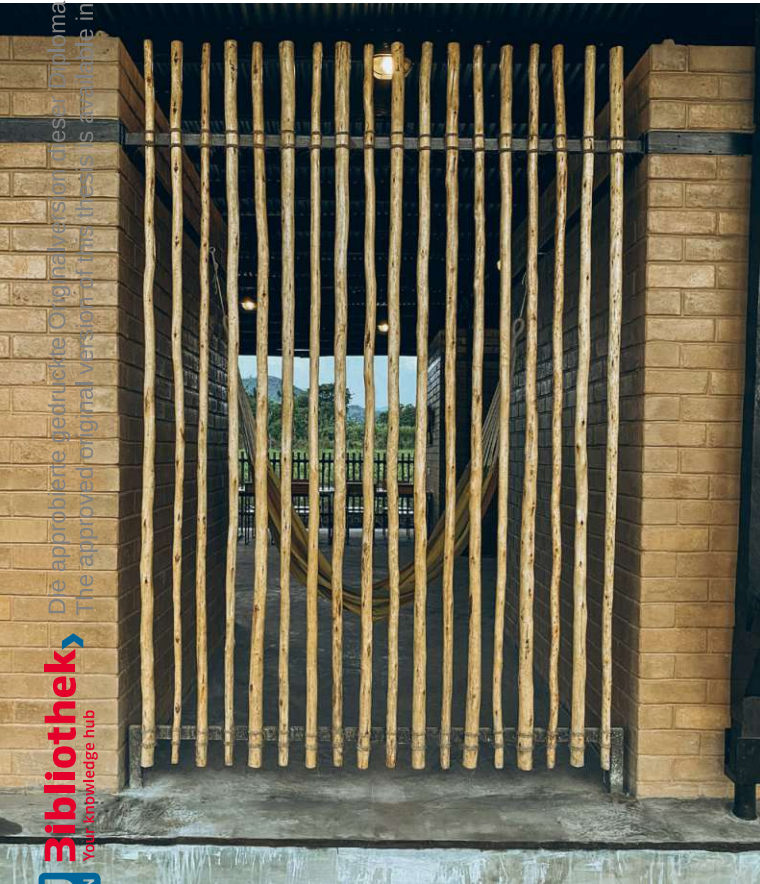
Abb. 73: Visueller Raumabschluss in Form von Holzlamellen
