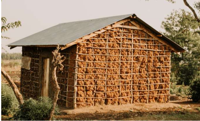
Abb. 37: Holztragwerk ausgefacht mit Murram, Wellblechdach
