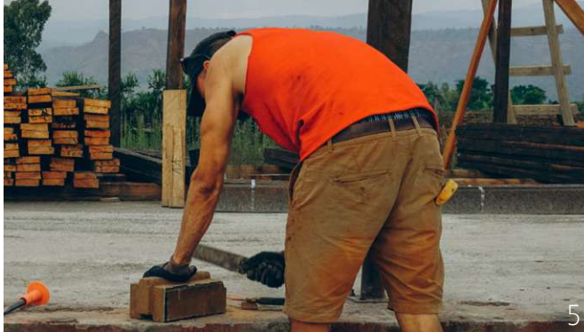
Abb. 124: Ziegel für Eckverbindung werden zugeschnitten
