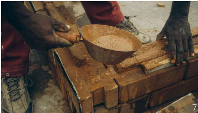
Abb. 126: Mörtel wird hinzugegeben
