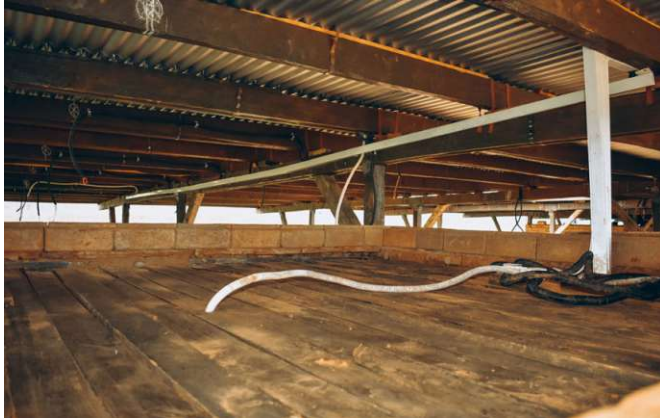
Abb. 140: Holzschalung auf Holzbalken
