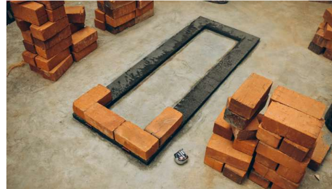
Abb. 170: Gebrannte Lehmziegel auf Zementbett mit DPM-Folie
