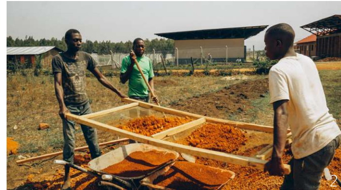
Abb. 121: Murrum wird gesiebt (50x50mm)
