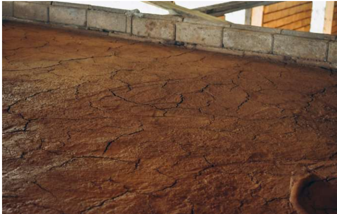
Abb. 142: Erste Schicht Murram im trockenen Zustand
