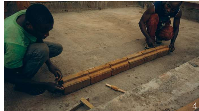
Abb. 123: Ziegel werden mittels Schnur gerade positioniert
