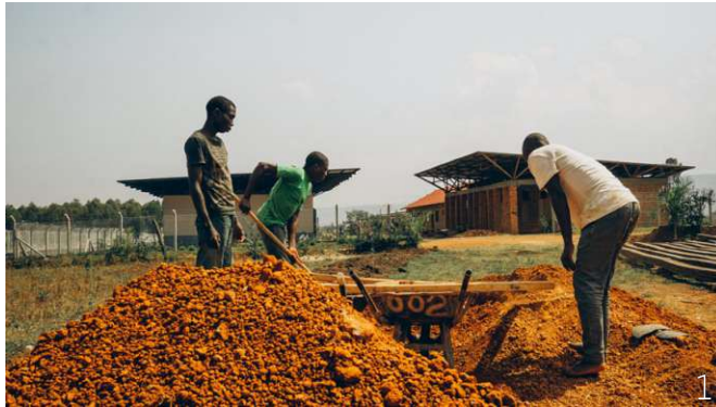
Abb. 120: Murrum wird ins Sieb geschaufelt
