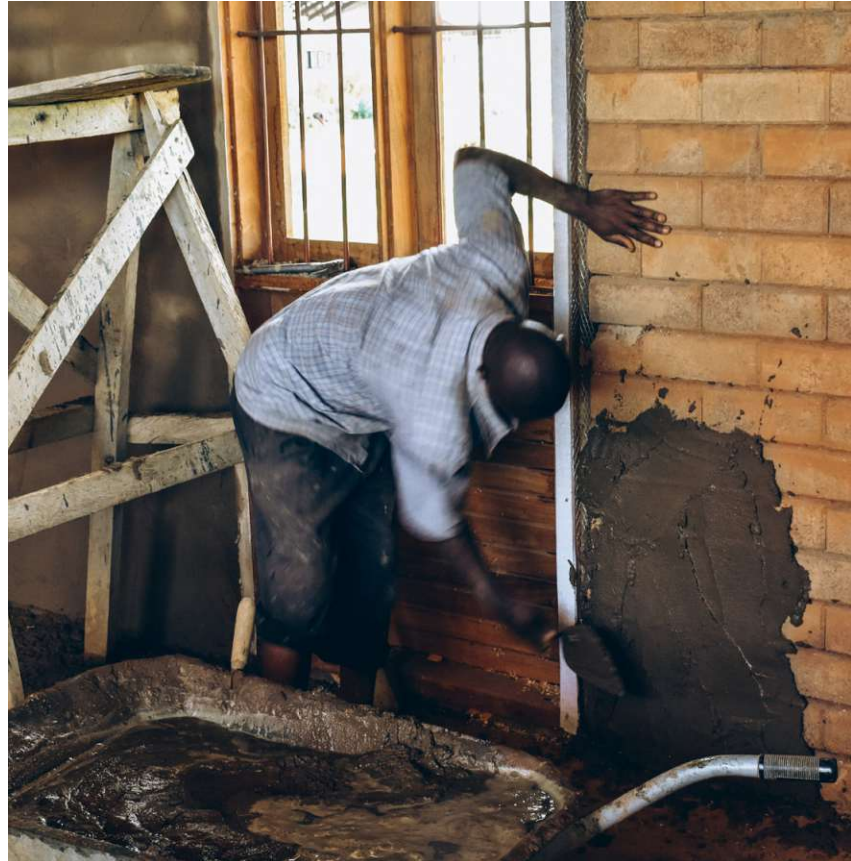
Abb. 135: Erste Putzschicht wird aufgetragen Abb. 136: Dritte Putzschicht wird (S. 131)
