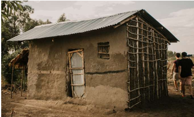
Abb. 39: Holz-Lehmhütte mit Außenputz aus Kuhdünger, Wellblechdach
