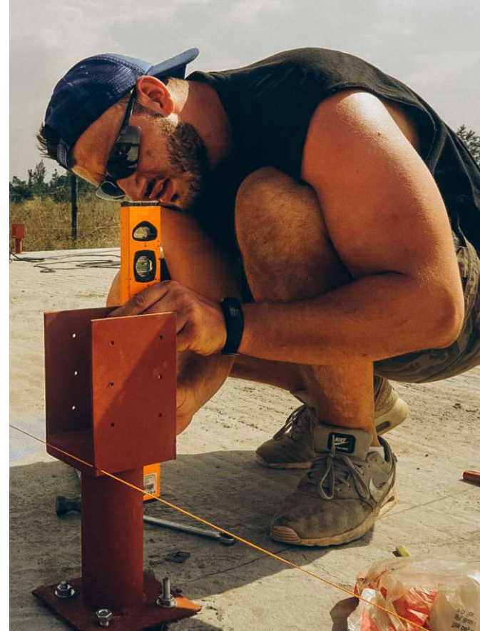
Abb. 99: David montiert Stützenfüße
