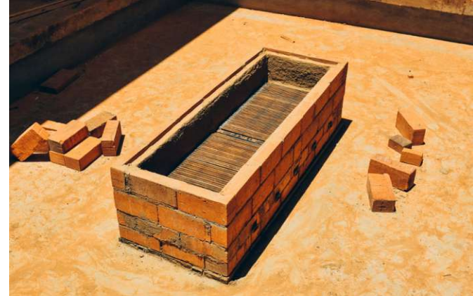
Abb. 171: Feuerstelle unverputzt
