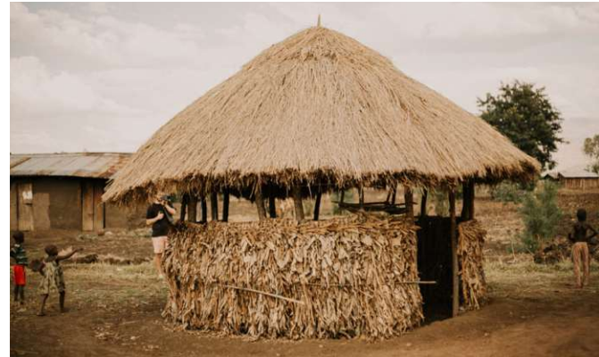
Abb. 40: Holztragwerk mit getrockneten Bananenblättern, Strohdach
