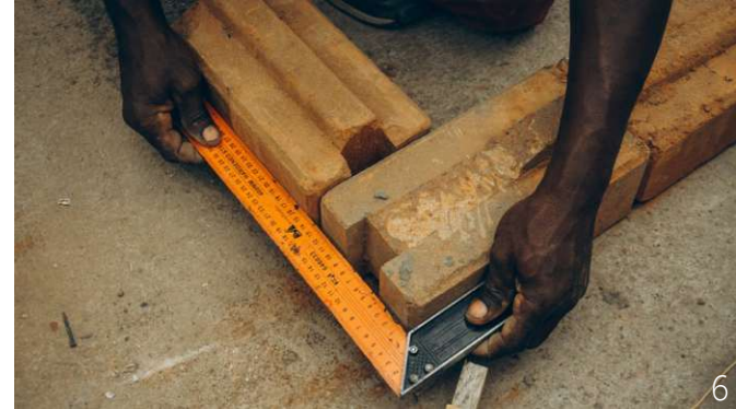
Abb. 125: Ziegel für Eckverbindung werden im rechten Winkel positioniert
