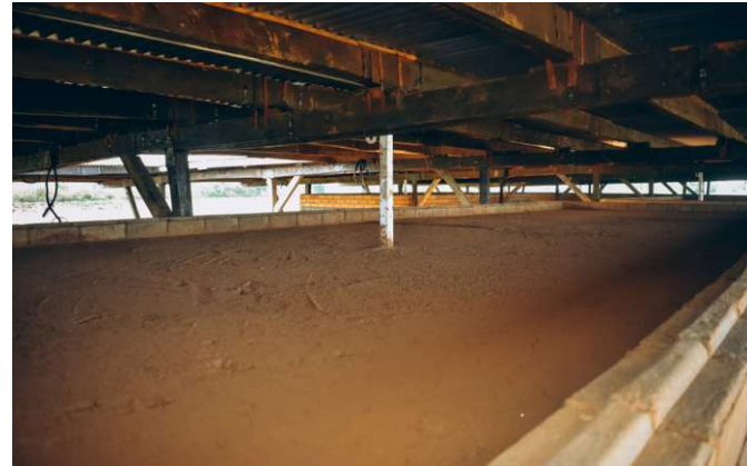
Abb. 143: Zweite Schicht Murram im trockenen Zustand (fertige Decke)
