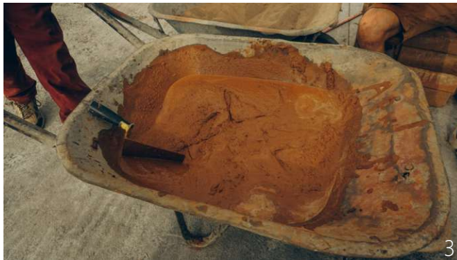
Abb. 122: Murrum wird mit Sand, Zement (8%) und Wasser zu Mörtel vermengt
