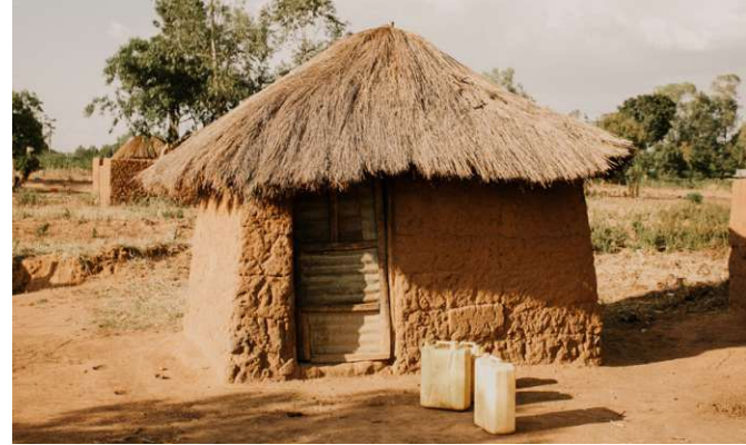
Abb. 38: Baukörper aus Murramblöcken, Strohdach
