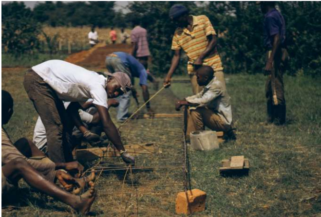
Abb. 82+84: Stahlstäbe werden zu Bewehrungsgitter gebunden (S. 90+91)
