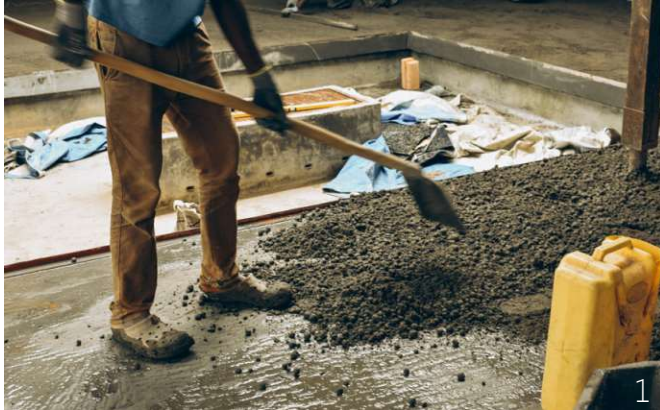
Abb. 156: Zementmischung am Boden verteilen
