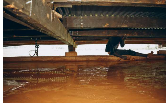
Abb. 141: Erste Schicht Murram im feuchten Zustand
