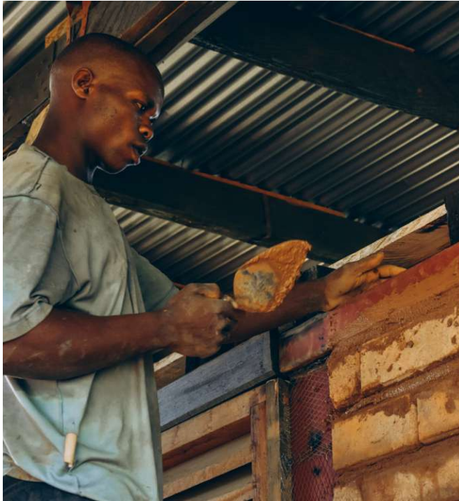
Abb. 130: ISSB-Ziegel werden vermauert
