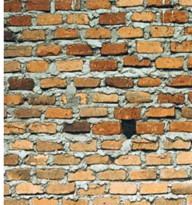
Abb. 129: Mauerwerk mit gebrannten Ziegeln und Zementmörtel
