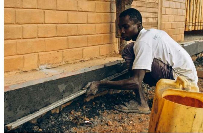
Abb. 153: Glattstreichen des Zementmörtels
