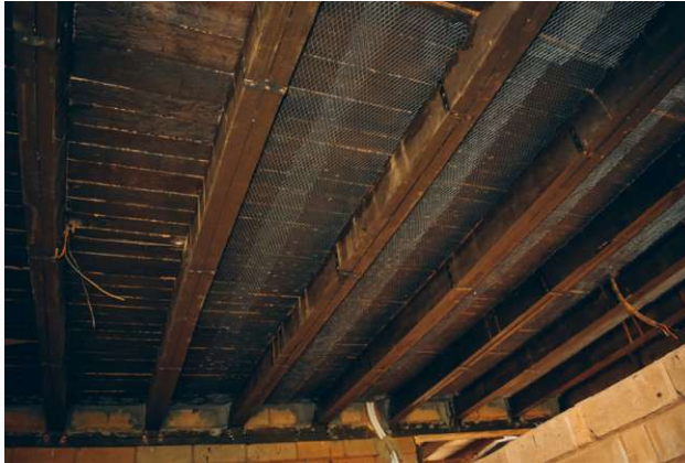
Abb. 145: Decke von unten mit Putzträger
