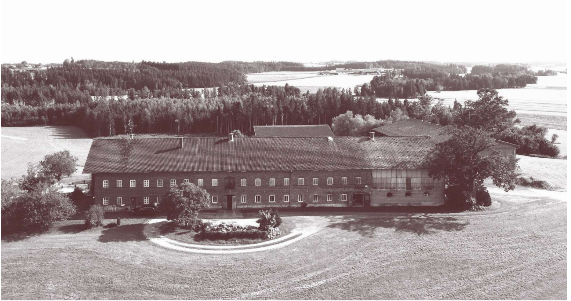
Abb. 51: Nordseitiges Fassadenbild des geziegelten »Lugner-Hofes« in Lueg.
