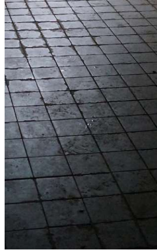
Abb. 76: Kleinformatige, gebrannte Fliesen in der ursprünglichen Waschküche.
