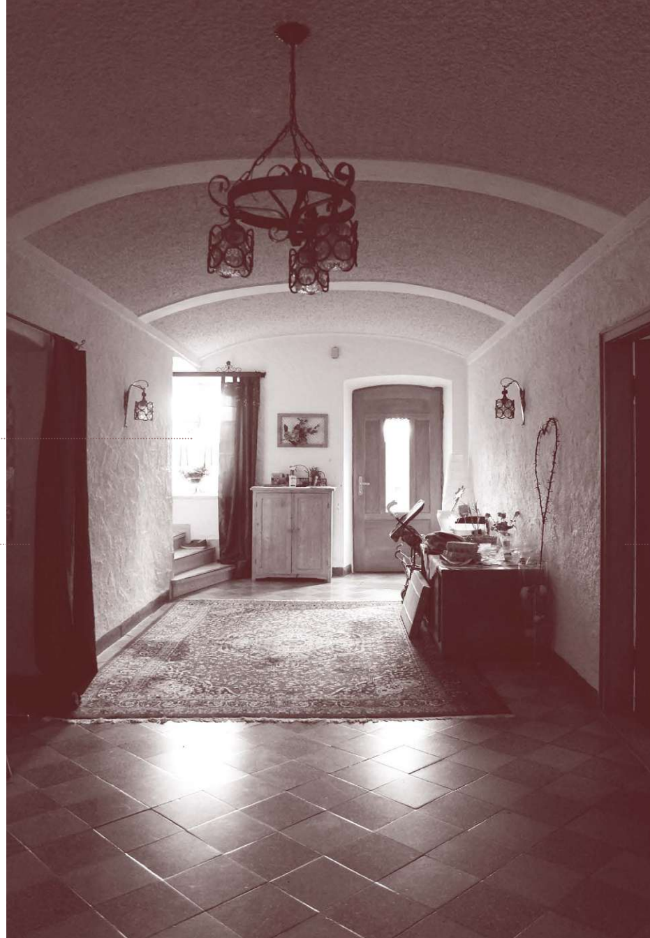
Abb. 23: Typisches Tonnengewölbe mit Putzbändern im Fletz.
