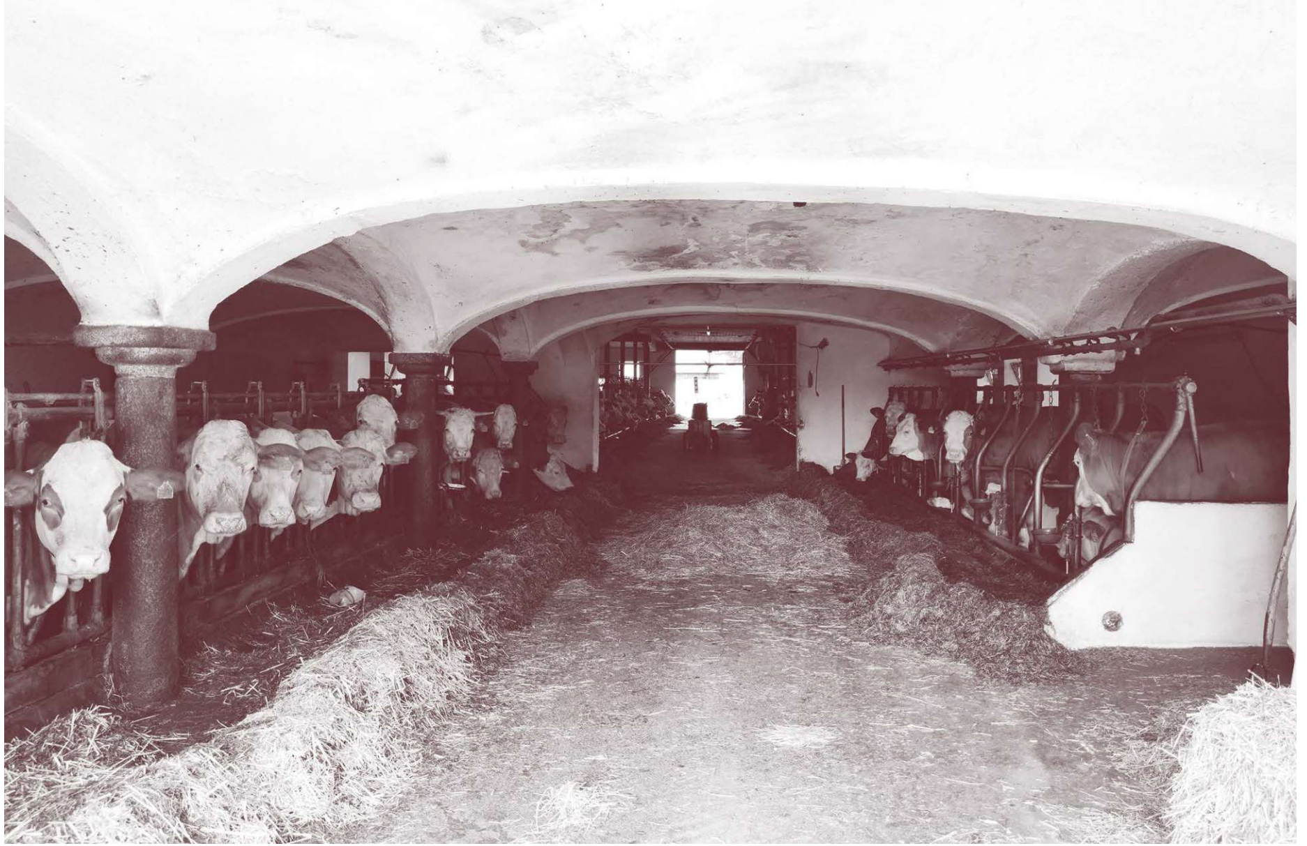
Abb. 26: Kuhstall mit böhmischem Gewölbe.
