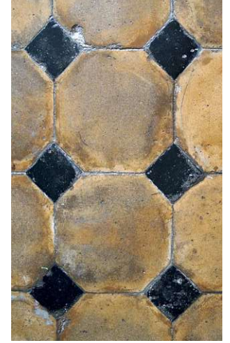
Abb. 78: Gebrannte und anschließend glasierte Fliesen im Fletz des »Staller-Hofes«, 1906.
