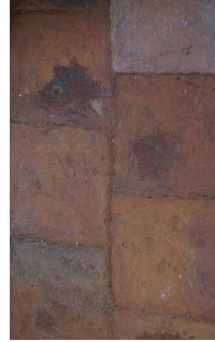
Abb. 77: Gebrannte diffusionsoffene Lehmplatten im feuchten Keller-raum des »Lugner-Hofes«.
