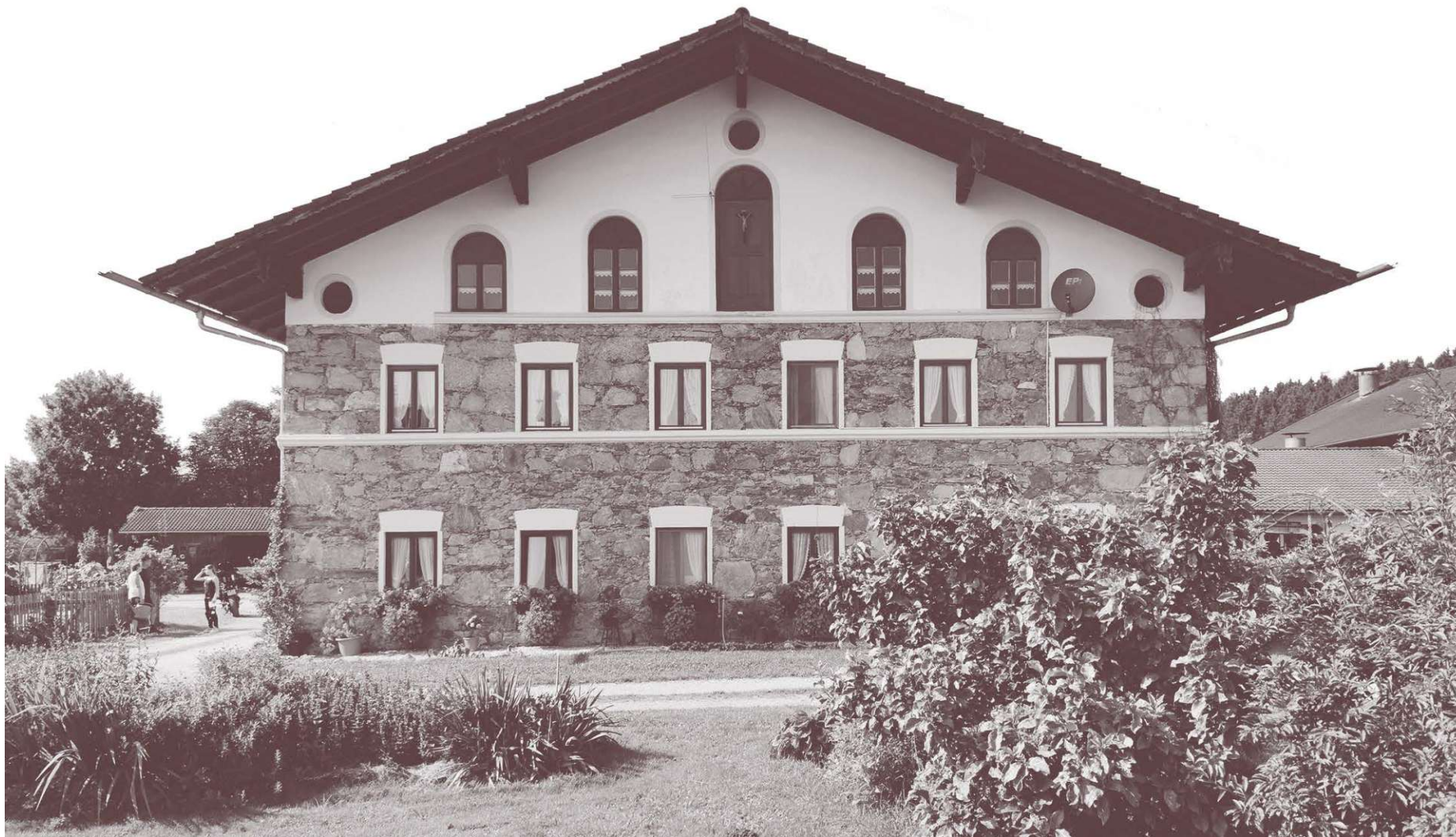
Abb. 57: Bruchstein-Mischmauerwerk, Moosen bei Wasserburg, 1872.
