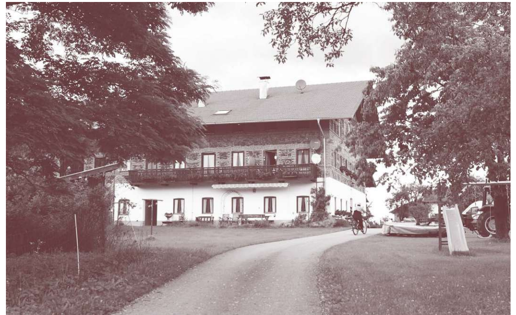
Abb. 87: Nachträglich hinzugefügter Holzbalkon entlang der Südfassade des Wohntraktes beim ›Adlmaier-Hof‹, Sonnendorf.
