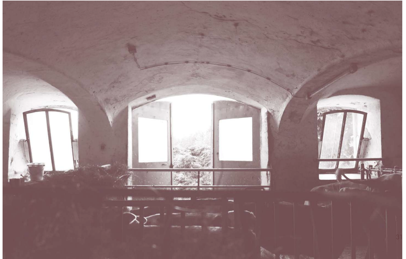
Abb. 26: Gliederung des Stallbereiches durch böhmische Gewölbekappen.
