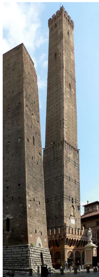
27. Torre Asinelli, Bologna. Mit 97 Metern Höhe trotz die Steinstruktur dem Zahn der Zeit
