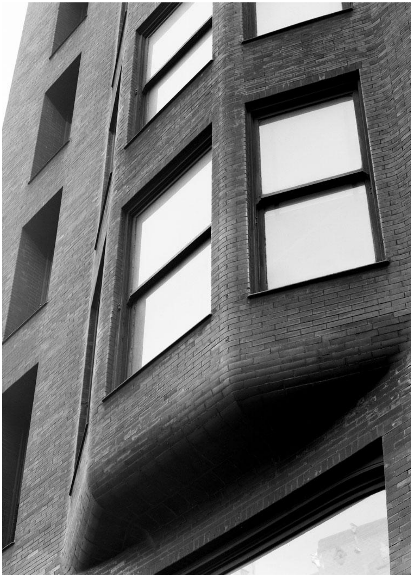
23. Detail eines auskragenden Baywindows
