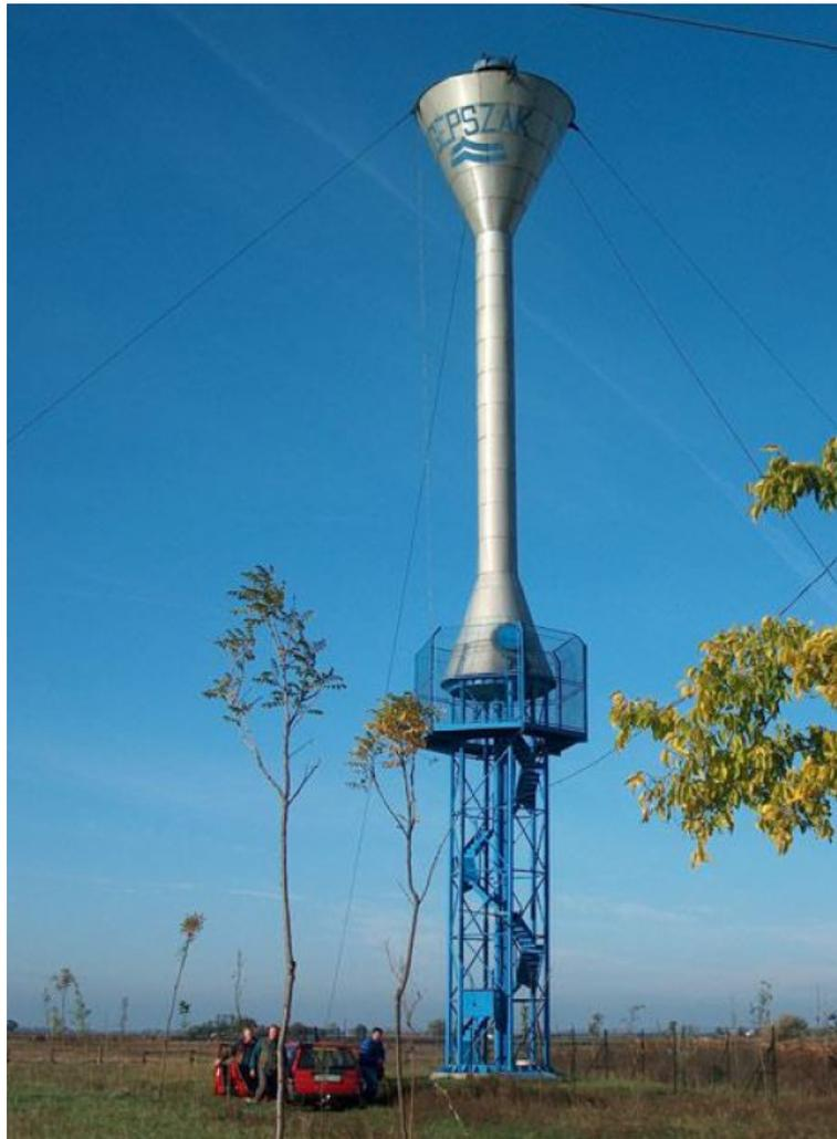
Abb. 1.1: Aufgeständerter Standardwasserturm [4]
