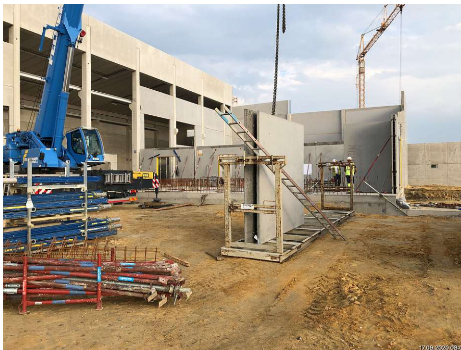
Abb. 4.10: Verwendung von Hohlwänden auf einer Baustelle (Eigene Baustellenaufnahme)
