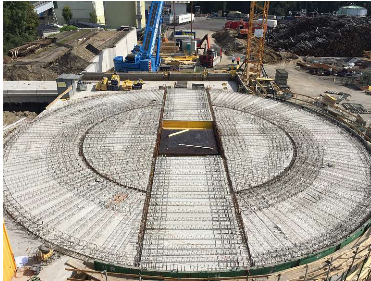
Abb. 4.11: Verwendung von Elementdecken auf einer Baustelle (Eigene Baustellenaufnahme)
