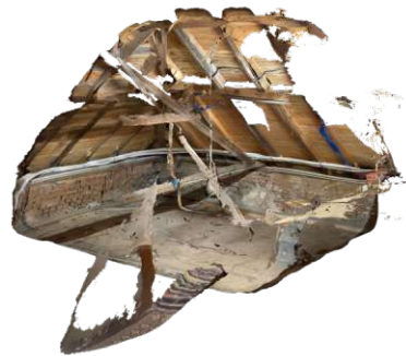
Abb. 2.7: Punktwolke einer Dachstuhlkonstruktion mittels iPad LiDAR-Scan
