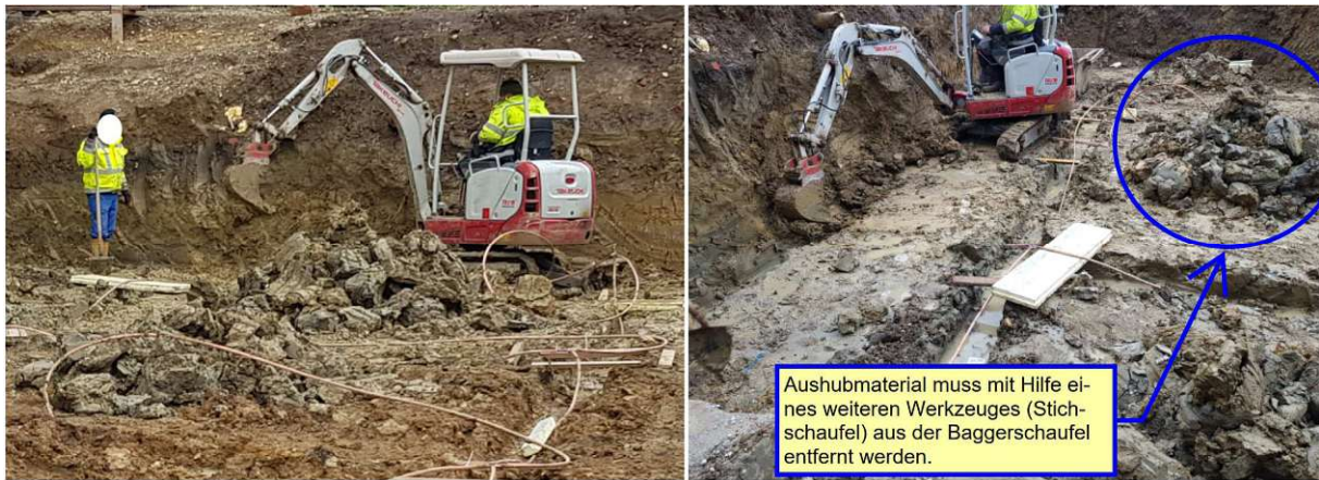
Abb 13: Arbeiten in klebrigen Böden – zusätzlicher Einsatz von Personal und Produktivitätsverlust
