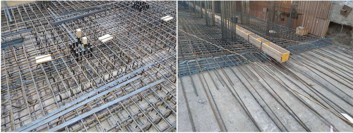
Abb 19: Fundamentbewehrung mit einem besonders hohen Grad an feingliedriger Bewehrung
