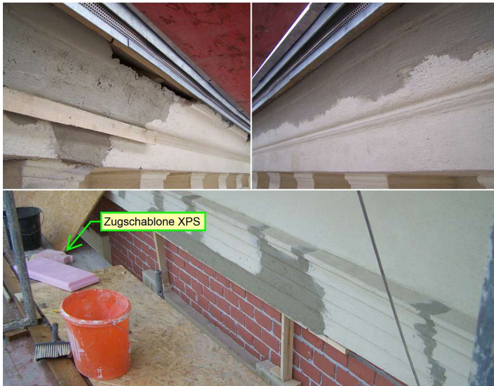
Abb 27: Herstellen von Schablonen und Lehren für Zugarbeiten
