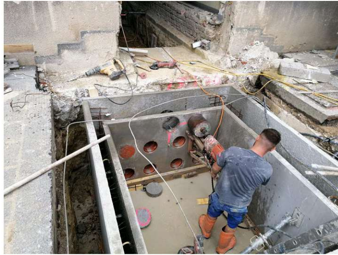
Abb 39: Bohrungen durch Doppelwände.
