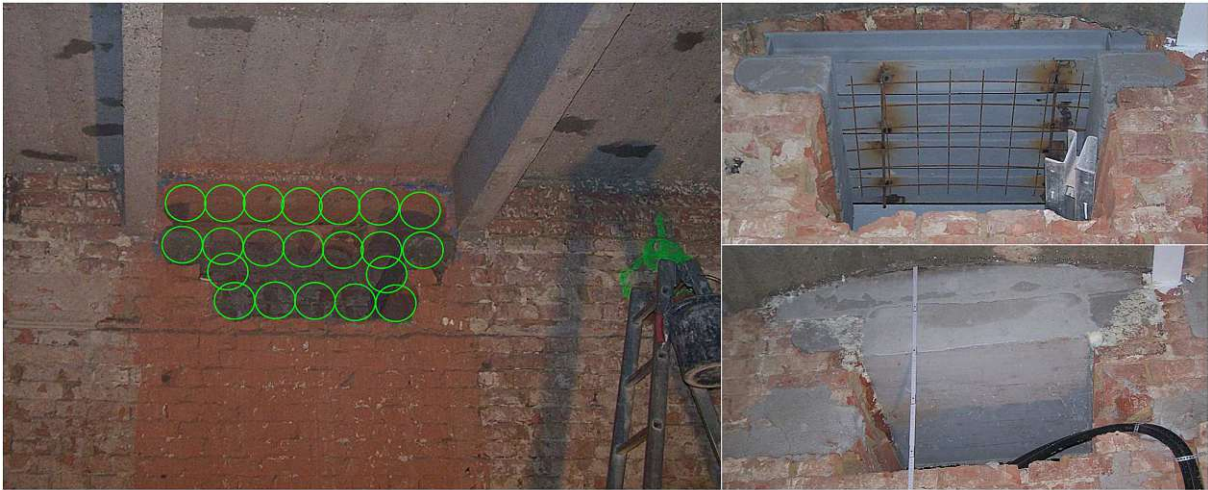
Abb 10: Herstellung Unterfangung halbseitig mittels Kernbohrungen Wandstärke 75,00 cm. In grün wurden die Ansatzstellen der einzelnen Kernbohrungen (21 STK) markiert.
