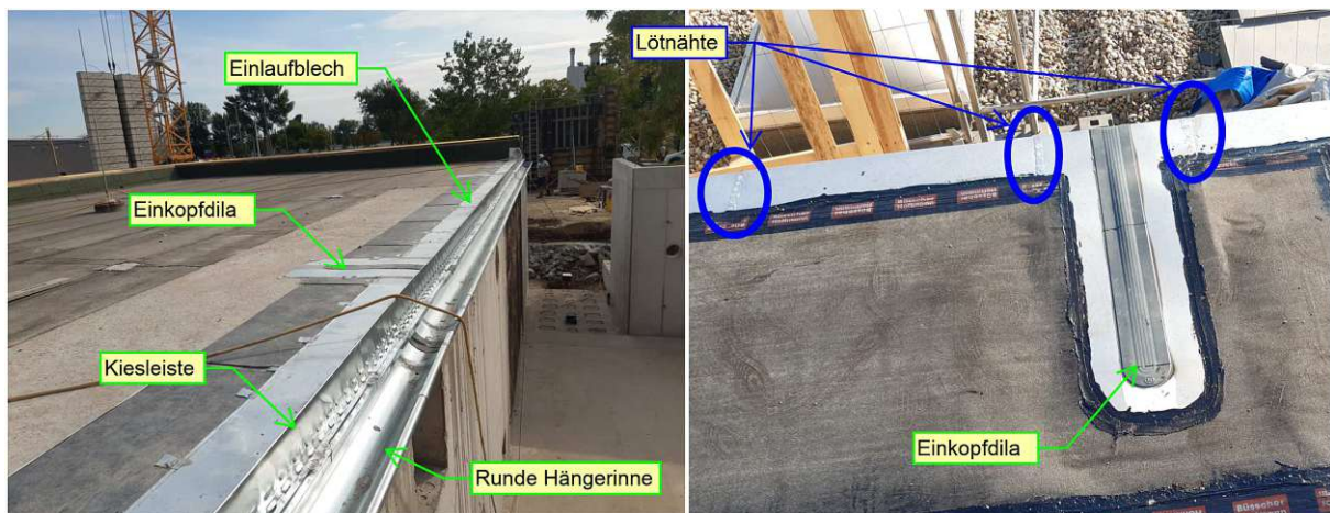
Abb 47: Traufenausbildung Flachdach
