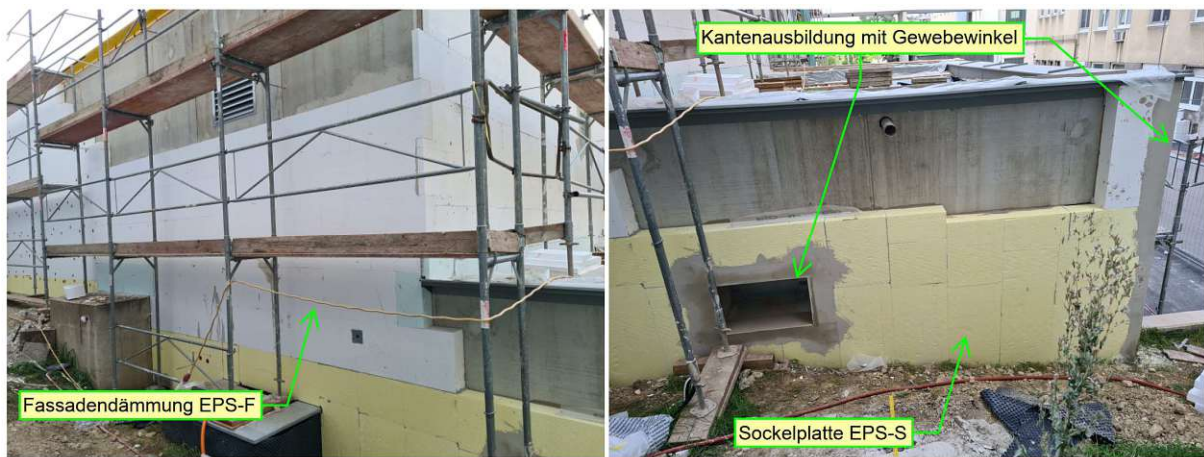
Abb 52: Unterer Fassadenabschluss mit EPS-S Sockelplatten und Gewebewinkel bei Gebäudeecken
