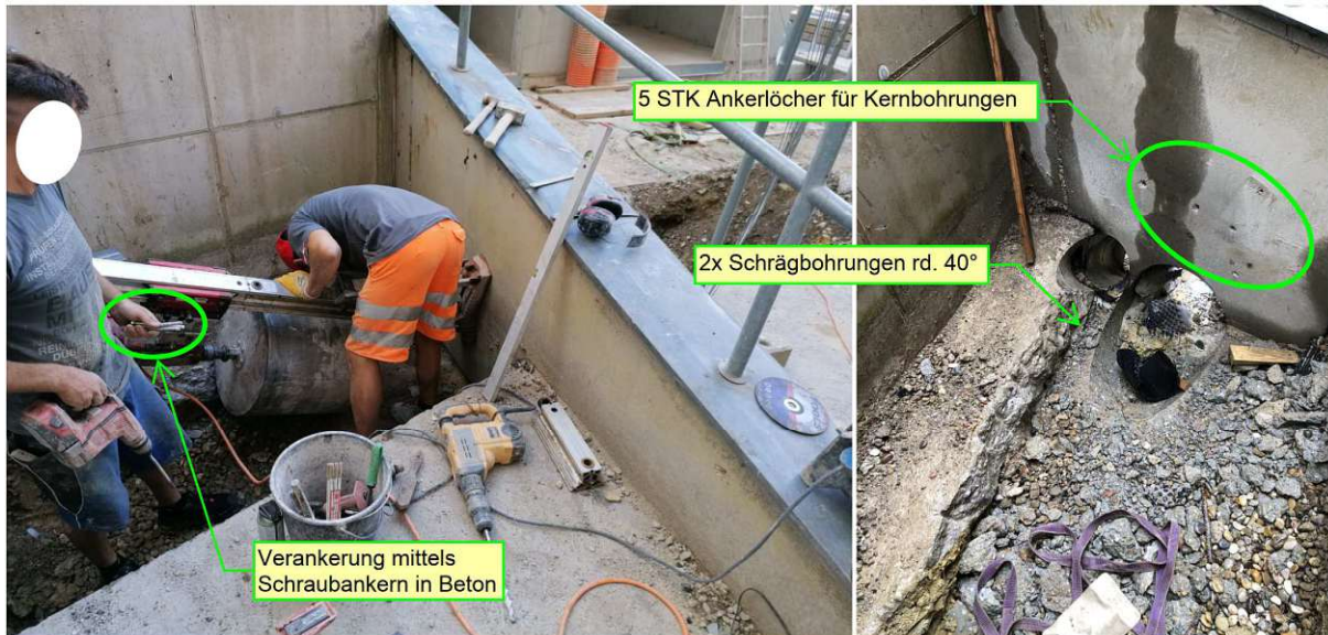
Abb 38: Montage eines Kernbohrgerätes zur Herstellung von Schrägbohrungen.
