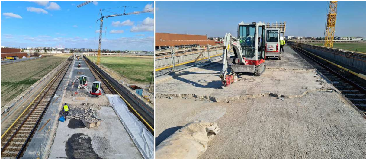
Abb 9: Da eine direkte Zufahrt zum Ort der Leistungserbringung nicht möglich ist, muss das Material zwischengelagert werden
