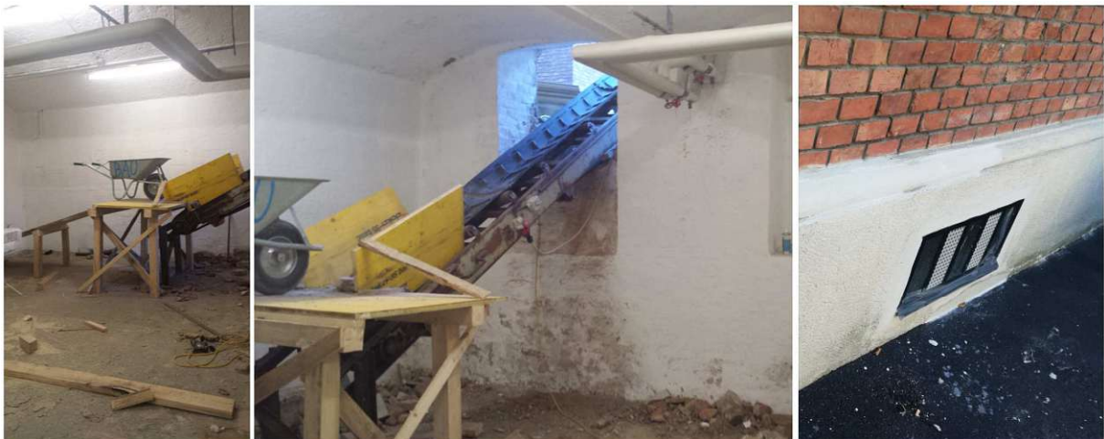
Abb 11: Herstellen und Rückbau von Einbringöffnungen - Organisation von Förderart und Förderweg
