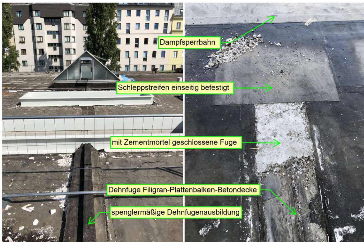
Abb 42: Ausbildung eines Schleppestreifens bei einem bituminösen Dachabdichtungssystem
