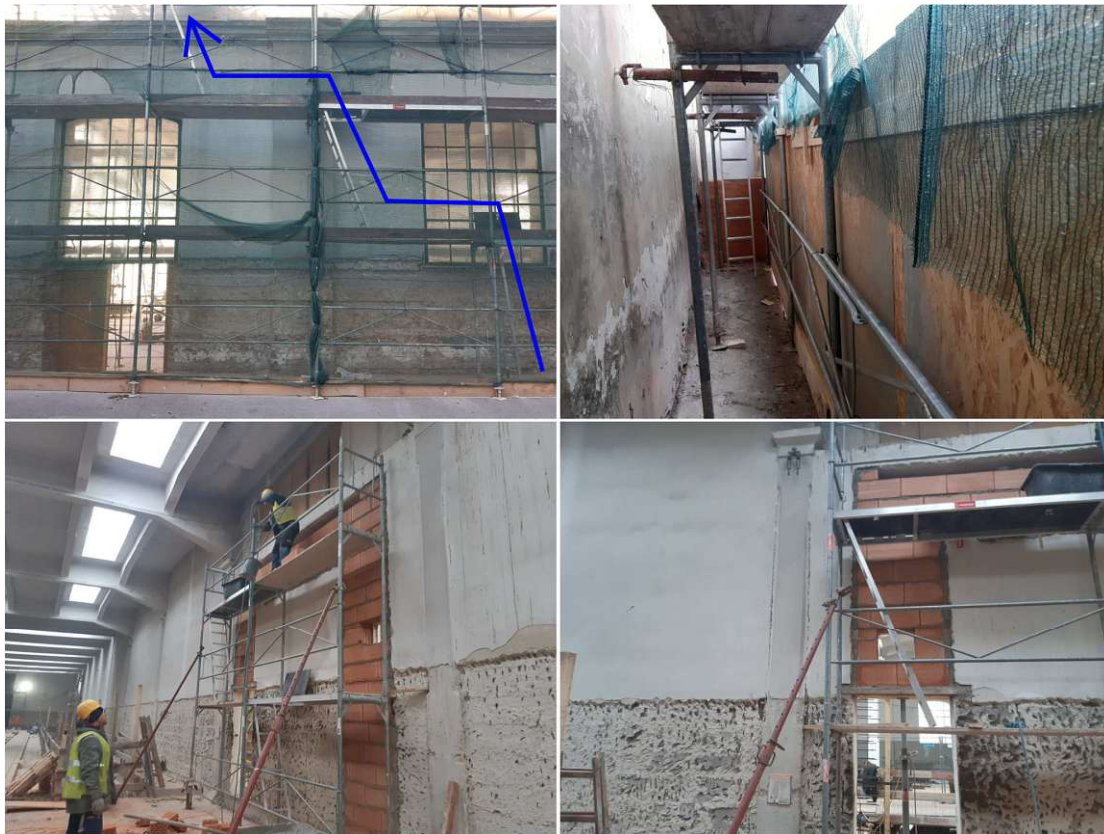
Abb 15: Leiteraufstiege in Systemgerüsten – einkalkulierte Leistung gemäß LB-HB Version 022 und Nebenleistung gemäß ÖNORM B 2252:2007
