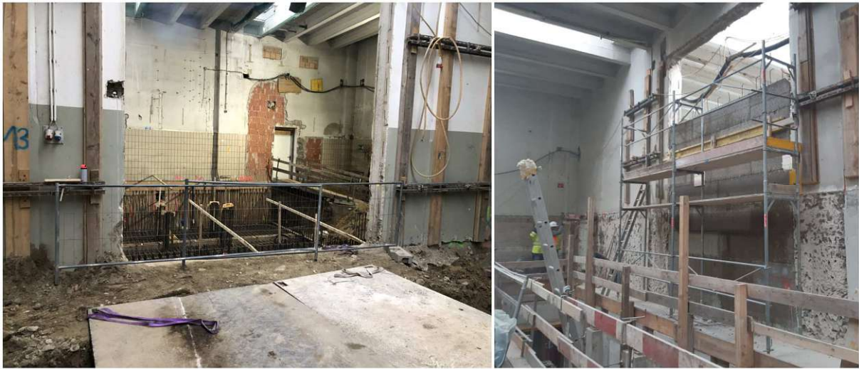
Abb 17: Herstellen und Verschließen von Transportöffnungen als Nebenleistung
