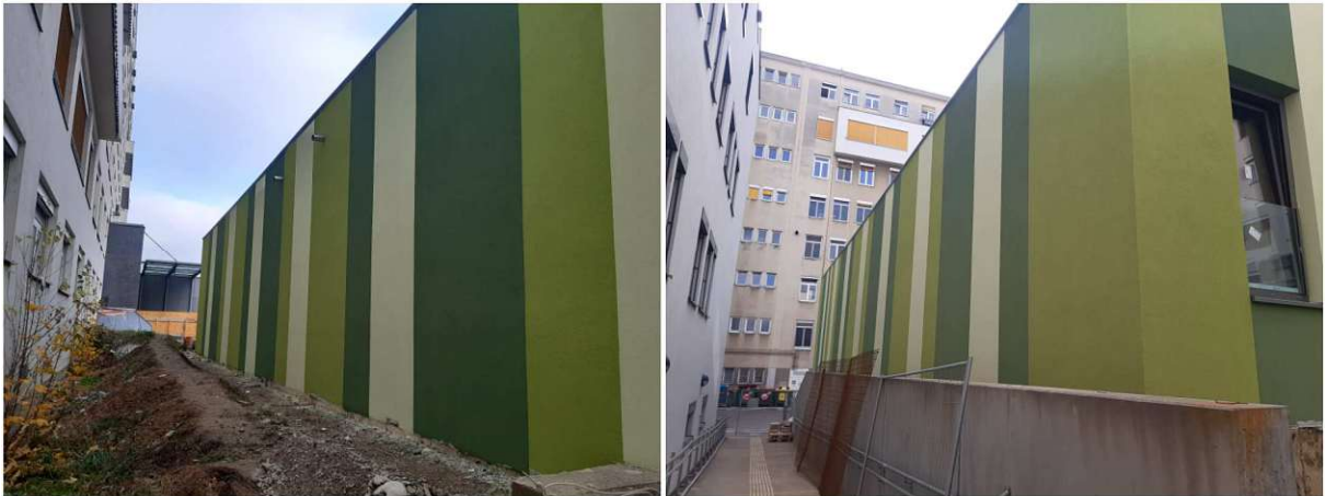
Abb 53: Erschwernisse durch unterschiedliche Färbungen innerhalb zusammenhängender Putzflächen
