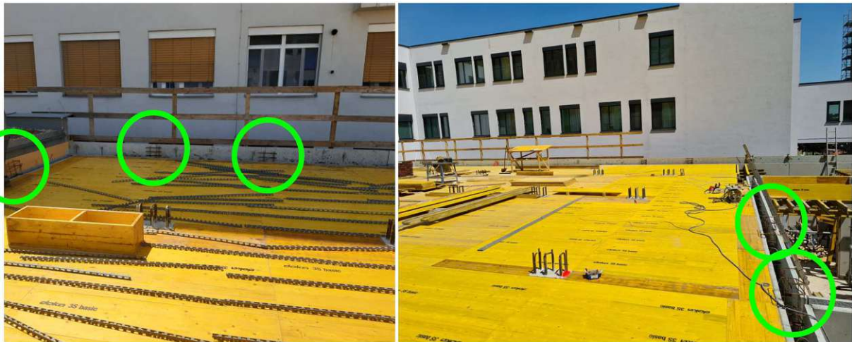
Abb 24: Bügelkörbe, hier grün markiert, werden eingesetzt um Hohlwände untereinander zu verbinden
