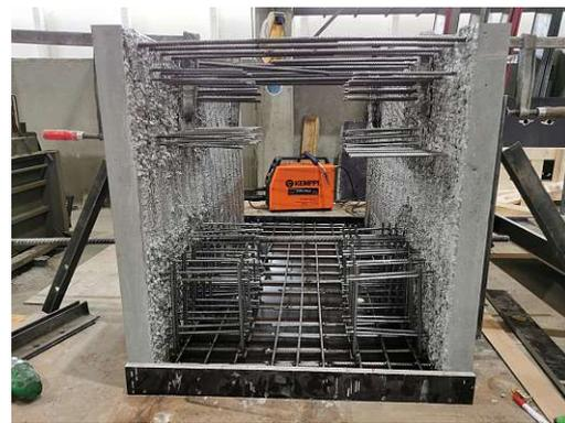
(b) Ortbetonlisene: Aufstellen der Stege und betonieren der Bodenplatte
