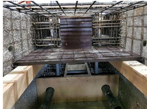
(b) Ortbetonlisenen: Betonieren der Lisenen
