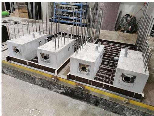
(a) Fertigteillisenen: Einstellen der Lisenen in die Schalung
