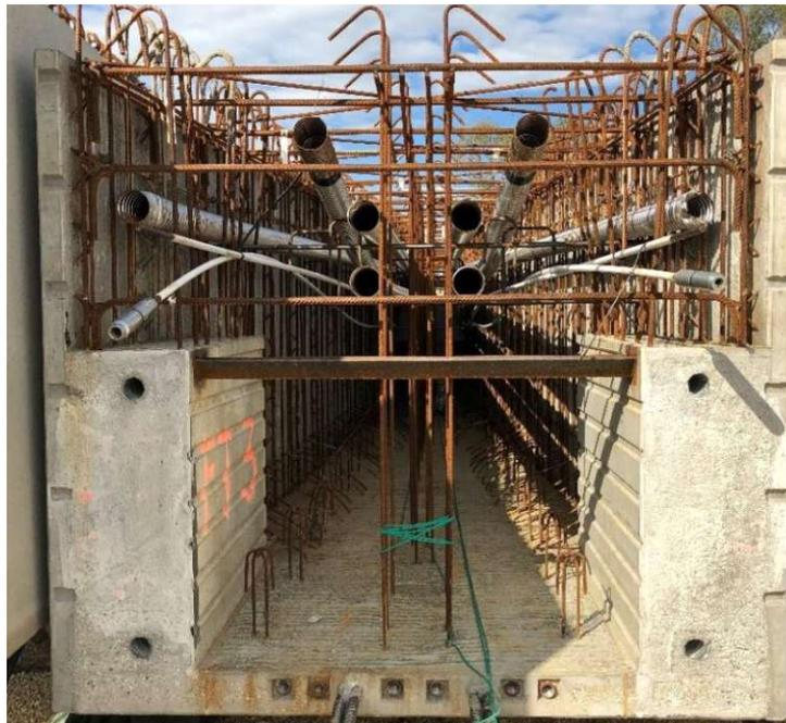
**Abb. 1.2:** U-förmiger Querschnitt eines Trägers, entnommen von [6], ©Forschungsbereich Betonbau TU Wien
