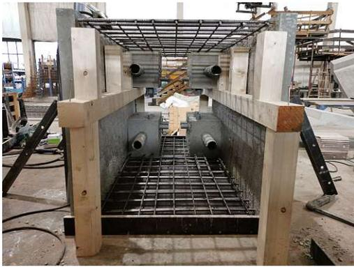
(a) Fertigteillisenen: Aufstellen der Stege und betonieren der Bodenplatte
