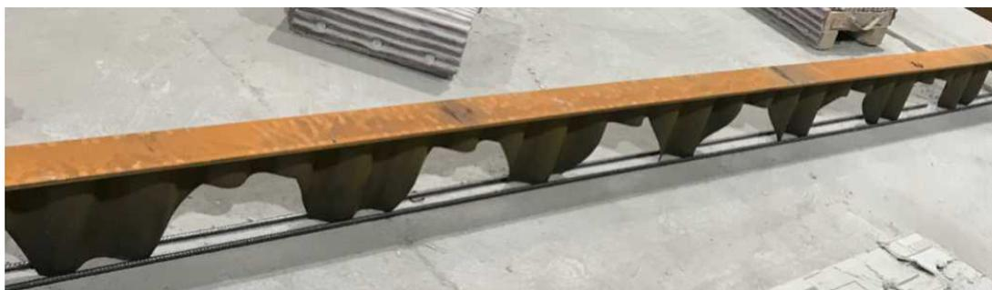
**Abb. 1.8:** Wellstegträger mit angeschweißter Bewehrung, entnommen aus [3] © G.S. Wittmann
