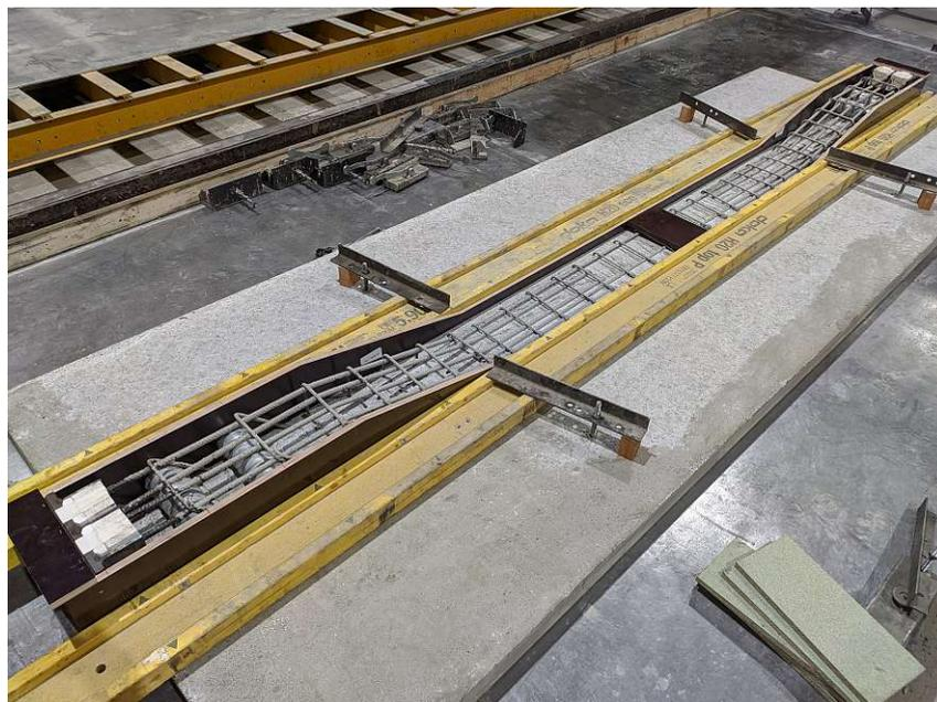
**Abb. 4.4:** Schalung der Rippe mit Aussparung Schraubverbindung und Hüllrohr
