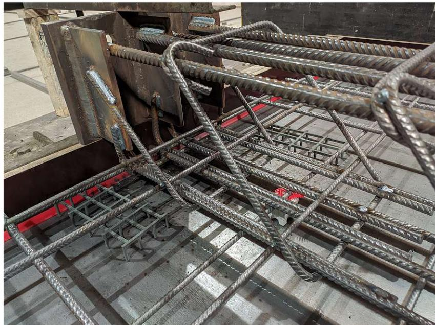
Abb. 4.2: Detailaufnahme zur Bewehrung an der Kopfplatte
