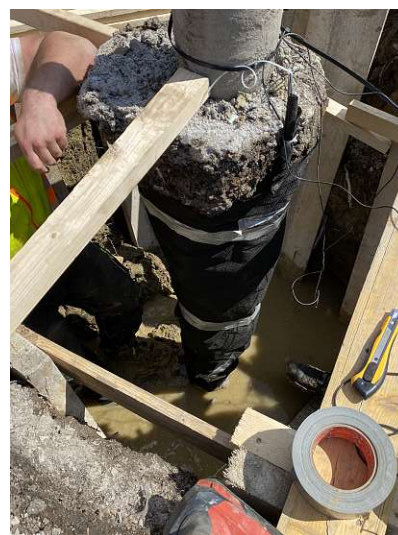
(c) Fertiger Pfahl mit Vlies umwickelt
