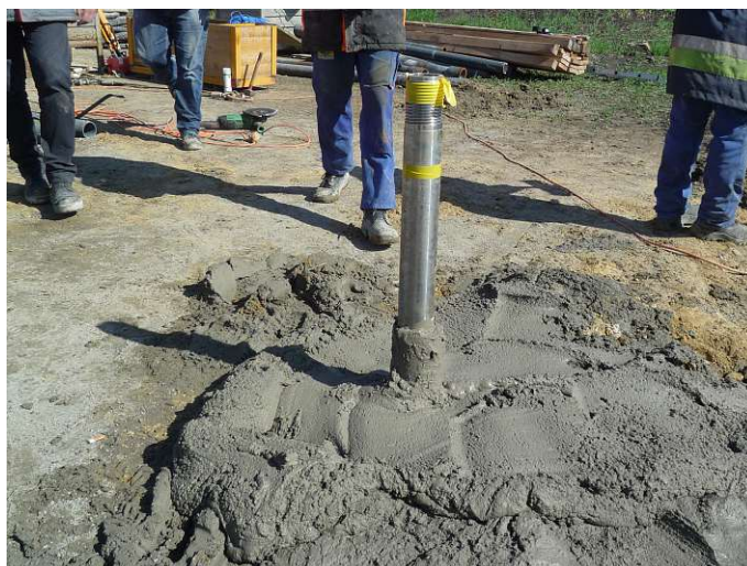
Abb. 4.21: Hergestellter Probepfahl mit eingebautem Zugrohr des Projektstandorts HA3 in Hagen (Foto: KELLER GRUNDBAU GES.MBH.)
