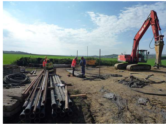
(b) Lagerung der duktilen Gusseisenrohre
