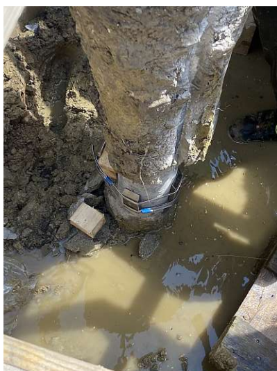
(a) Anbringen der Grundplatten mit zwei Schellen
