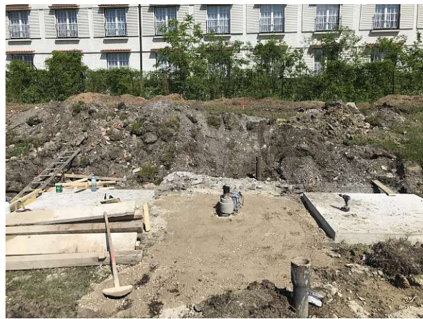
(b) Fertiggestelltes, verdichtetes Planum
