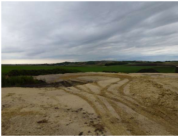
(a) Für den Pfahlprobeversuch vorbereitetes Baufeld
