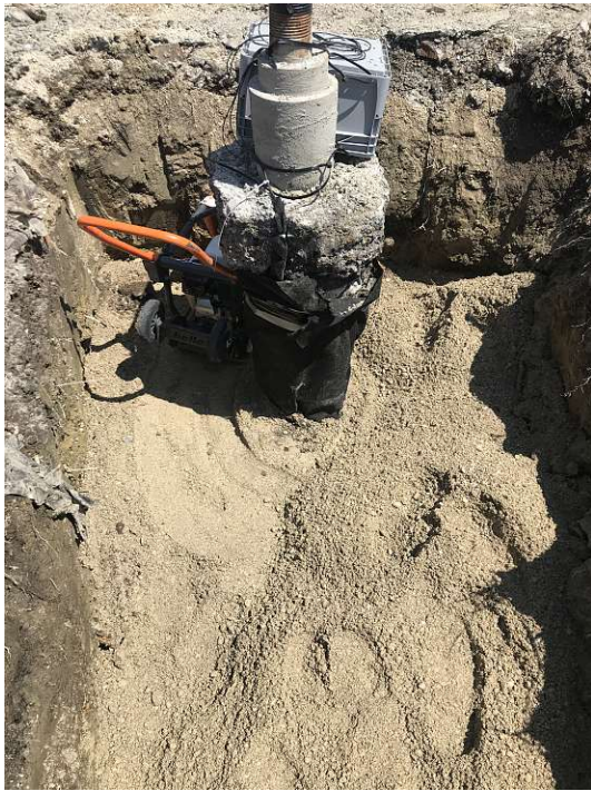
(a) Lageweises Verdichten des Sand-Kies-Gemisches (0/16)
