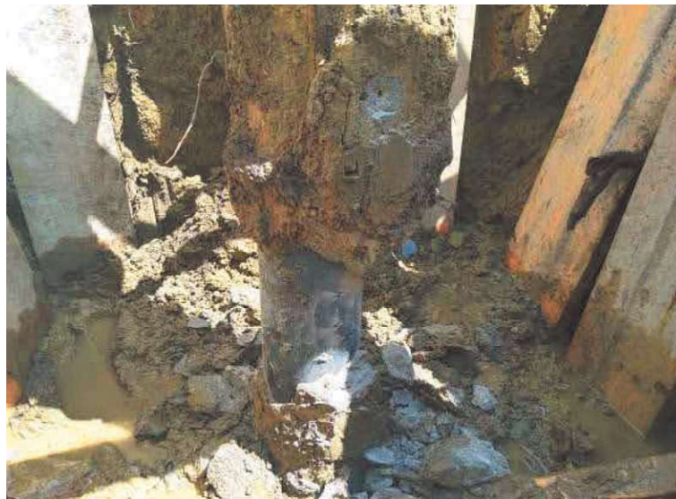
Abb. 4.44: Abstemmen des Verpressbetons des Prüfpfahles PP02 des Projektstandortes Brunn am Gebirge
