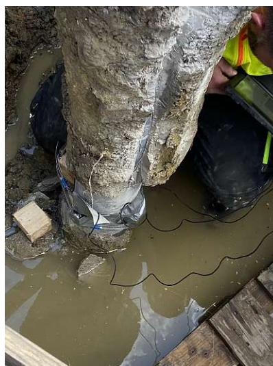
(b) Einbau der Kraftmessdosen an die Grundplatten
