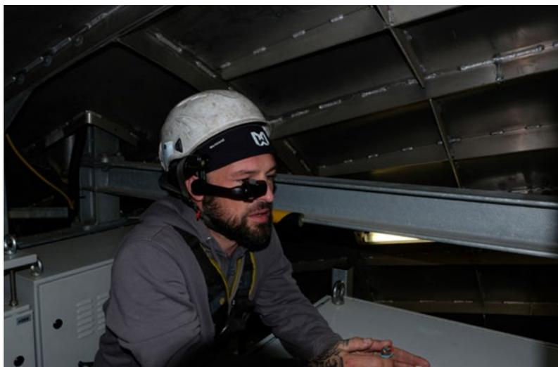
Abbildung 3: Inspektion einer Windturbine mit einer Datenbrille (Nagarro, 2020)
