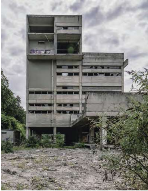
Abb.20: Loggienstrukturen an der Westfassaden
