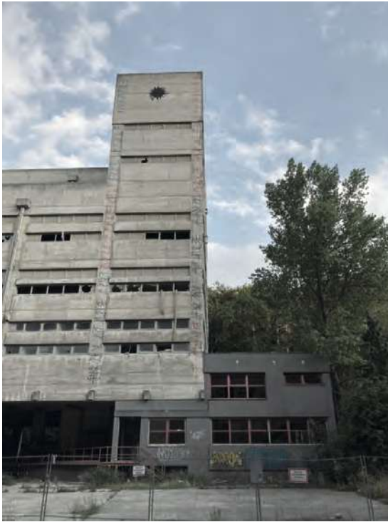
Versandbüro, Anbau aus den 70er Jahren
