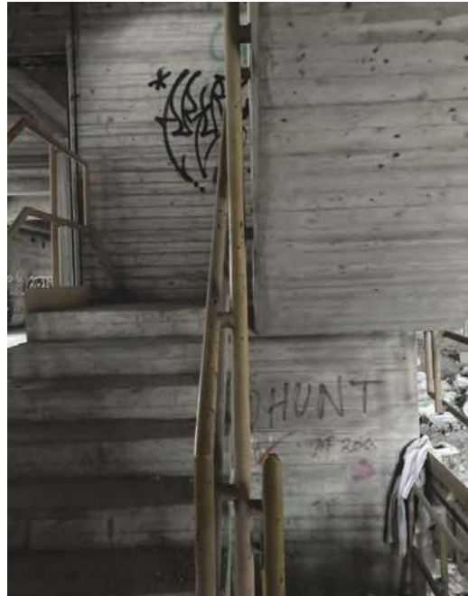
Filigrane Schalungsstruktur an der Treppenoberfläche
