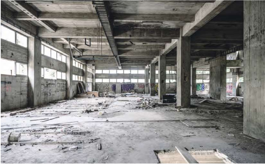
Abb.18: Hohes 1. OG mit Fensteröffnungen an allen Fassaden
