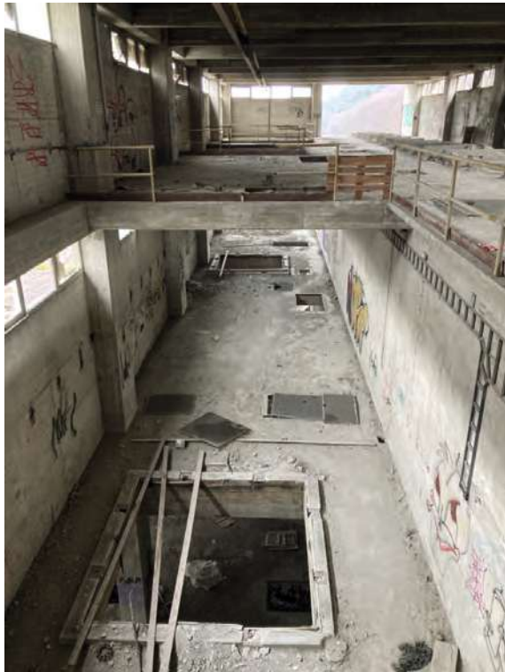
Deckenöffnungen und große Fassadenöffnung
