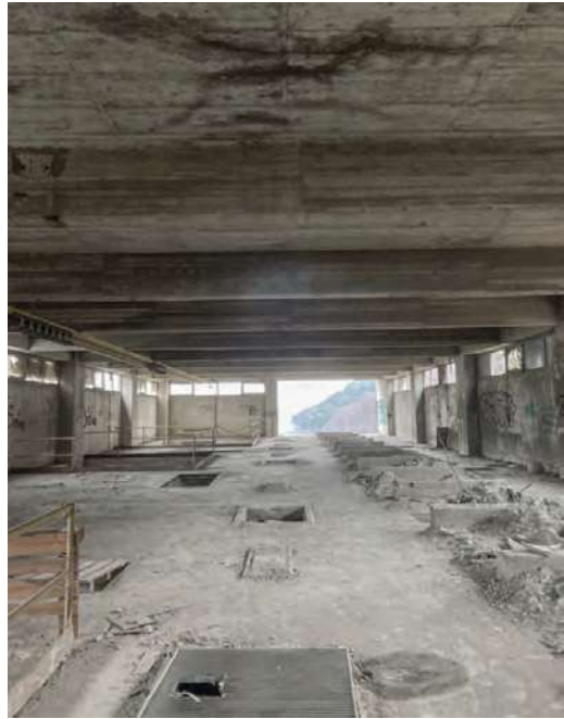
Fassadenöffnung und Siloöffnungen im 5.OG
