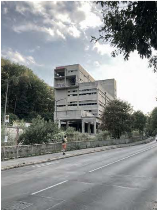
Ostfassade des Gebäudes
