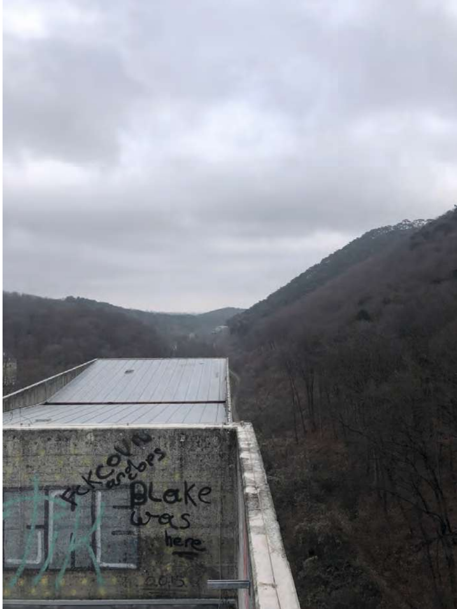
Faltdachkonstruktion mit hoher Stahlbetonattika
