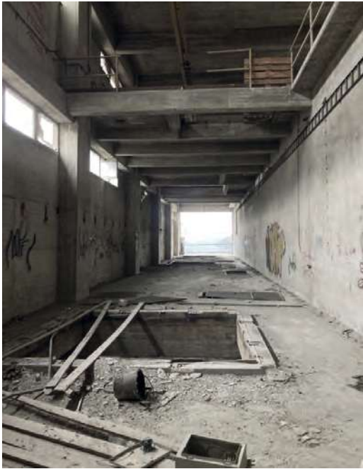
Fassaden - und Deckenöffnung im 4. OG
