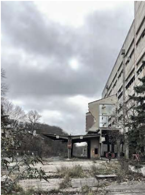
Lose Verladeanlage 1 zur Straße vorgesetzt
