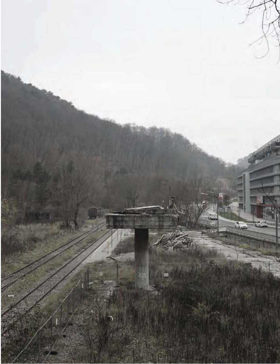
Die alte Stütze, auf der das Fließband zur Zementfabrik verlief
