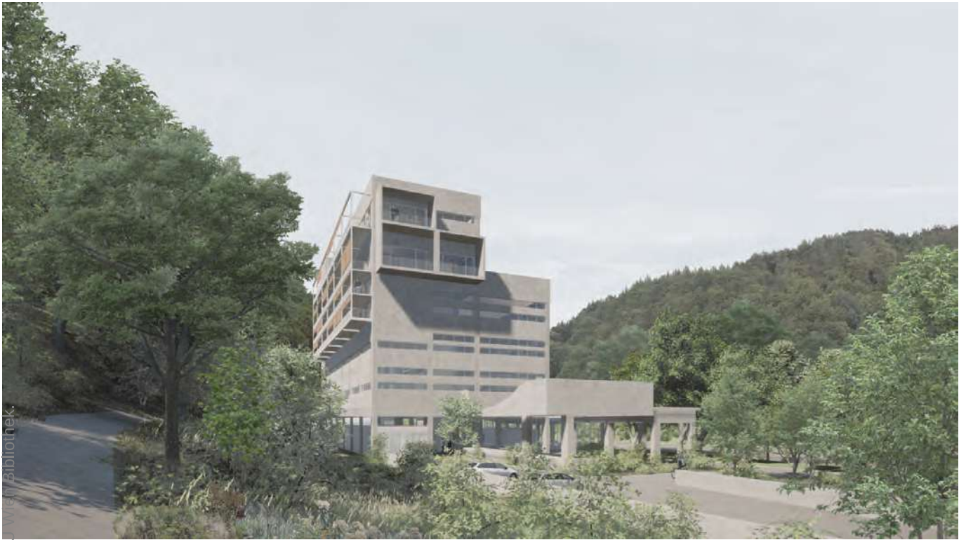
Blick auf die Ostfassade und die privaten Außenräume an der Südfassade
