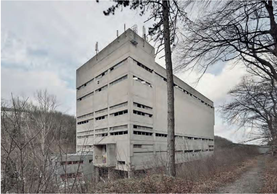
Abb.9: Südfassade mit großer, geschlossener Fläche. Versandbüro mit roten Fenstern
