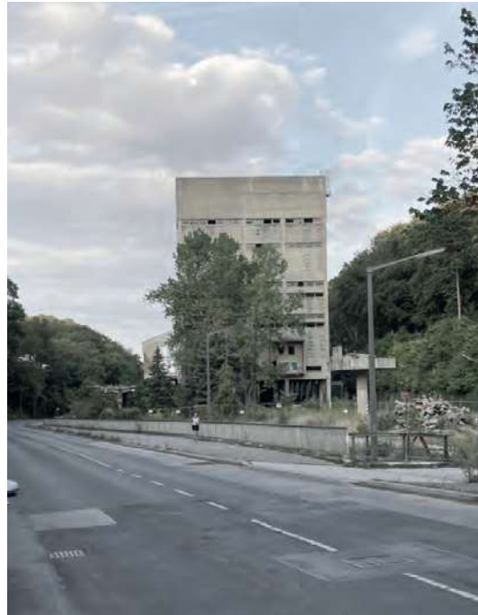
Westfassade des Gebäudes
