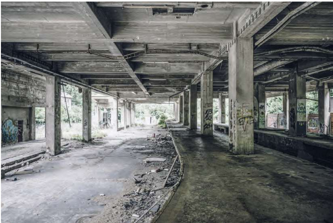
Abb.17: Aufgeständertes Erdgeschoss mit den beiden Bahnsteigen
