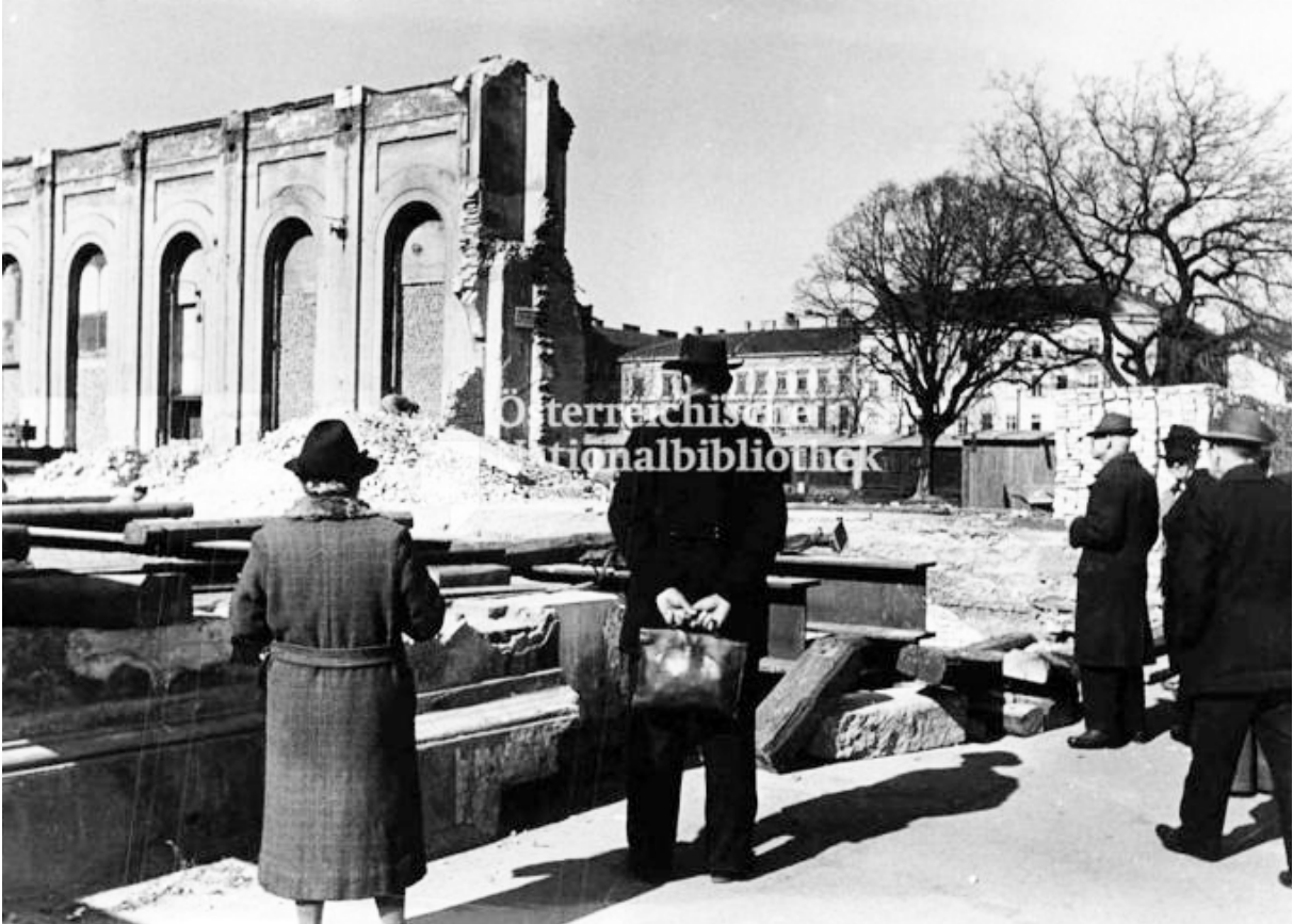
Abb. 6.: Zerstörter Westbahnhof, Mauerteile, Schutthaufen, einige Personen betrachten die Ruine, 01.01.1949
