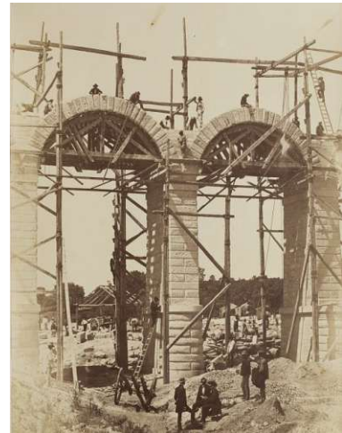
Abb. 8 Bauarbeiten am Aquädukt Valdealeas - Charles Clifford 1858
