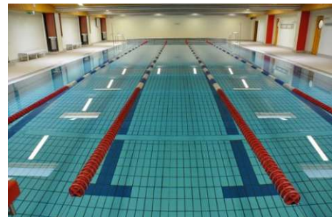
Abb. 124: Die bei der Generalsanierung an der Stelle des ehemaligen Kesselhauses erbaute Trainingshalle 2013
