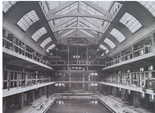
Abb. 38: Innenfoto der Schwimmhalle samt Stahlbetonbindern und seitlichen Zierlichtern während der Erbauung
