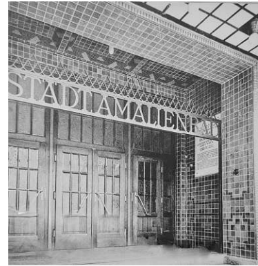
Abb. 56: ursprünglicher zurückgesetzter Eingang
