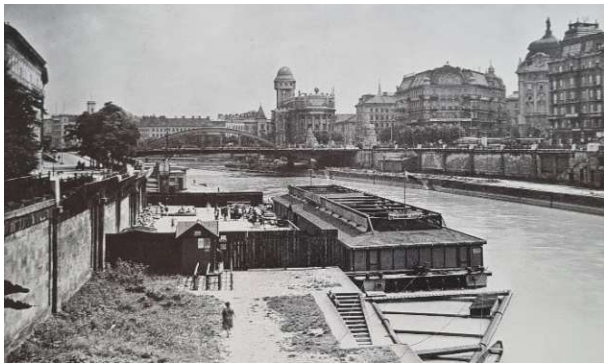
Abb. 9: Strombad Aspernbrücke im Donaukanal
