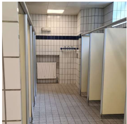
Abb. 159: Geländer und Treppenlift der Schwimmhallentribünen 2023 (oben), Reinigungsbad im Männerbereich 1926 (Mitte) und 2023 (unten)
