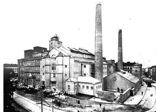
Abb. 33: Das Amalienbad 1926 kurz vor der Fertigstellung mit den sichtbaren Gleisen
