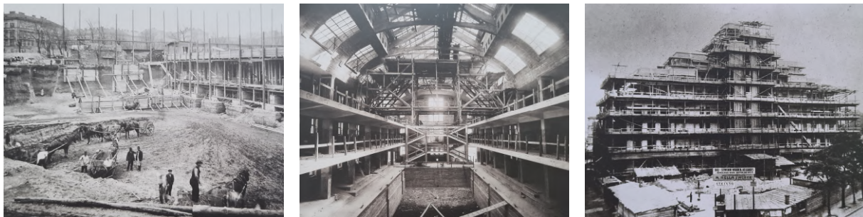
Abb. 34: Fotos der Baustelle anfangs (links), der Schwimmhalle (Mitte) und des Äußeren (rechts)
