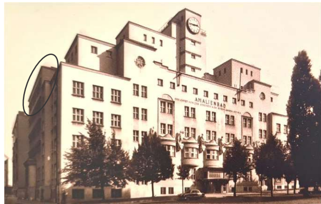
Abb. 44: Das Amalienbad nach dem Wiederaufbau mit reduzierterer Fassadengestaltung und erweiterter Kurabteilung im 4. Obergeschoss
