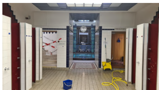
Abb. 142: Blick zum Warmbecken durch den Brauseraum 1926 (oben) und Abkühlraum 2023 (unten)
