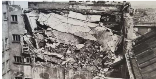
Abb. 41: Schäden durch Bombentreffer an der Hauptfassade
