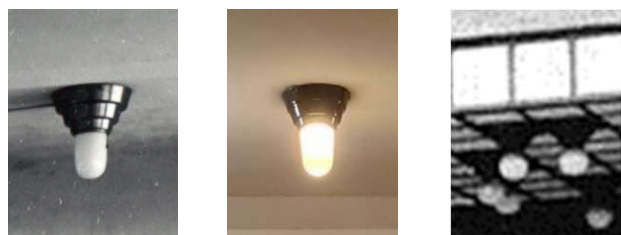
Abb. 174: Lampe im Inneren 1926 (links), 2023 (Mitte) und unter dem Vordach 1926 (rechts)
