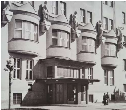
Abb. 43: Neues Eingangsportal aus dem Wiederaufbau
