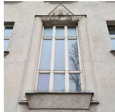
Abb. 62: Großes Fenster am rechten äußeren Kubus mit dem originalen Dekor 2023
