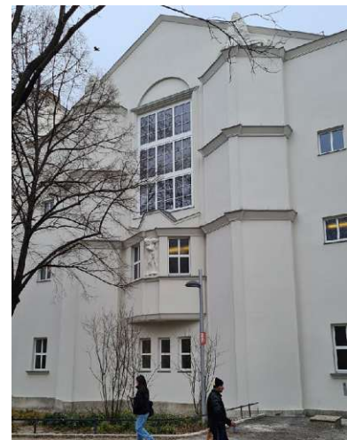
Abb. 69: Fassade der Schwimmhalle mit Relief am Erker 1926 (oben) und 2023 (unten)
