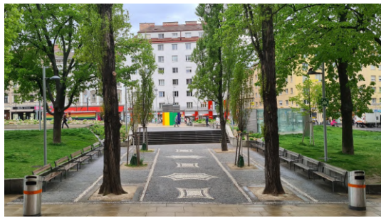
Abb. 48: Foto vom Vorplatz 2023 mit der ursprünglichen Pflasterung (Blick vom Eingang des Amalienbades Richtung Reumannplatz)
