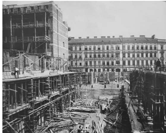
Abb. 36: Während der Erbauung sichtbares Ziegelmauerwerk und Stahlbetondecken
