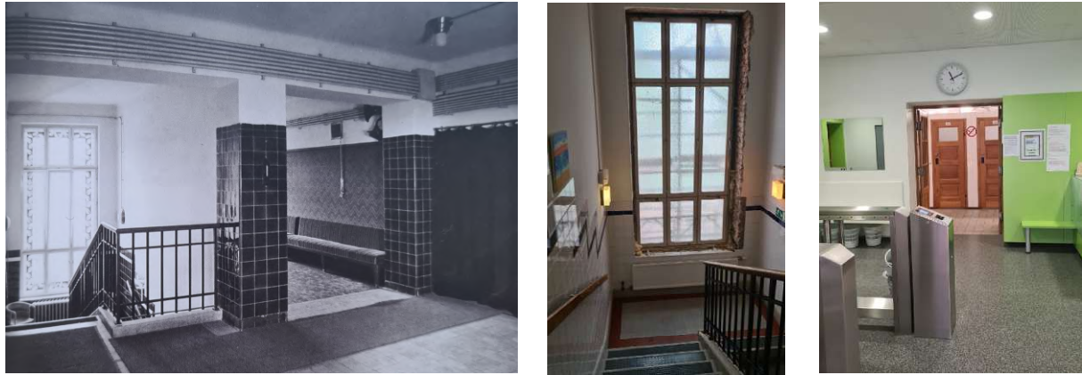
Abb. 86: Stiege zum Dampfbad im Erdgeschoss und Warteraum 1926 (links), das Fenster der Stiege während der Fassadensanierung 2023 (Mitte) und Zugang zum Umkleideraum 2023 (rechts)
