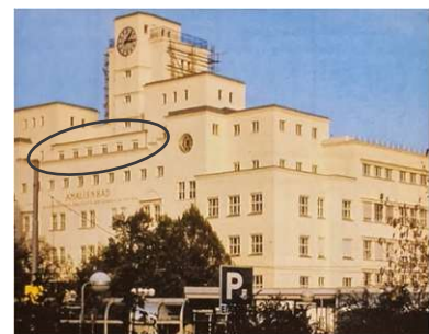
Abb. 63: Das Amalienbad nach der Generalsanierung 1980-1986 mit der Aufstockung und sichtbaren Jalousien
