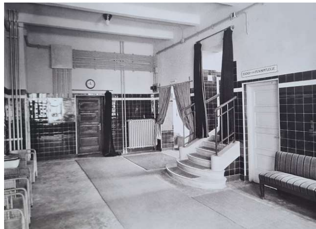
Abb. 175: Vorreinigung im Männerbereich 1926 mit sichtbaren Leitungen und Türen zu Hand- und Fußpflege auf der rechten und zum Hauptstiegenhaus auf der linken Seite
