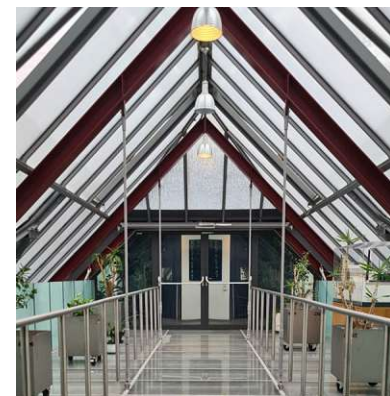
Abb. 90: Verbindungsgang zwischen Stiege 3 und Restaurant 2023
