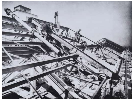
Abb. 39: Baustellenfoto der Stahlkonstruktion des Schwimmhallendaches
