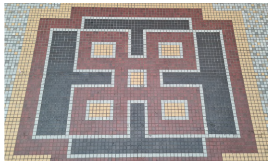
Abb. 183: Altersspuren in Form von Abnutzung der Kanten und leichtem Farbverlust am Bodenmosaik in der Eingangshalle 2023
