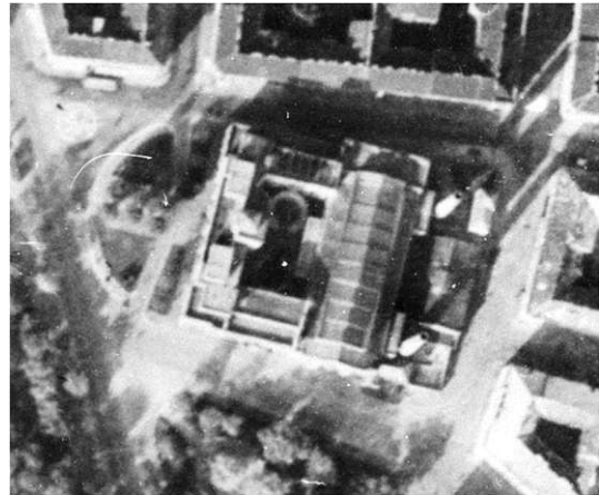
Abb. 46: Luftaufnahme des Amalienbades mit dem ursprünglichen Vorplatz 1938
