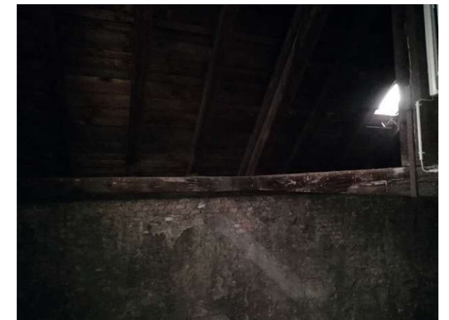
Abb. 143: Dachstuhl mit sicht auf Dachfläche mit Dachfenster eigene Aufnahme 22.12.2022
