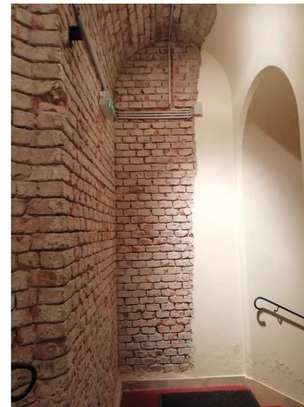
Abb. 77: Zwischenpodest mit Tonnengewölbe eigene Aufnahme 31.03.2022
