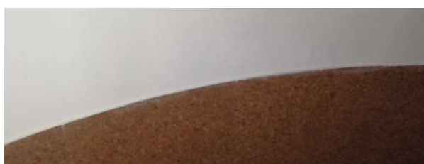
Abb. 147: Übergang der Wand von Linoleum zu Putz eigene Aufnahme 22.12.2022
