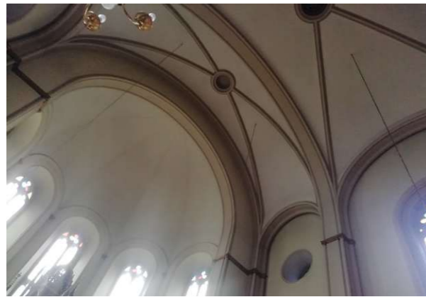
Abb. 112: Halbkuppel der Apsis, Übergang zum Kreuzrippengewölbe (schmales und breites Joch) eigene Aufnahme 31.03.2022
