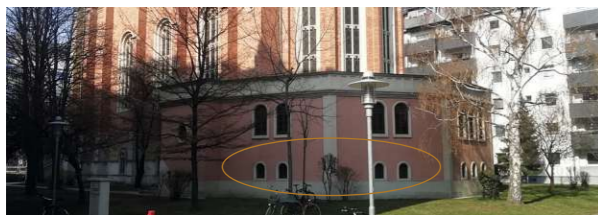
Abb. 88: Außenansicht mit markierten zugehörigen Fenstern eigene Aufnahme 19.03.2022
