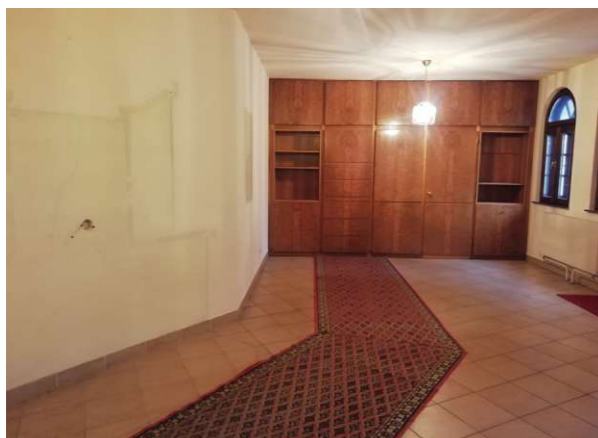
Abb. 135: teilweise leer geräumter Raum, beleuchtet eigene Aufnahme 02.12.2022
