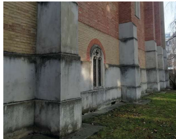
Abb. 199: Materialität des Sockelbereichs eigene Aufnahme 19.03.2022
