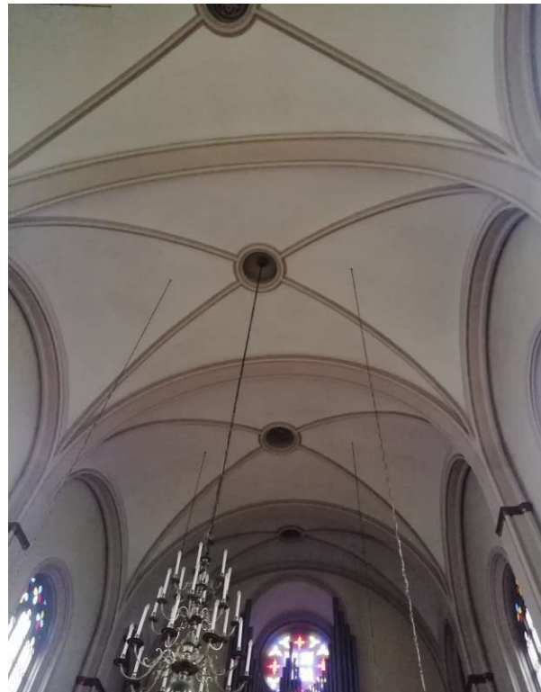
Abb. 113: Kreuzrippengewölbe, Sicht Richtung Eingangportal eigene Aufnahme 31.03.2022
