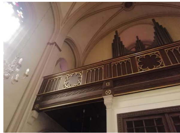
Abb. 115: Empore mit Holzgeländer, darunter der Windfang eigene Aufnahme 31.03.2022
