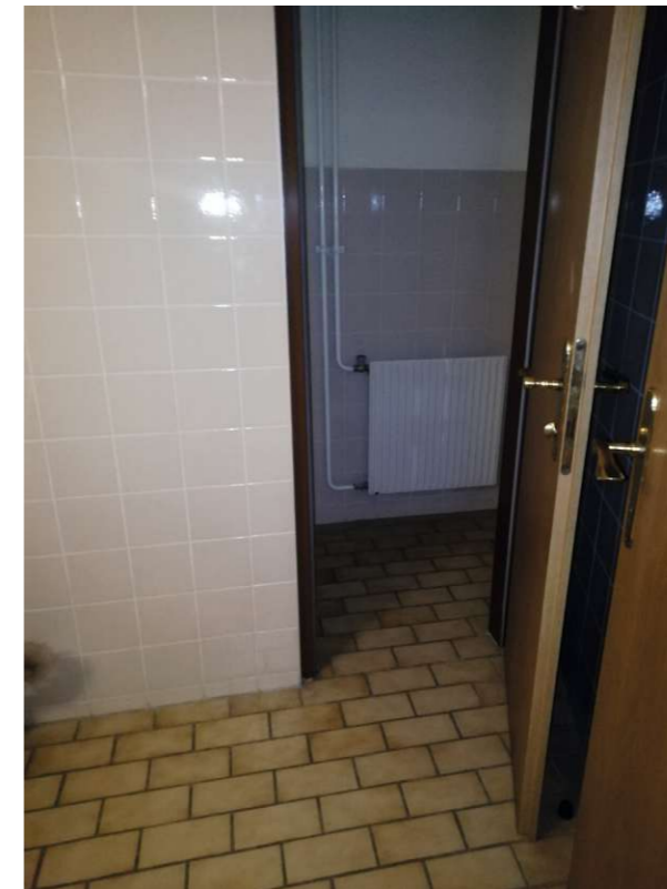
Abb. 96: Vorraum mit Sicht in die WC-Kabine eigene Aufnahme 22.12.2022
