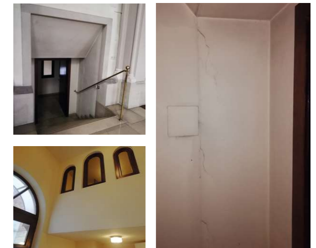
Abb. 119: oben: Abgang vom Altarraum zu Sakristeitreppe eigene Aufnahme 22.12.2022
