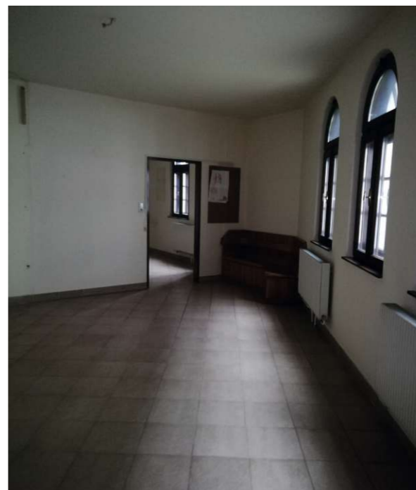
Abb. 131: leer geräumter Raum mit Sicht zu Raum 15 eigene Aufnahme 22.12.2022
