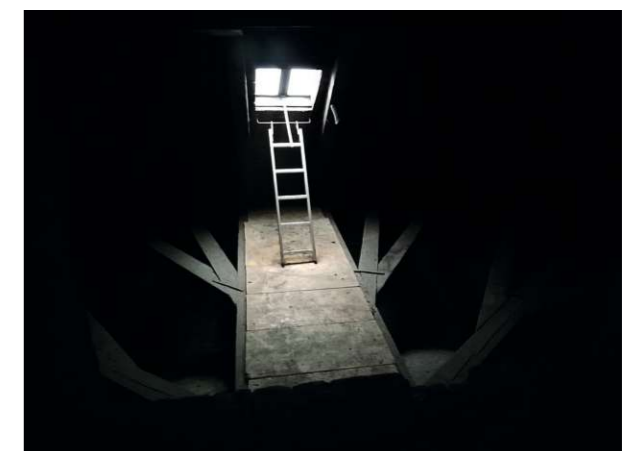
Abb. 145: Dachstuhl und Halbkuppel über Apsis eigene Aufnahme 22.12.2022
