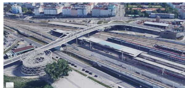
Abb. 58: Übergang Südbahnhofbrücke Google Maps Kartendaten 2022
