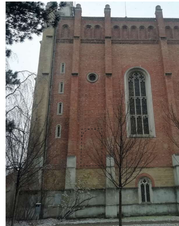
Abb. 200: Position des Durchbruchs und Oberfläche für eine eventuelle Rückbaubarkeit eigene Aufnahme 02.12.2022 (gespiegeltes Bild der Nord-Ost-Fassade)
