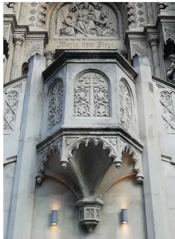
Abb. 221: Kanzel zwischen Freitreppen vor dem Eingang eigene Aufnahme 29.06.2022
