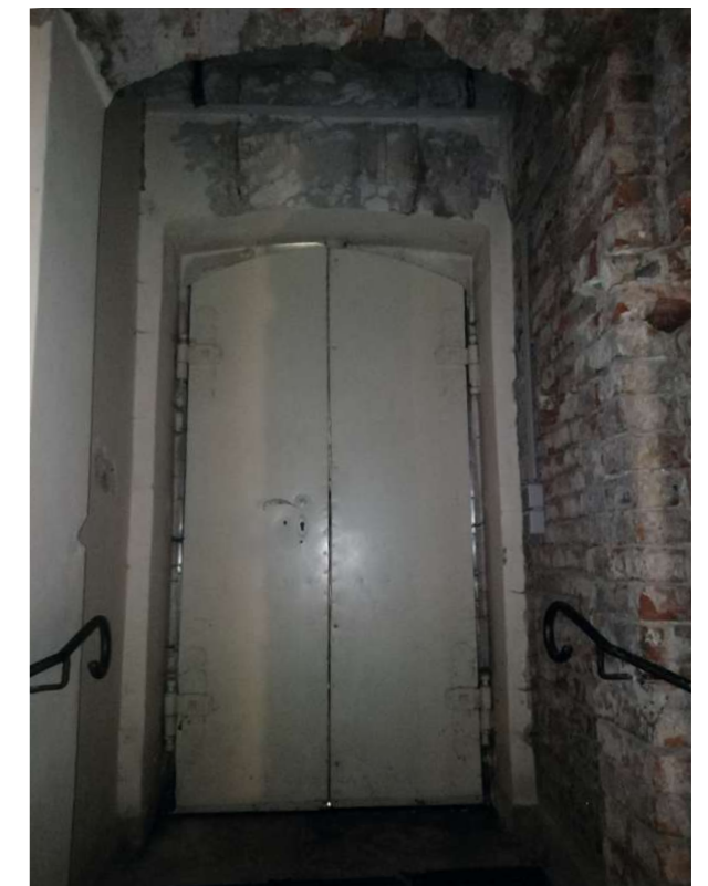
Abb. 79: Außentür von innen eigene Aufnahme 22.12.2022
