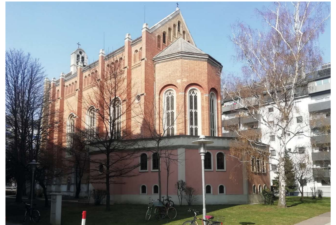
Abb. 214: Außensicht von Altar- bzw. Sakristeiseite eigene Aufnahme 19.03.2022, entzerrt
