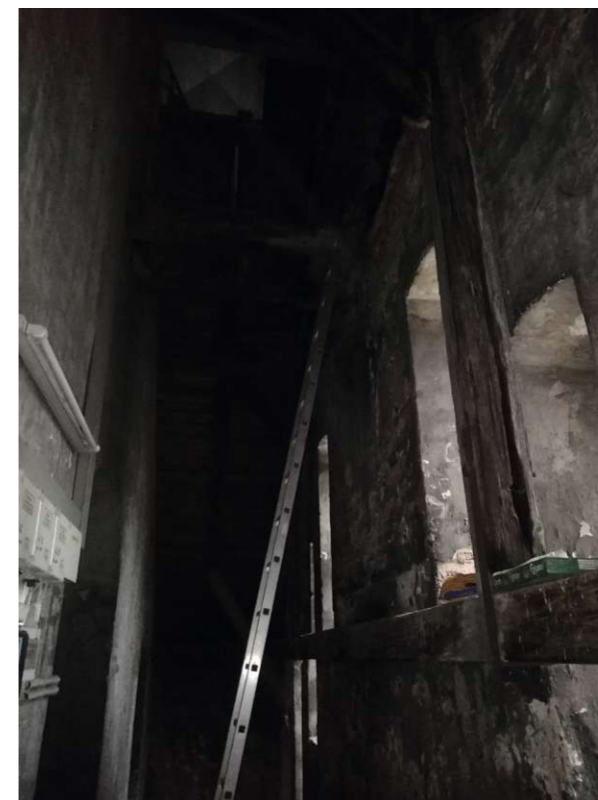
Abb. 142: Bereich über Eingangsportal mit ebenem Boden, hier mündet die Treppe eigene Aufnahme 02.12.2022
