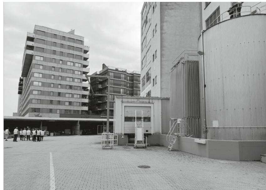
Abb.27: Henkelzentrale mit Blick auf benachbartes Wohnquartier
