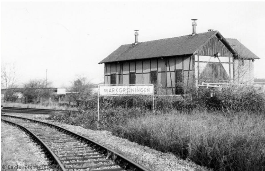
Abb. 28 Gütergleis des C&A-Verteilzentrums 1998
