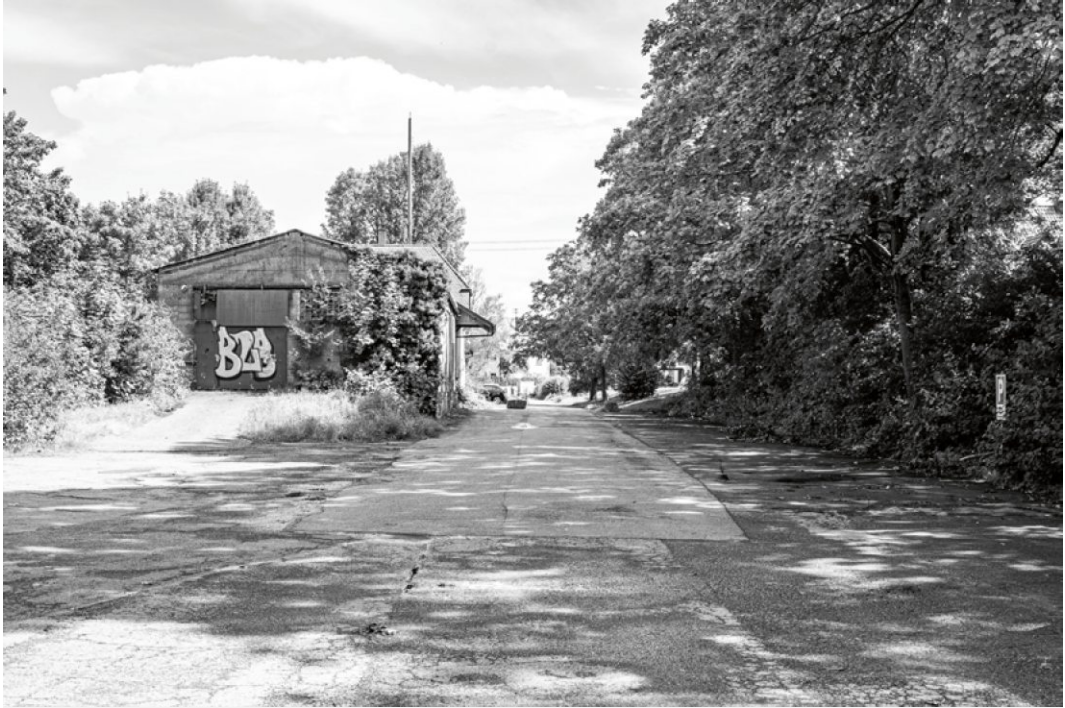
Abb. 71 Lager neben Bahnhofsgebäude; hintere Ansicht Lagerhalle und bewachsene Böschung auf der rechten Seite
