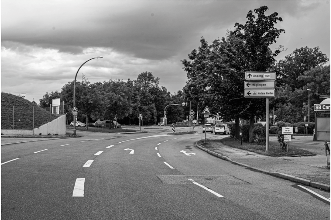
Abb. 48 Waldäckerstraße Richtung Kreuzung; Mörikestraße
