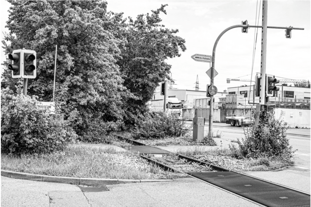
Abb. 50 stillgelegtes und bewachsenes Gleis
