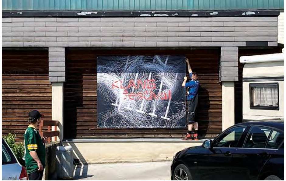
A.200 Wenn keine Öffnungen vorhanden sind, muss anders auf das Geschehen im Inneren des Gebäudes hingewiesen werden (hier: Banner für das Klangfestival 2023)
