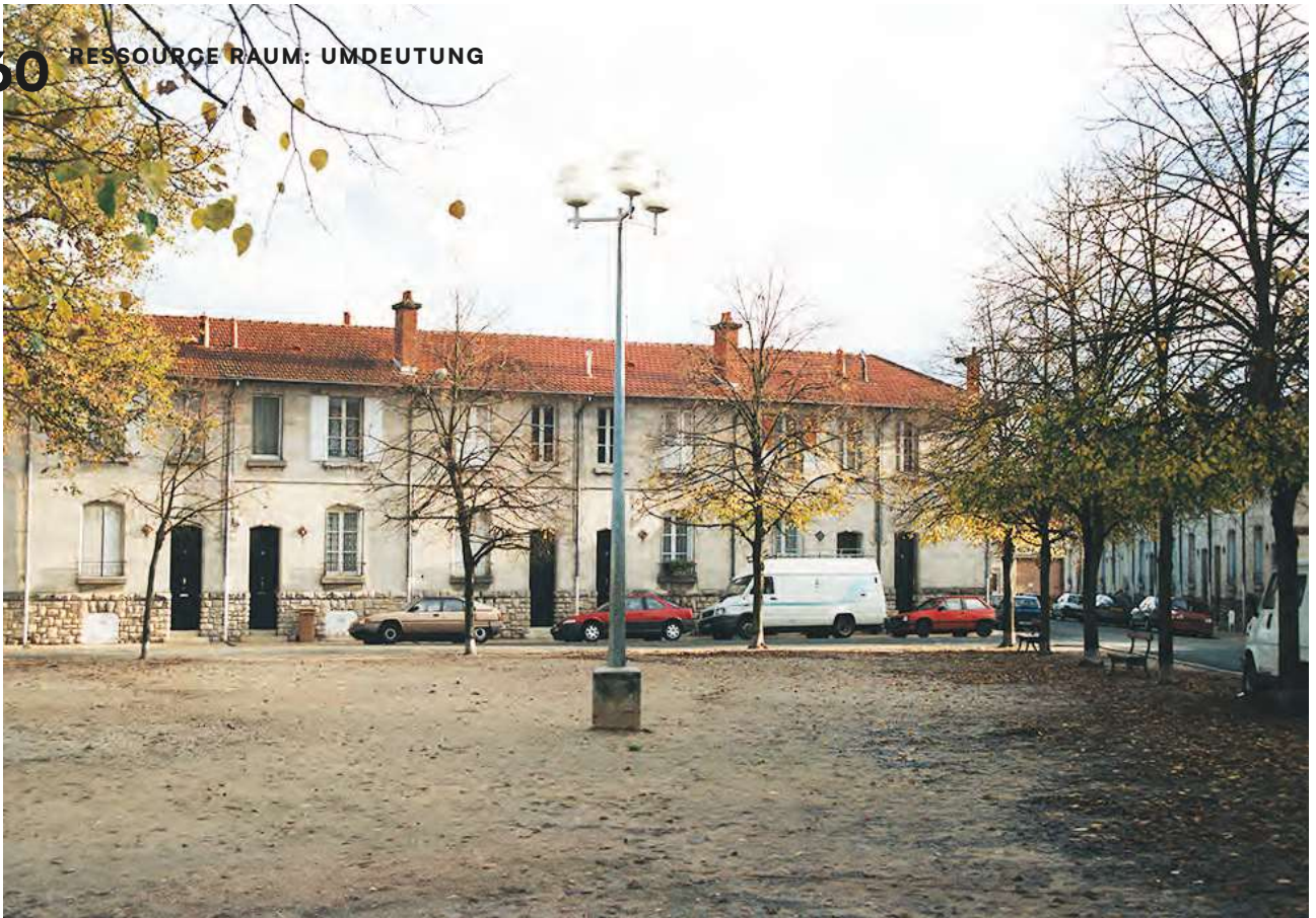
A.39 Aus Sicht der Architekt:innen Lacaton & Vassal bedurfte es beim Place Léon Aucoc keiner architektonischen Eingriffe, sondern Pflege und Instandhaltung (lacatonvassal.com)
