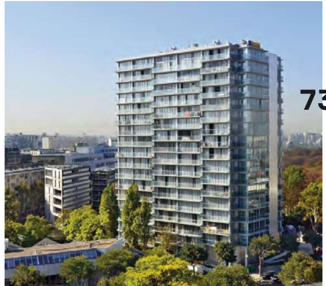
A.47 Der Tour Bois le Prêtre nach dem Eingriff von Lacaton & Vassal und Frédéric Druot, 2012 (Ruault)
