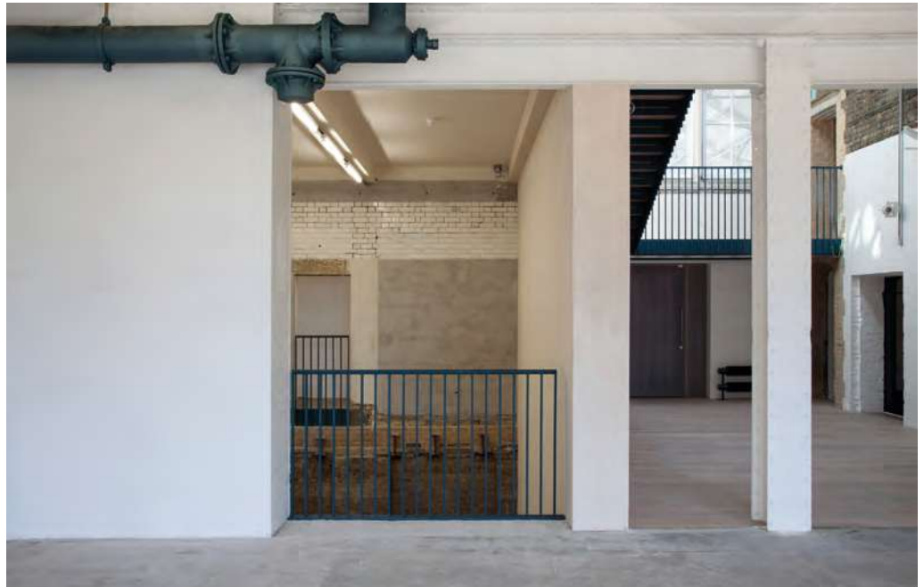
A.53 Goldsmiths CCA: Kontrast von erhaltener und freigelegter Bestandsstruktur und neu eingesetzten Elementen (assemblestudio.co.uk)
