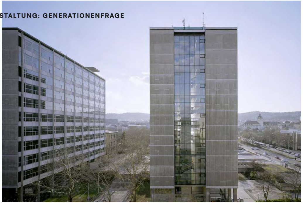
A.57 Kollegengebäude I und II: Generalsaniert, aber optisch nicht verändert (Hild und González)
