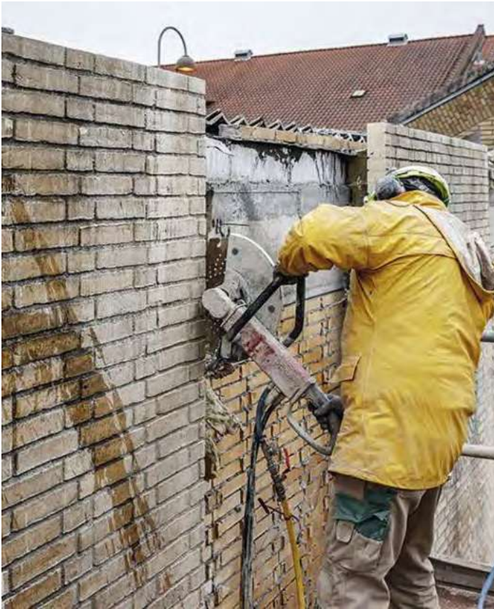
A.33 Bauteilernte ganzer Wandsegmente (Ransome, „Architektur des Wandels“, 168)
