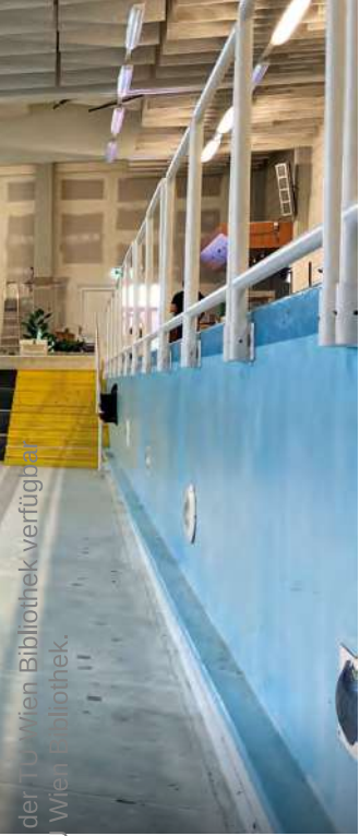
A.179 Geländer an den Beckenrändern als Absturz­sicherung (Juni 2023)
