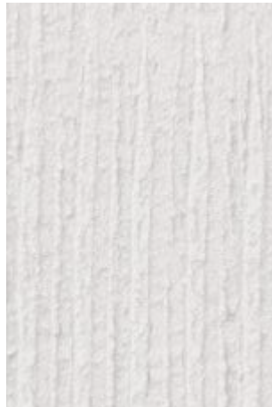
Fassadenputz EG hellgrau, Besenstrich
