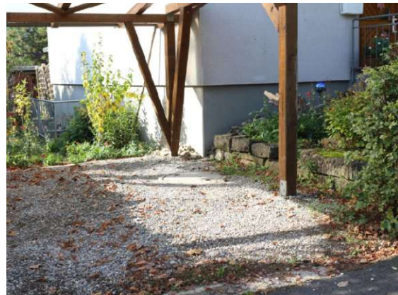
Abbildung 21: Wassergebundene Decke (Kiesbelag) (Stadt Hanau o. J., S. 9)
