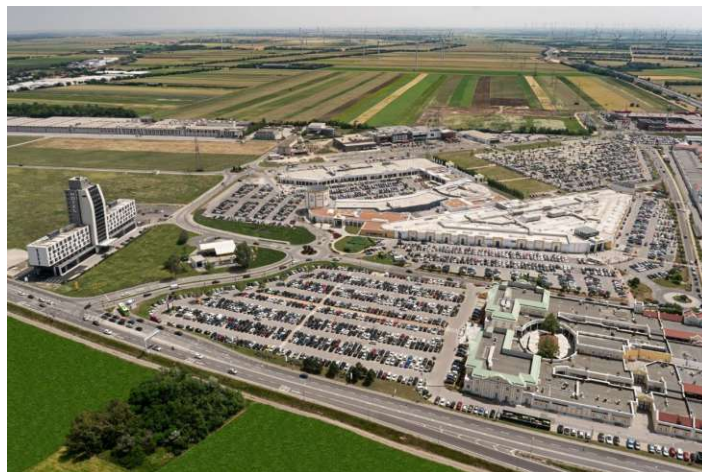
Abbildung 5: Großflächige Bodenversiegelung beim Designer-Outlet in Parndorf (Businessparks Burgenland o. J.)
