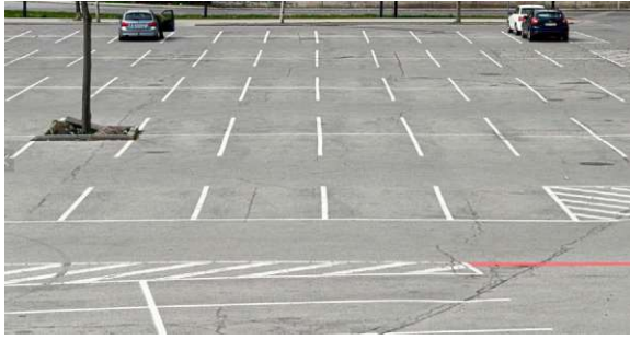
Abbildung 1: Asphaltierter Parkplatz (APA/Helmut Fohringer in Koch 2022)
