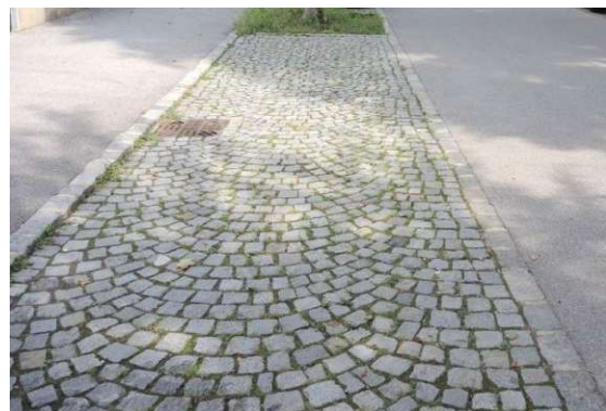
Abbildung 23: Natursteinpflaster (Gerlinde Koller-Steininger in Natur i. G. S. GmbH, S. 41)
