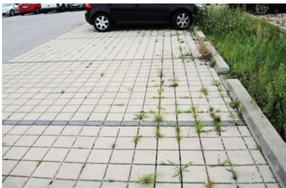
Abbildung 22: Pflastersteine mit aufgeweiteten/breiten Fugen (Gerlinde Koller-Steininger in Natur i. G. S. GmbH, S. 40)
