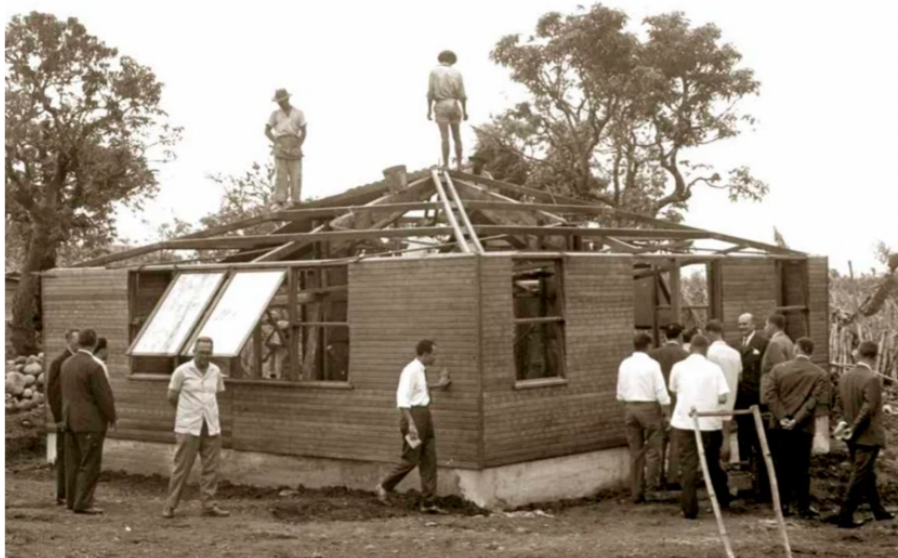
Abbildung 46: ebd. Baustelle einer Case Tomi
