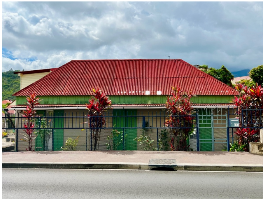
Abbildung 30: Bois sous tôle in Entre-deux
