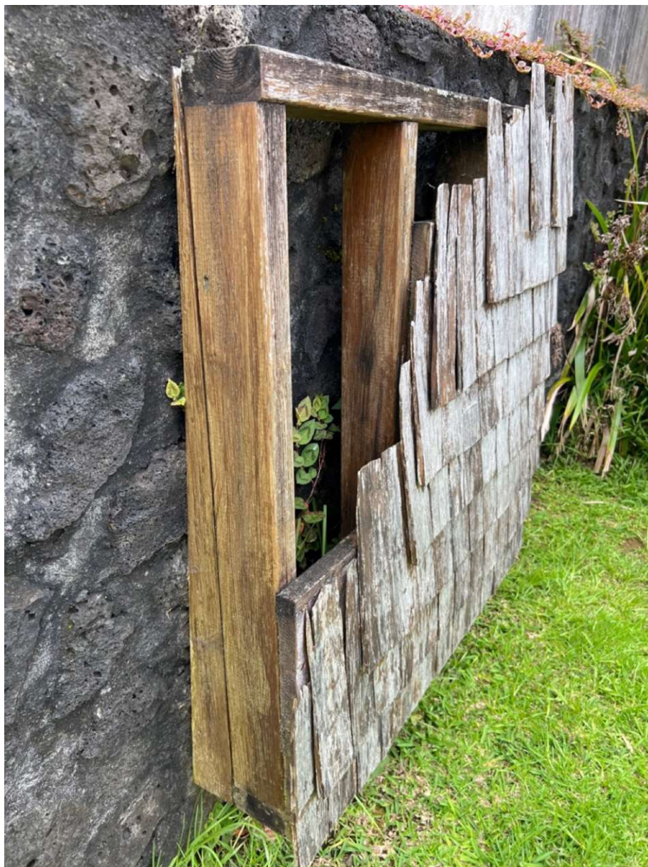
Abbildung 57: Unterkonstruktion von Holzschindeln auf La Réunion
