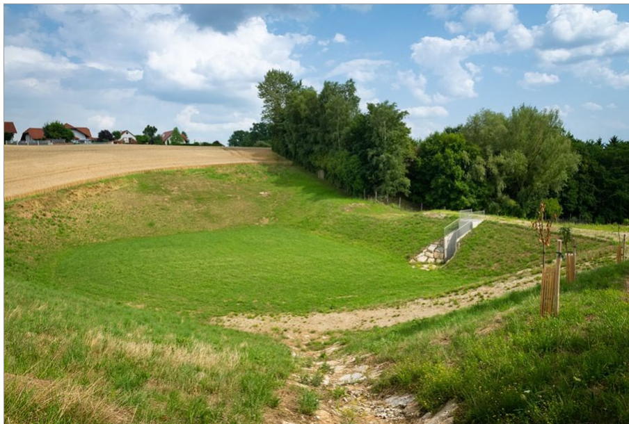
Abbildung 26: Rückhaltebecken zum Schutz vor Überschwemmungen durch Hangwasser in der Gemeinde Schwertberg (OÖ). (Quelle: Nadace Partnerství o. J.: o. S.)
