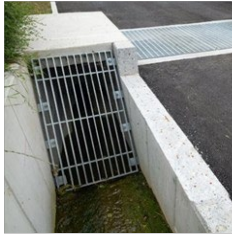
Abbildung 28: Ableitungskanal zum Schutz vor Überschwemmungen durch Hangwasser in der Gemeinde Schwertberg (OÖ). (Quelle: Nadace Partnerství o. J.: o. S.)
