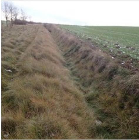
Abbildung 27: Graben zur Ableitung von Hangwasser. (Quelle: INFRASTRUKTUR & UMWELT o. J. a: o. S.)
