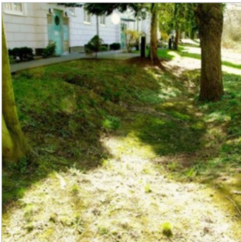
Abbildung 31: Versickerungsmulde. (Quelle: INFRASTRUKTUR & UMWELT o. J. a: o. S.)
