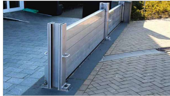
Abbildung 34: Mauern zum Hochwasserschutz. (Quelle: Adobe Stock)
