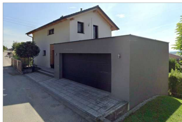
Abbildung 30: Garageneinfahrt über Straßenniveau. (Quelle: Google Maps)
