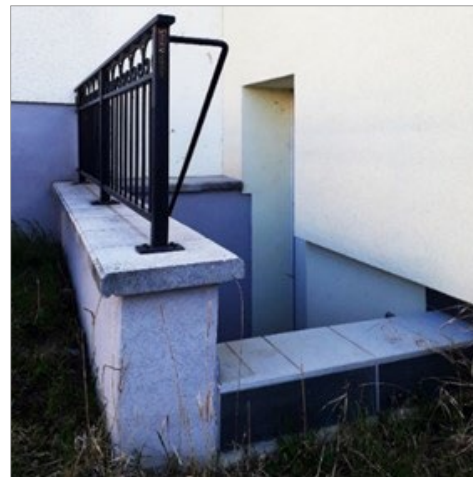
Abbildung 37: Erhöhter Kellereingang. (Quelle: INFRASTRUKTUR & UMWELT o. J. a: o. S.)
