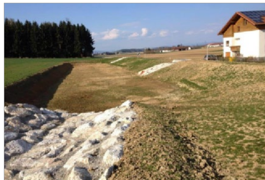
Abbildung 49: Rückhalte-Versickerungsbecken. (Quelle: Land OÖ)
