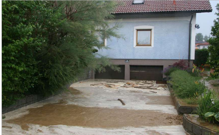
Abbildung 8: Wassereintritt in eine Garage. (Quelle: FF Schwertberg)
