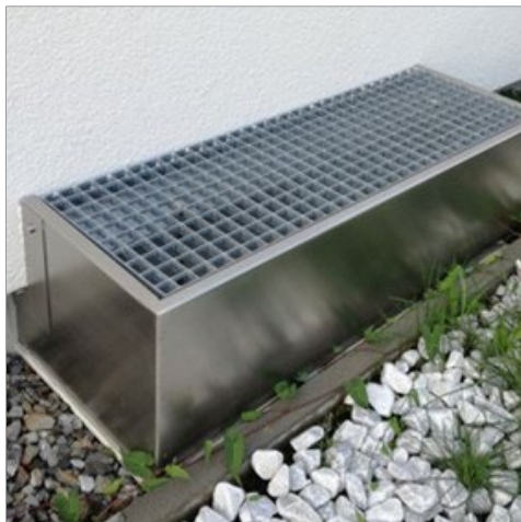
Abbildung 36: Aufgekanteter Lichtschacht. (Quelle: INFRASTRUKTUR & UMWELT o. J. a: o. S.)
