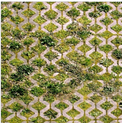
Abbildung 24: Versickerungsfähige Verkehrsfläche (Rosengittersteine). (Quelle: INFRASTRUKTUR & UMWELT o. J. a: o. S.)
