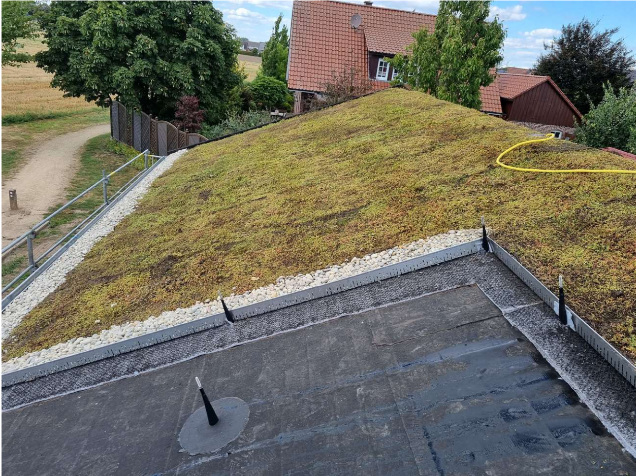
Abb.103: Beispiel einer Moosbegrünung eines geeigneten Daches
