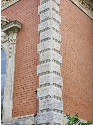
Abbildung 89: Villa Münz, Fassadendetail, Material, 1911 Copyright: Ines Marjanovic, 2023
