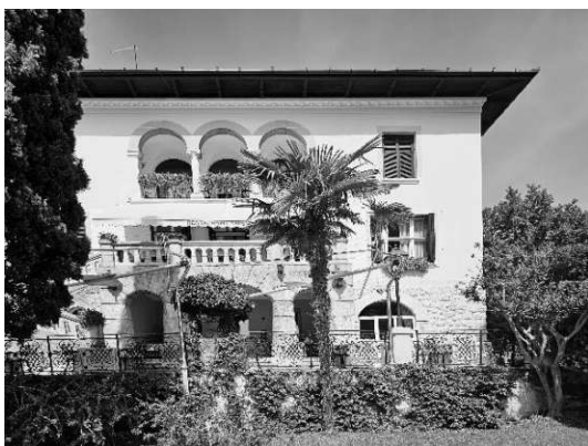
Abbildung 81: Villa Arston, Meeresfassade Copyright: Ines Marjanovic, 2023
