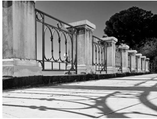
Abbildung 98: Pavillon Šporer, Terrassen Geländer Copyright: Ines Marjanovic, 2023
