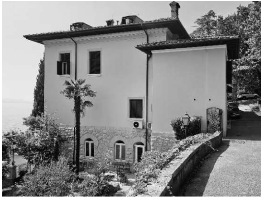
Abbildung 73: Villa Ariston, Putzfassade Copyright: Ines Marjanovic, 2023
