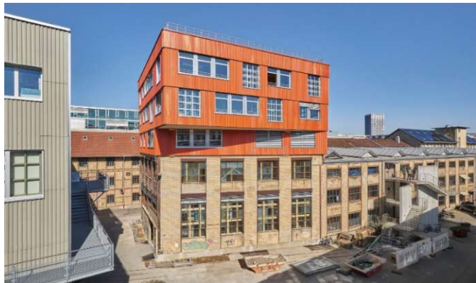
Abb. 2-21: Aufstockung des Kopfbaus der Halle 118 auf dem Winterthurer Sulzerareal
