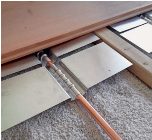
Abb. 4-12: Fußbodenheizungssystem im Trockenaufbau aus Kupferrohren und aufgesteckten Aluminiumwärmeleitblechen
