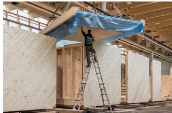
Abb. 2-52: Vorfertigung der Module in der Fabrik
