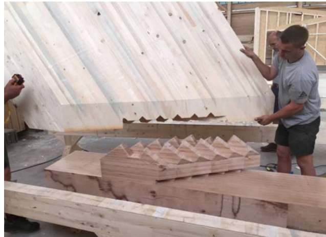
Abb. 2-55: Reversible Steckverbindung der Fassadenelemente
