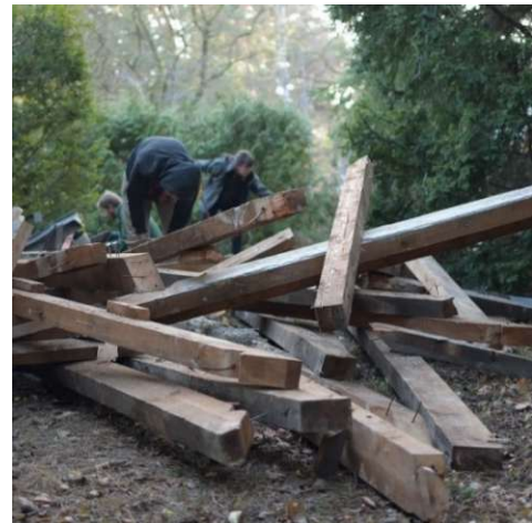
Abb. 2-43: Re-use des Holzes eines alten Dachstuhls
