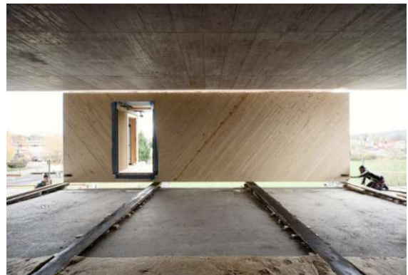
Abb. 2-53: Montage der vorgefertigten Unit
