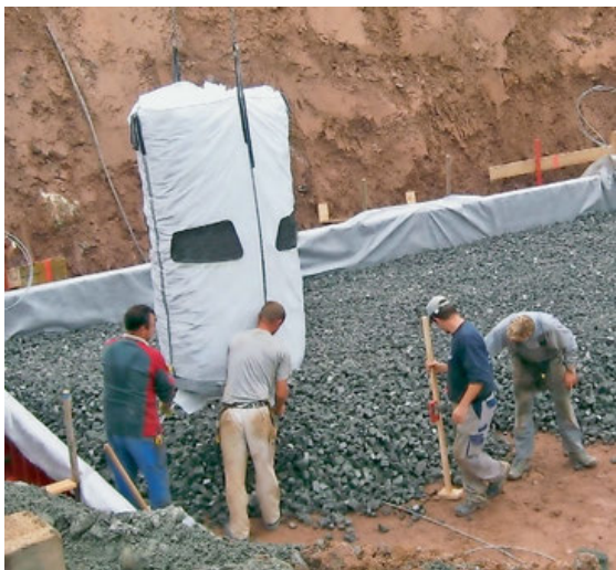
Abb. 4-9: lastabtragende und kapillarbrechende Dämmung unter Bodenplatten aus Recycling-Schaumglas: links als verdichteter Schotterkoffer
