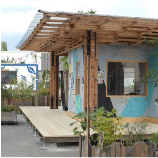
Abb. 2-42: Fertiggestellte Infozentrale am Vollgut
