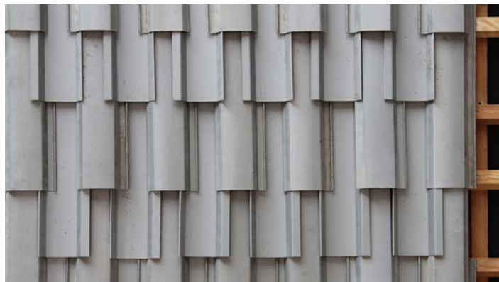
Abb. 4-3: Fassadenpaneel aus Aluminium-Lamellen alter Jalousien
