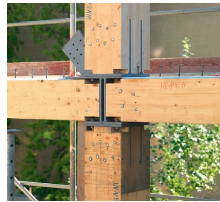
Abb. 4-6: Anschluss Primärträger an Stützen über Stahlteile
