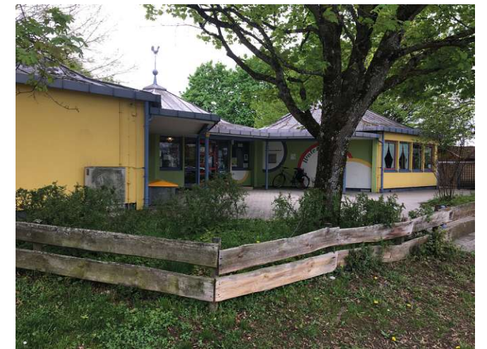
Abb. 16 Bestandskindergarten Eingang (eigene Aufnahme)
