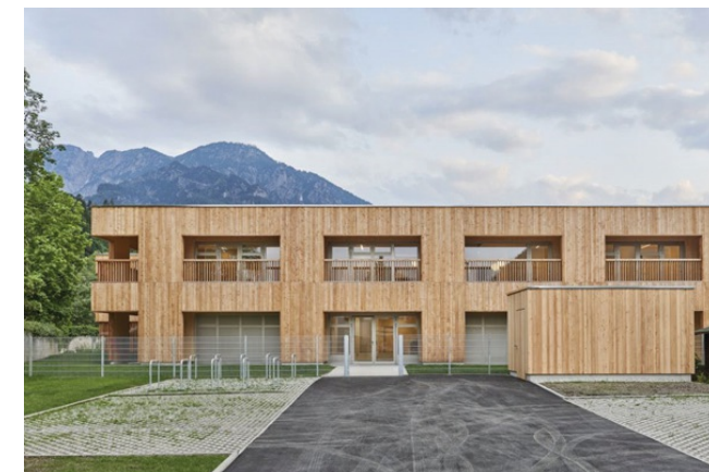
Abb. 13 Neubau einer Kindertagesstätte (Quelle: Sommer, S. a, o.D., Bild 3)
