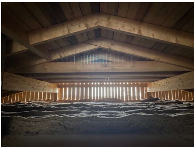
Abbildung 18: Neubau in Gols, Dachboden mit Schafwolle (eigene Aufnahme)
