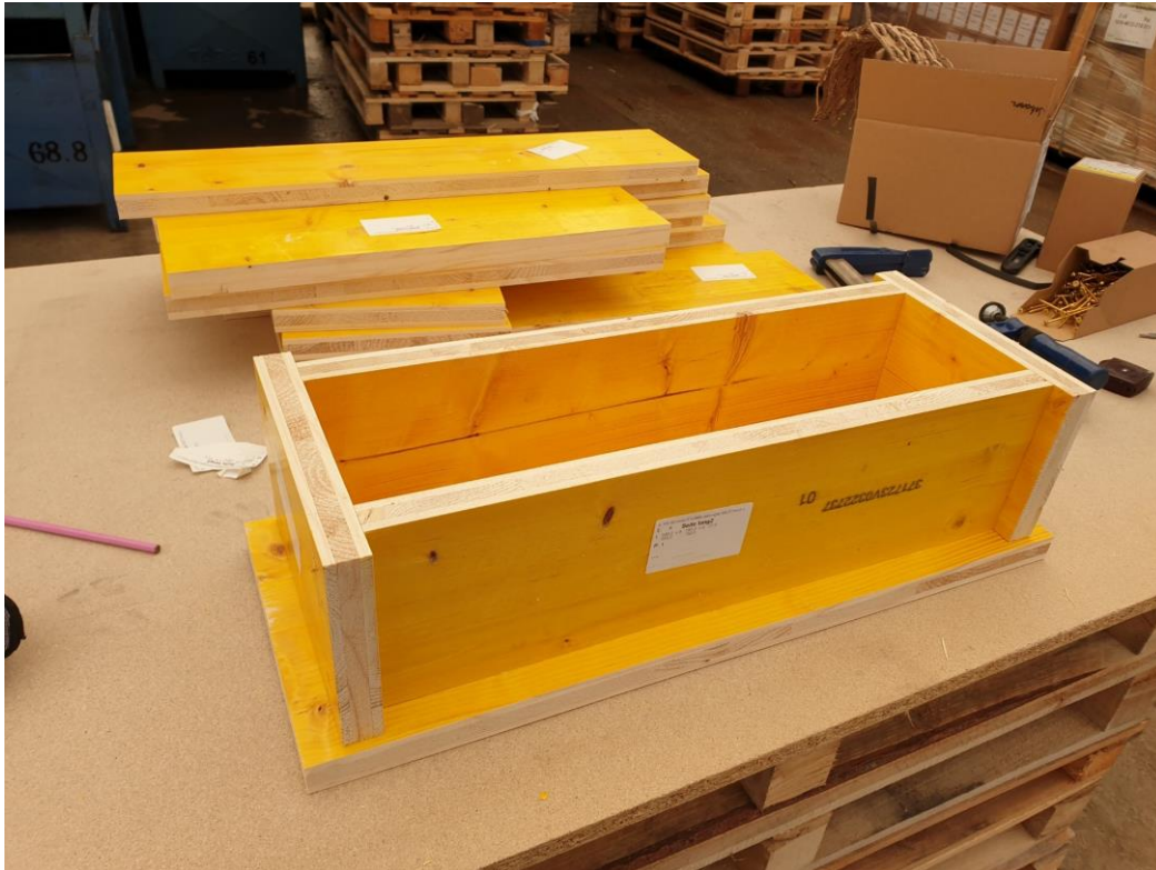
Abbildung A.1: Herstellung der Schalung
