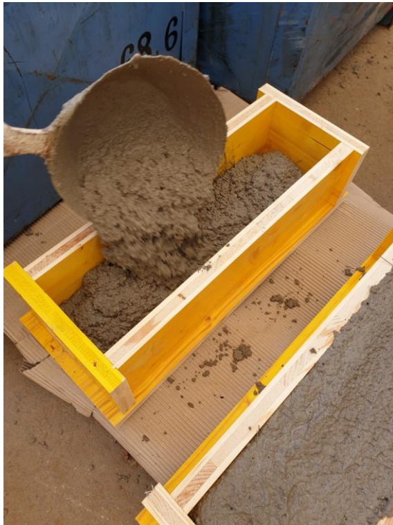
Abbildung A.3: Befüllen der Schalungen mit Faserbeton
