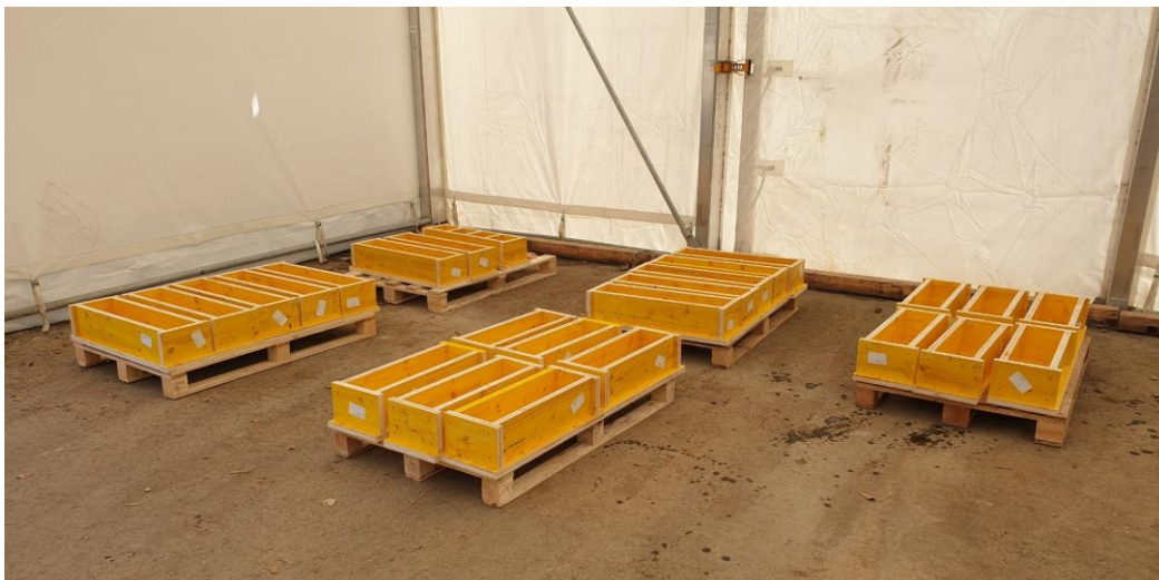
Abbildung A.2: Vorbereitete fertige Schalungen
