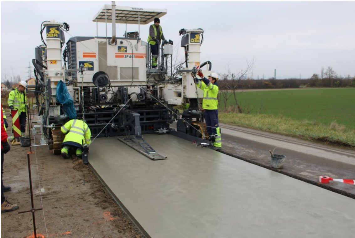
Abb. 4.6: Betondeckeneinbau (Eberhardtsteiner, et al., 2020)
