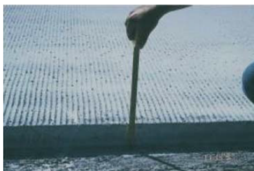
Abb. 2.14: Kammtextur auf fertigen UTW-Belag (Riffel, S.)
