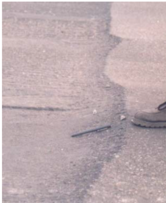
Abb. 2.12: abgefräster (links) und bestehender (rechts) Asphalt (Riffel, HeidelbergCement AG)
