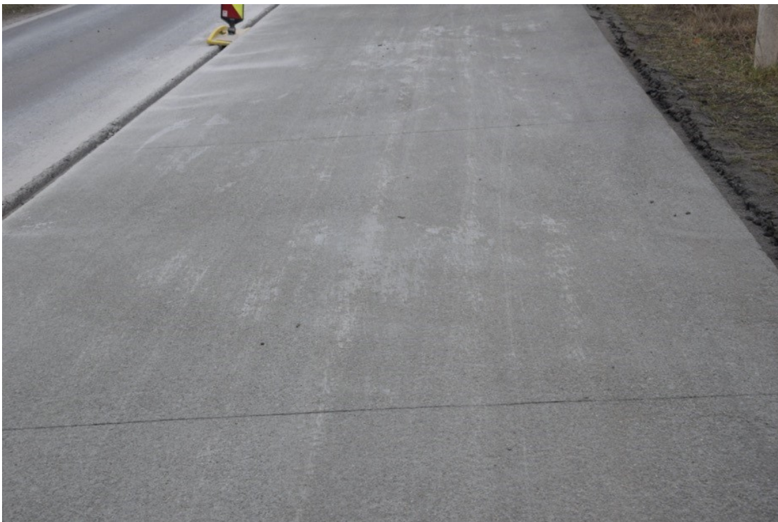
Abb. 4.7: Fertig gestellte Waschbetonoberfläche (Eberhardtsteiner, et al., 2020)
