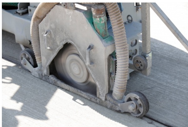
Abb. 2.13: Schneiden einer Querfuge im Frischbeton
