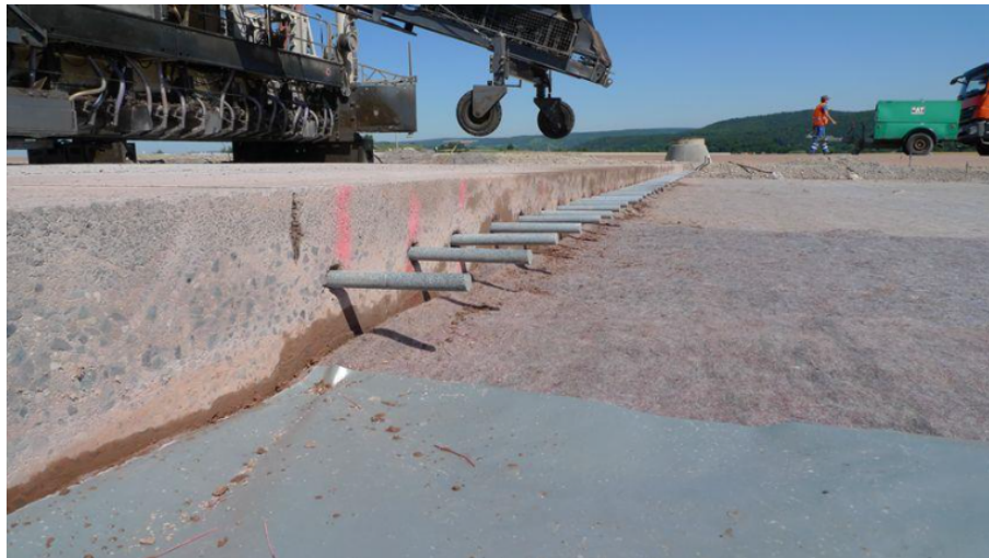
Abb. 2.5: Einbau von Dübel (Pichottka, 2019)
