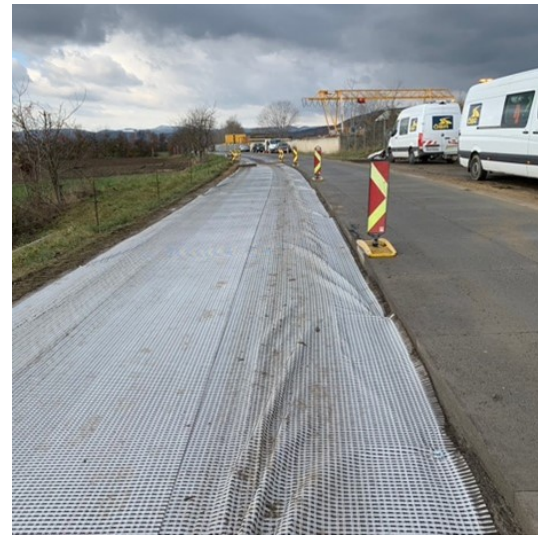
(b) Ten Cate polyfelt PGM B 100/200 (Basalt/Glasfaser-verstärktes Vlies)
