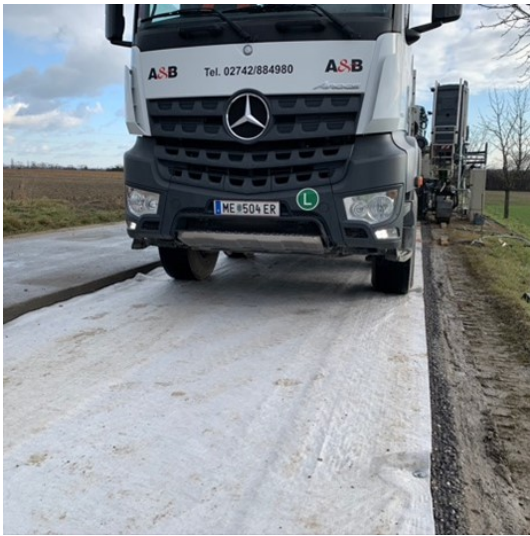
(a) Ten Cate polyfelt P50 (PP-Endlosfaservlies mit 500 g/m 2 )
