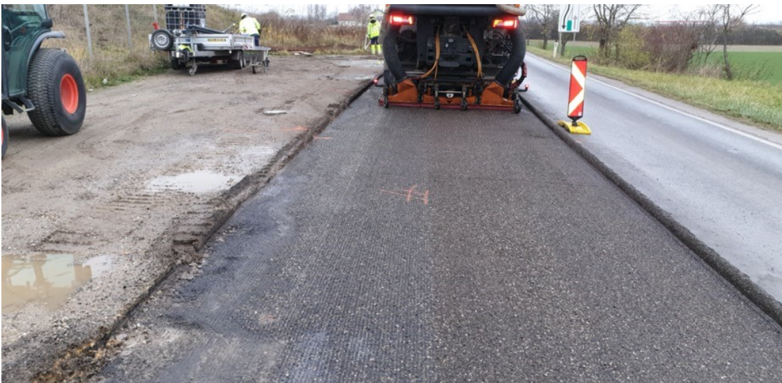
Abb. 4.5: Gefräste und gereinigte Asphaltfahrbahn (Eberhardtsteiner, et al., 2020)
