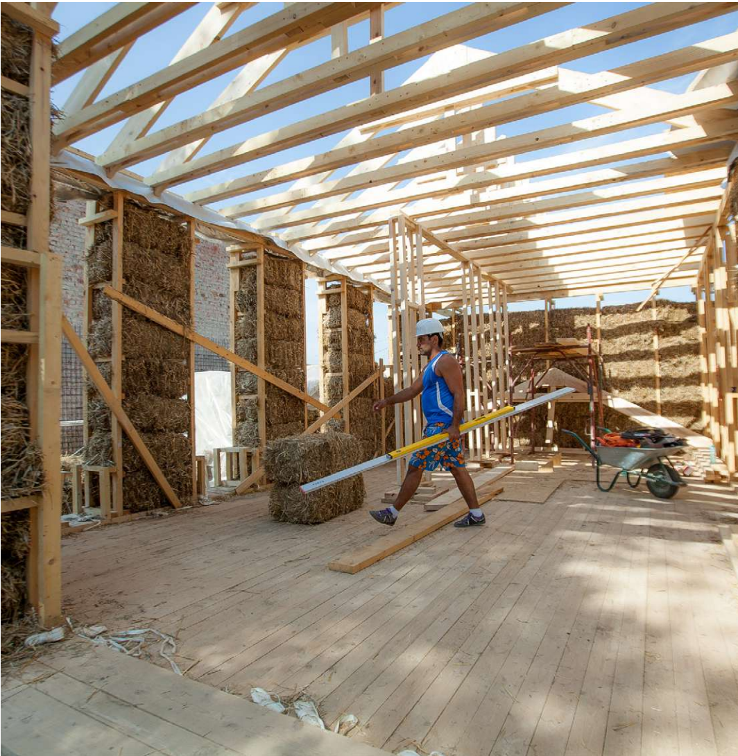
Abb. 14 Strohballeneinbau durch Volontäre
