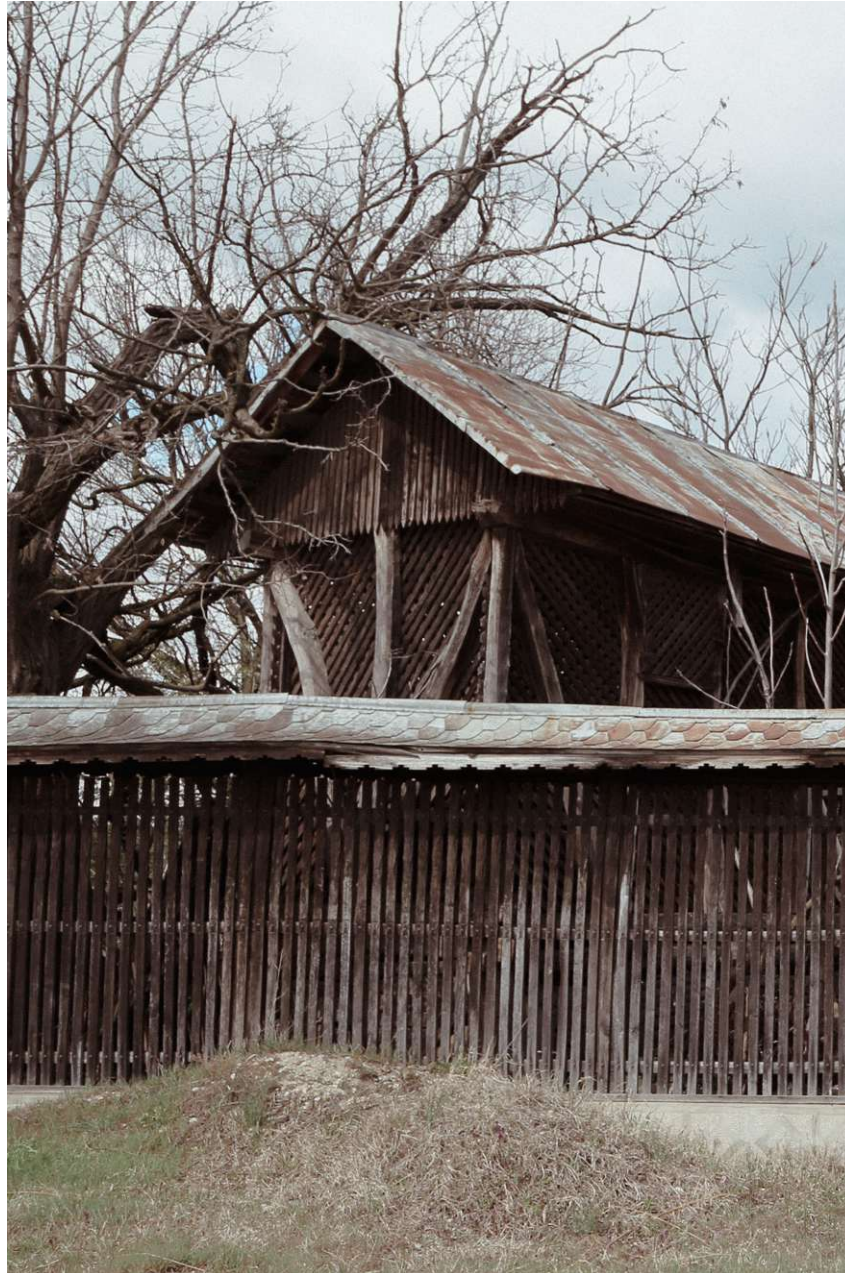
Abb. 57 Speicherbau im vorderen Hof platziert
