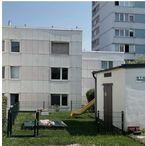
Abb. 36: Artur Perotti, Rückseite Gebäudekomplex, 1956, 2021.
