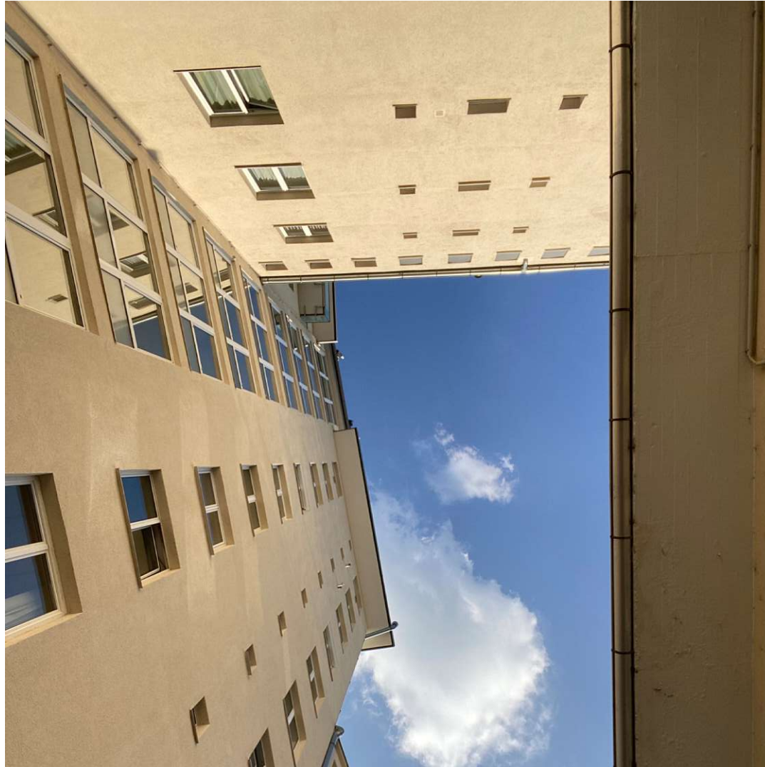
Abb. 26: Artur Perotti, Ederhochhaus Innenhof, 1956, 2021.
