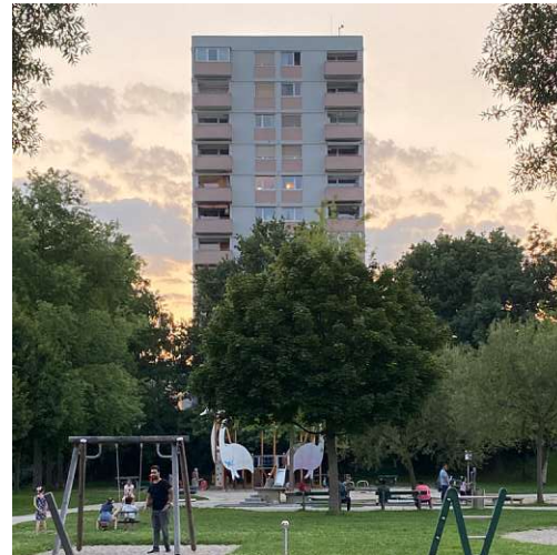
Abb. 65: Artur Perotti, höchstes Gebäude, 1962, 2021.
