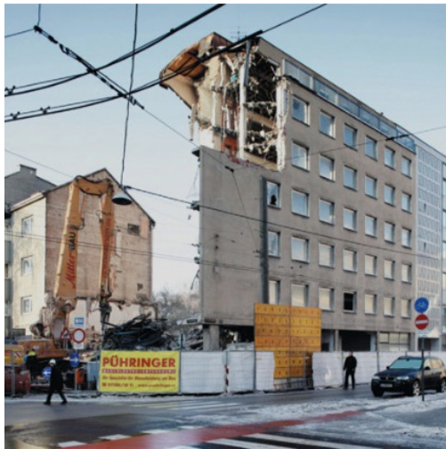
Abb. 10: Artur Perotti, Abriss VHS 2010.
