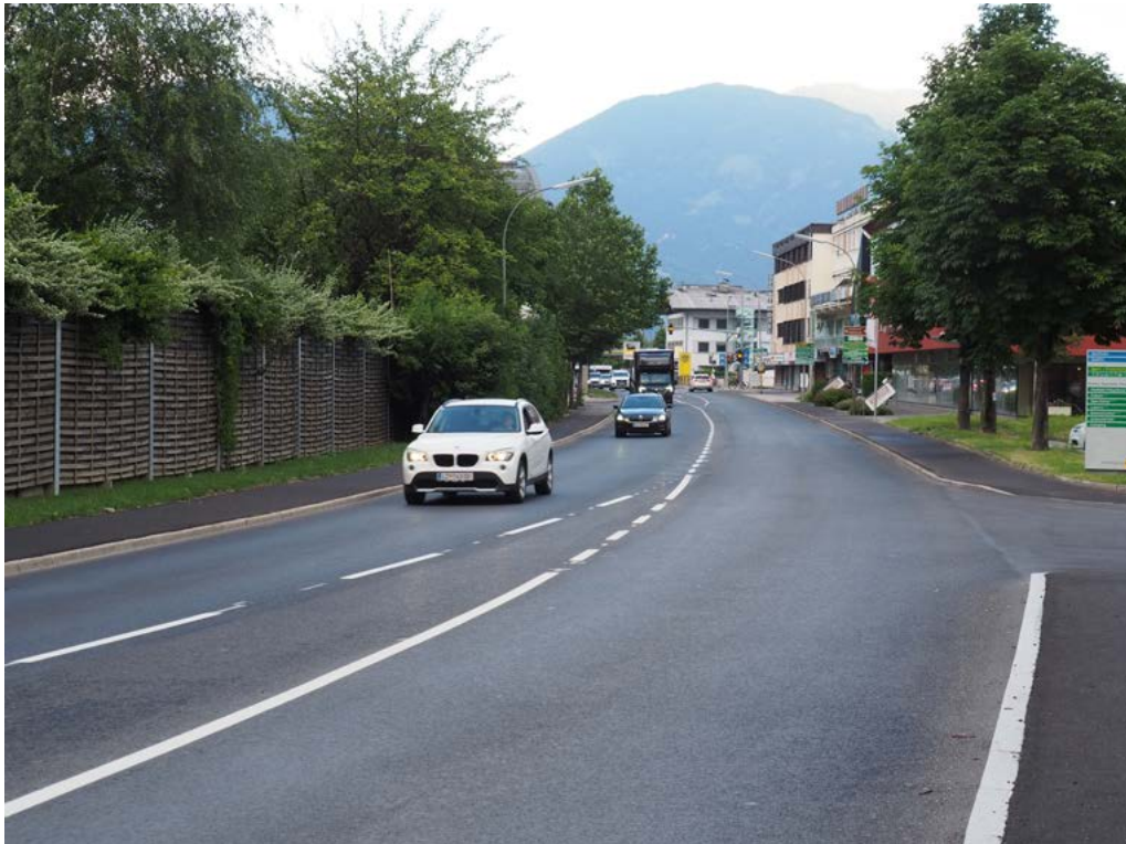
Abb. 49 Die B100 zerschneidet das Fokusgebiet »Äußeres Zentrum bis Innere Peripherie«.
