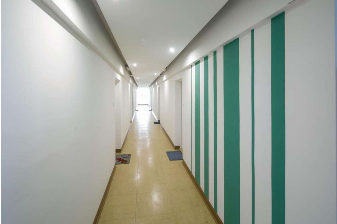
Abbildung 17: Gangflächen nach der Sanierung (eigene Aufnahme)
