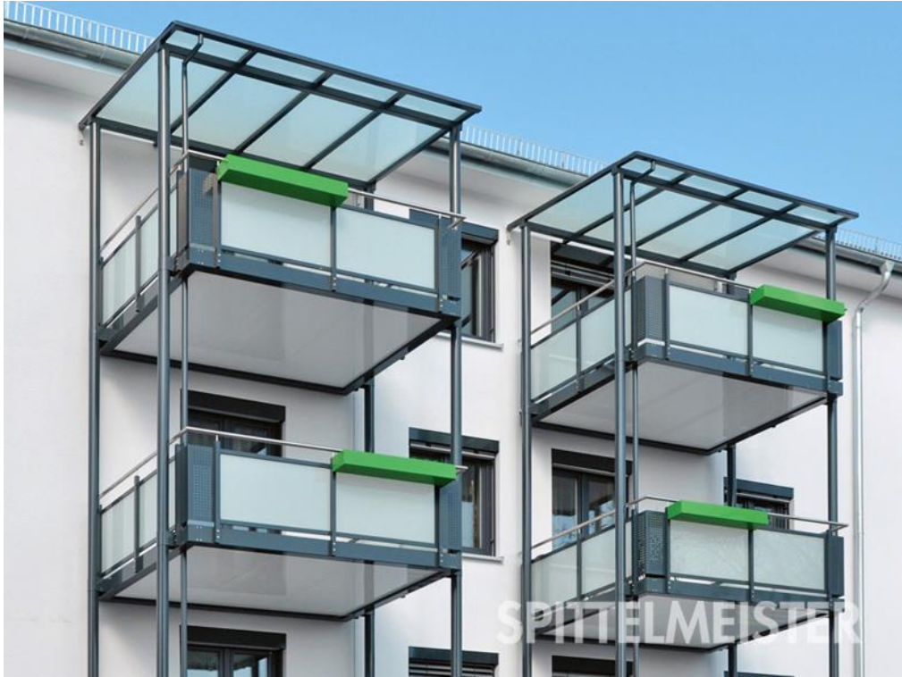
Abbildung 14: Vorbaubalkon mit Dach komplett aus Alu (Vorstellbalkone – Balkonbuchreferenzen Fa. Spittelmeister 2020)
