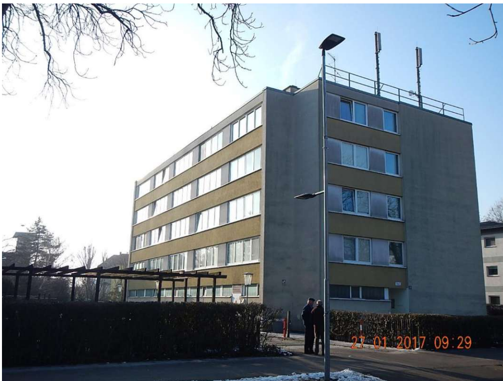
Abbildung 19: Straßenansicht vor der Sanierung (eigene Aufnahme)
