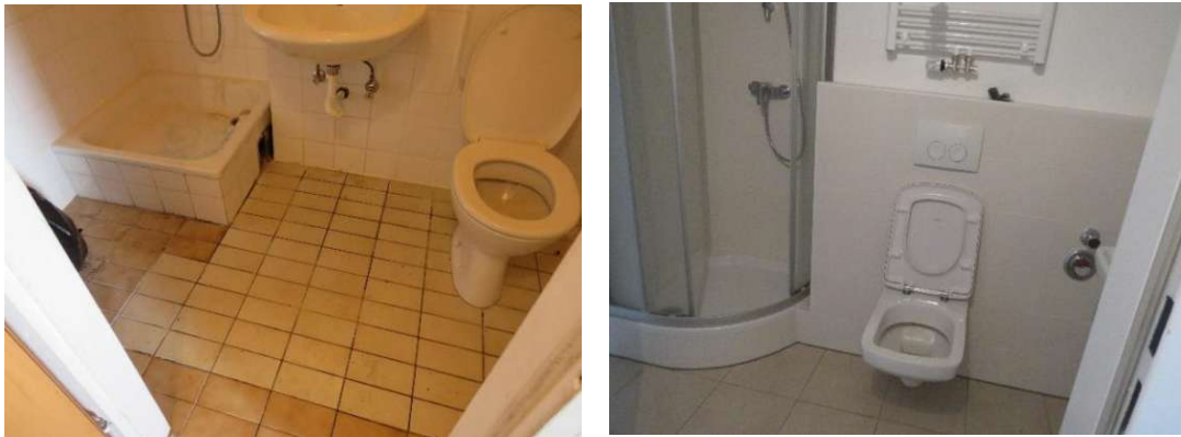
Abbildung 3: Sanitärräume Baujahr 1971 vor und nach Sanierung (eigene Aufnahmen)
