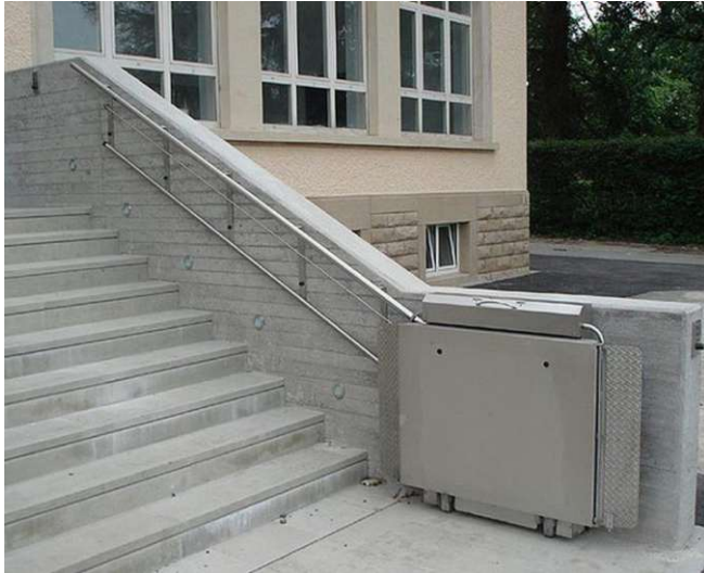
Abbildung 12: Treppenlift vom Gehsteigniveau ins Erdgeschoß ( www.ktt.de/lifte/qt120-plattformlift )
