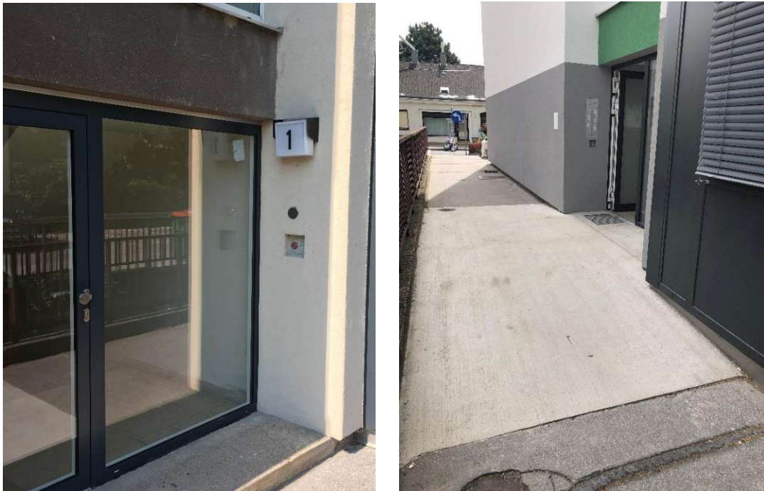
Abbildung 10: Rampen als Ersatz der Vorlegestufe, zur barrierefreien Erreichbarkeit des Erdgeschosses/ersten Aufzugsniveaus (eigene Aufnahmen)
