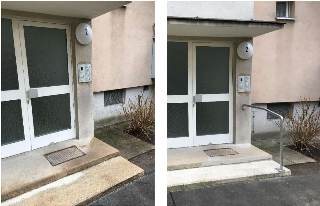
Abbildung 11: Ergänzung des Hauszuganges durch einen Handlauf (eigene Aufnahmen)
