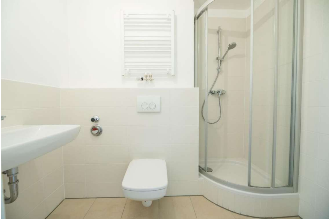
Abbildung 18: Badezimmer nach der Sanierung (eigene Aufnahme)
