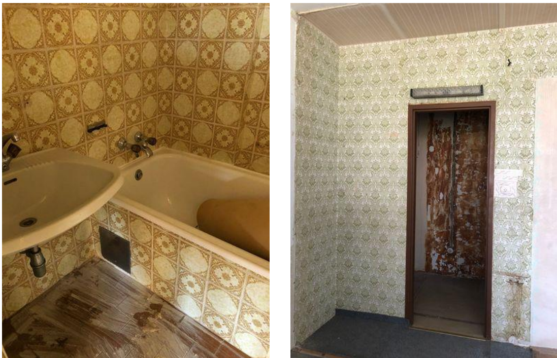
Abbildung 2: Originalzustand Sanitärräume und Wohnung mit Schrankraum Baujahr 1970 (eigene Aufnahmen)
